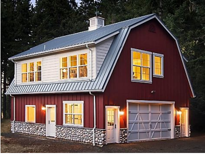
Рисунок 1.7 – Будівля з мансардним дахом
