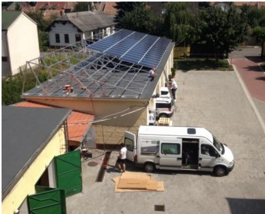
Рис.6 Приклад встановлення конструкції типу «фальш-скат»
