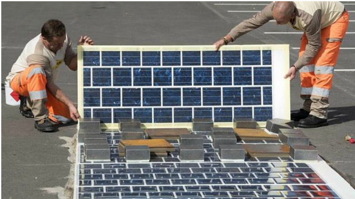
Рисунок 7.6 – Монтаж дорожнього покриття Wattway з вбудованими сонячними панелями
