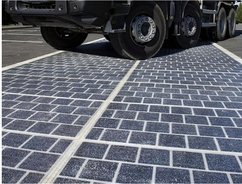
Рисунок 7.5 – Дорожнє покриття Wattway з вбудованими сонячними панелями
