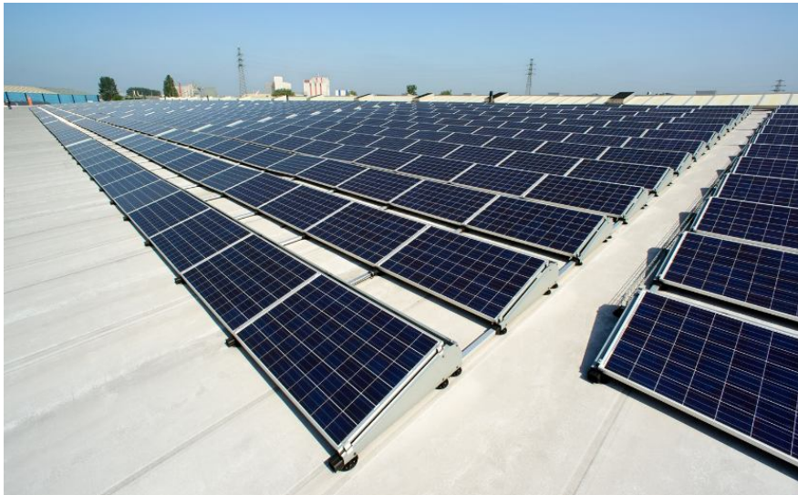
Рис. 7. Утримуюча конструкція типу FlatFix Fusion.
