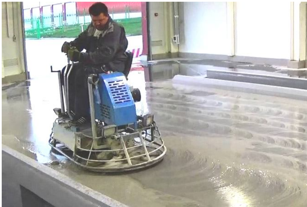
Рисунок 7.11 – Шліфування поверхні монолітних підлог оздоблювальними машинами
