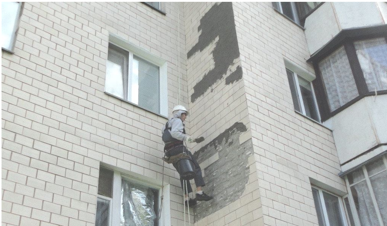
Рисунок 7.2 – Ремонт облицювання фасадів
