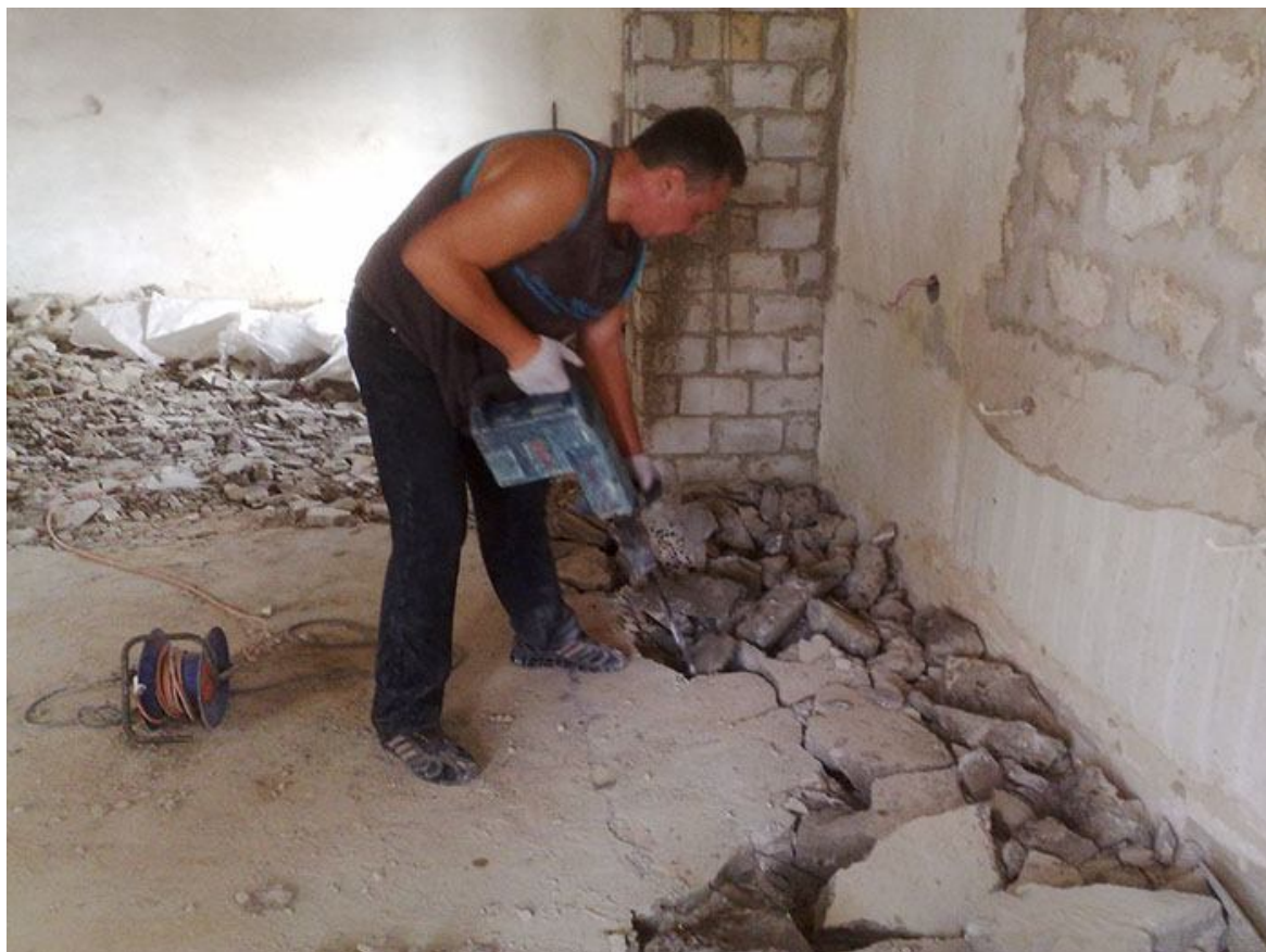
Рисунок 8.9 – Розпушування цементної стяжки за допомогою відбійного молотка
