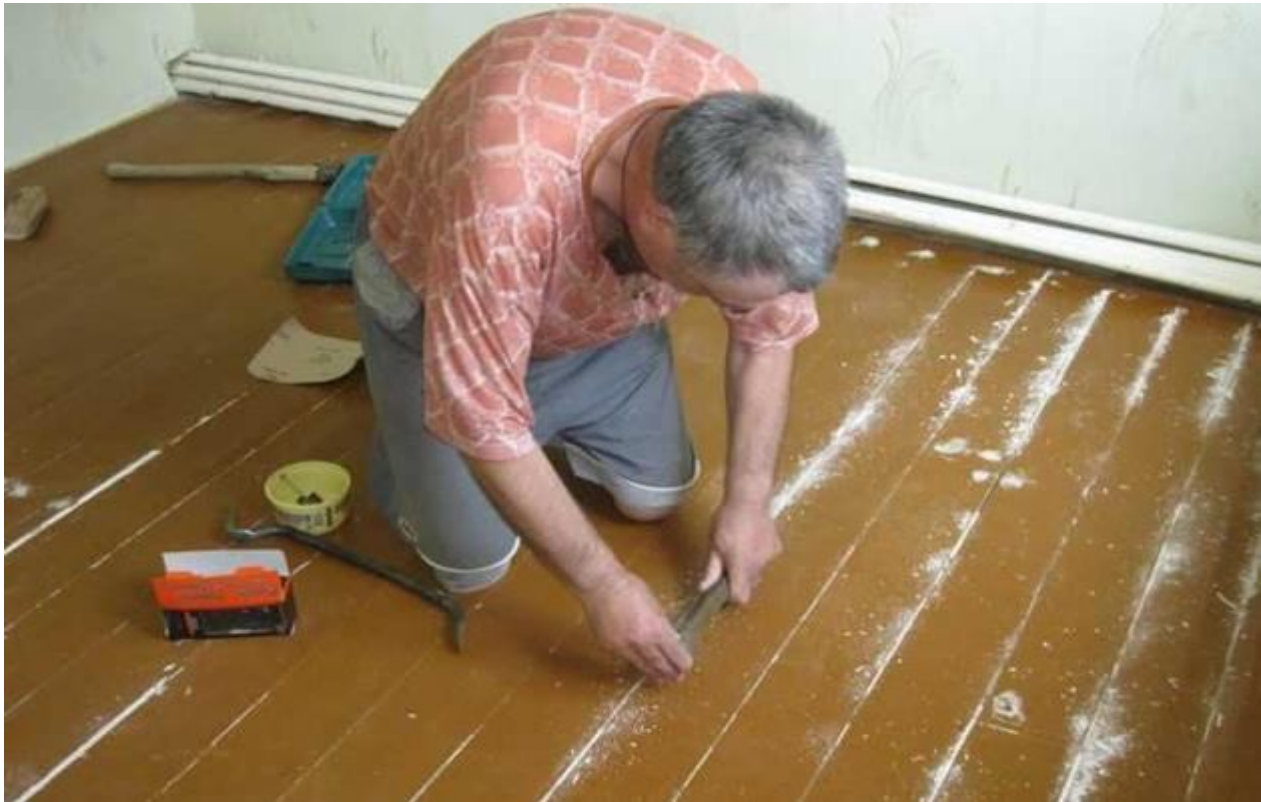
Рисунок 7.13 – Ремонт дощатих підлог
