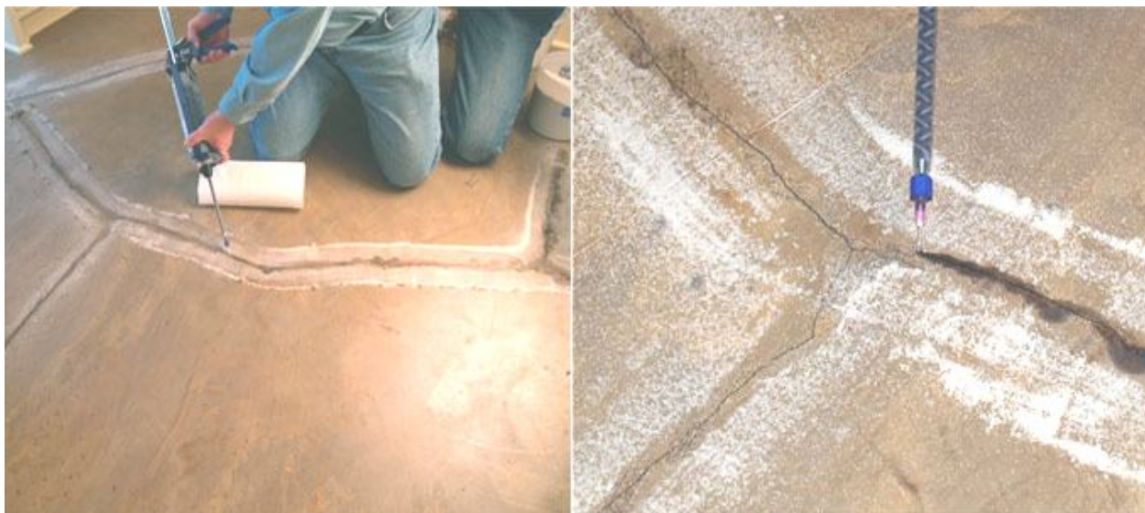
Рисунок 7.10 – Відновлення монолітних підлог
