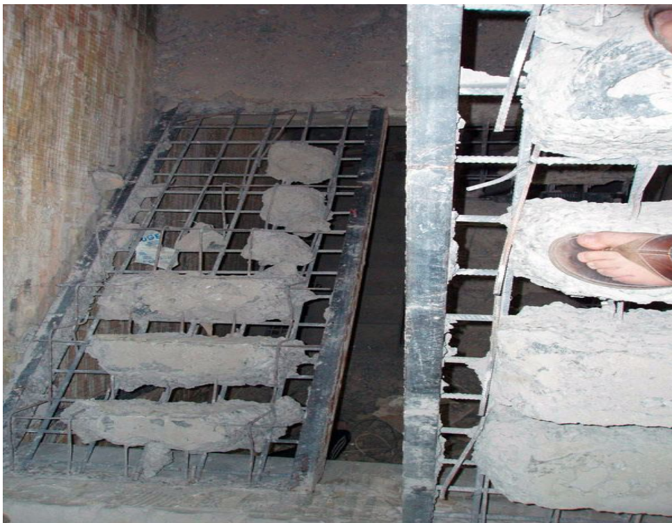
Рисунок 8.14 – Розбирання сходів, укладених по сталевих косоурах
