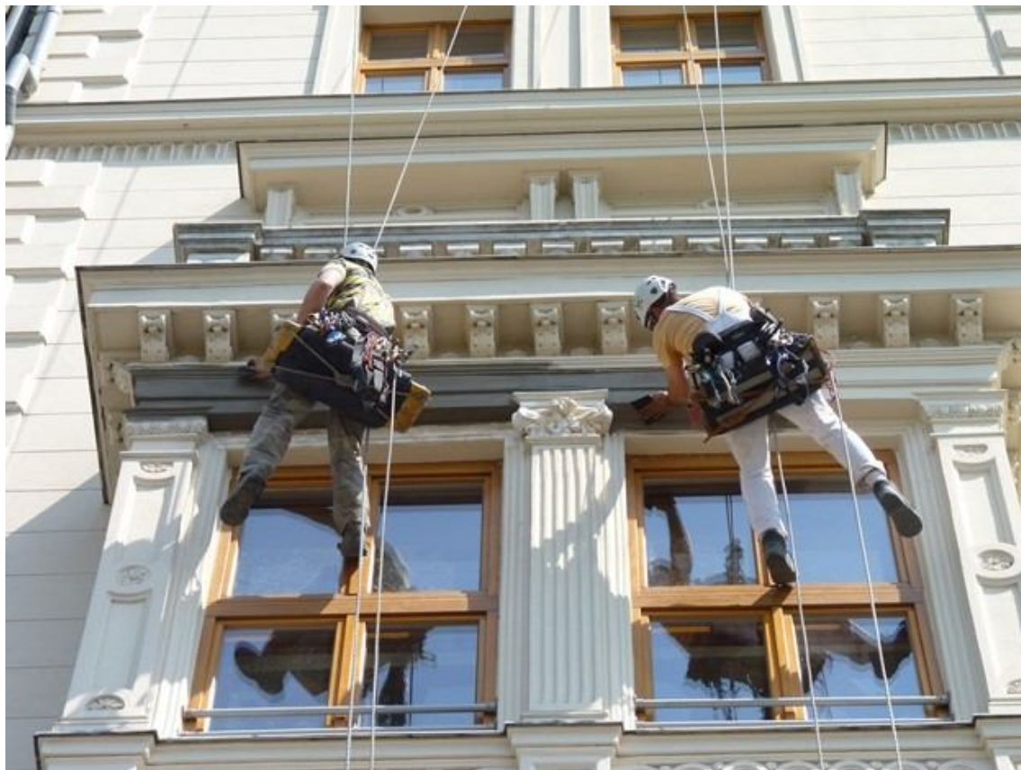
Рисунок 7.1 – Ремонт штукатурки стін фасадів
