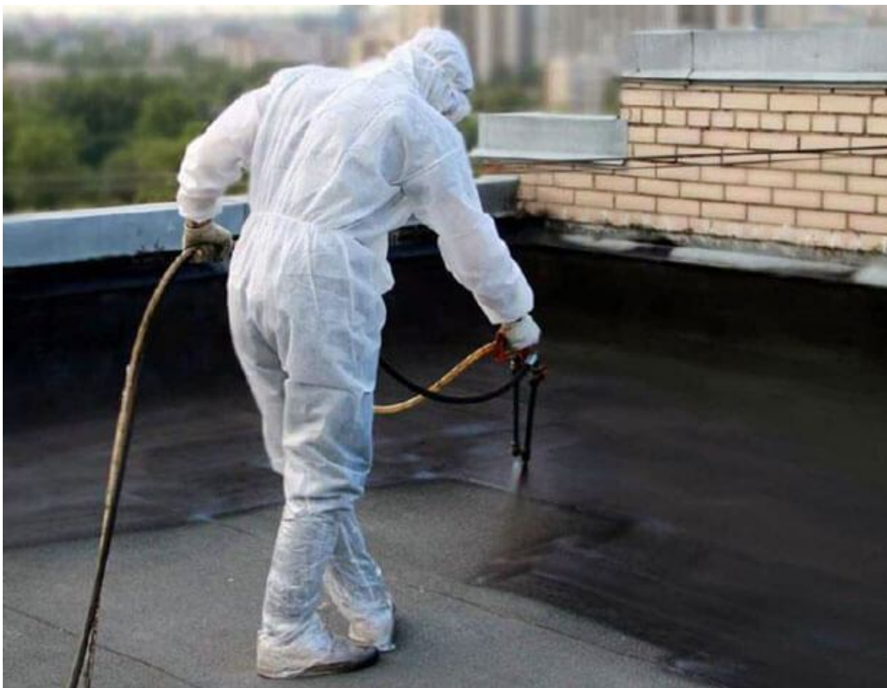
Рисунок 4.4 – Нанесення мастики за допомогою вудки-розпилювача
