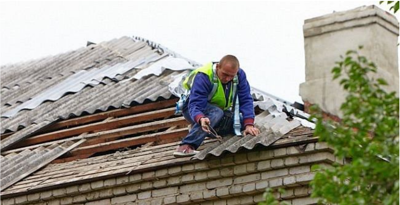
Рисунок 8.2 – Розбирання покриттів з хвилястих азбестоцементних листів
