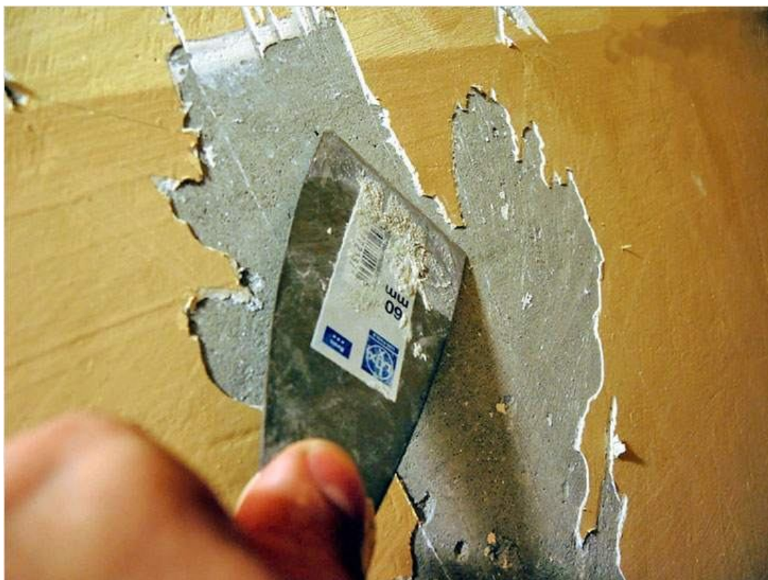
Рисунок 7.6 – Видалення пошкодженого забарвлення стін
