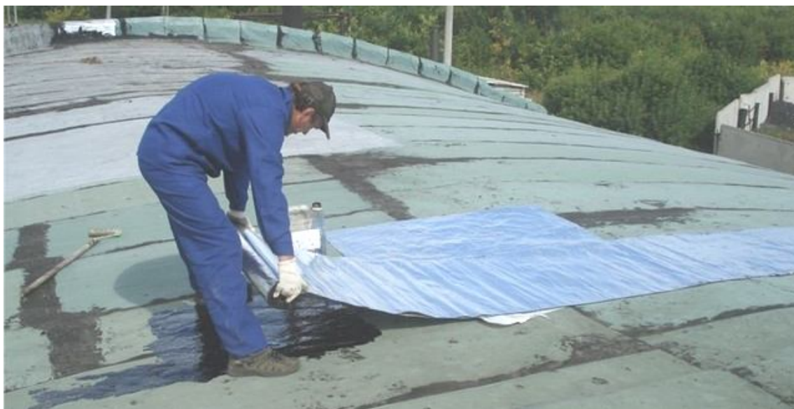
Рисунок 4.2 – Латочний ремонт покрівель із рулонних матеріалів
