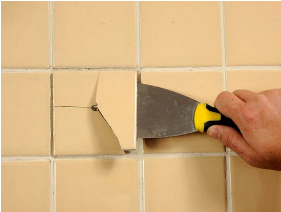
Рисунок 7.5 – Ремонт внутрішнього облицювання стін
