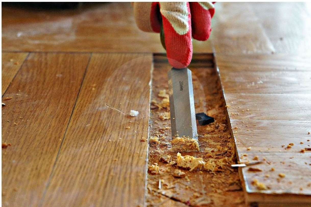
Рисунок 7.14 – Ремонт паркетних підлог
