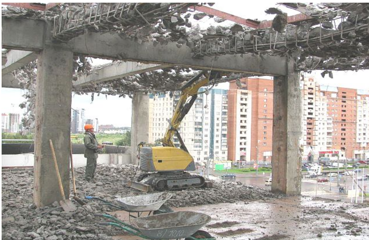
Рисунок 8.7 – Розбирання залізобетонних перекриттів
