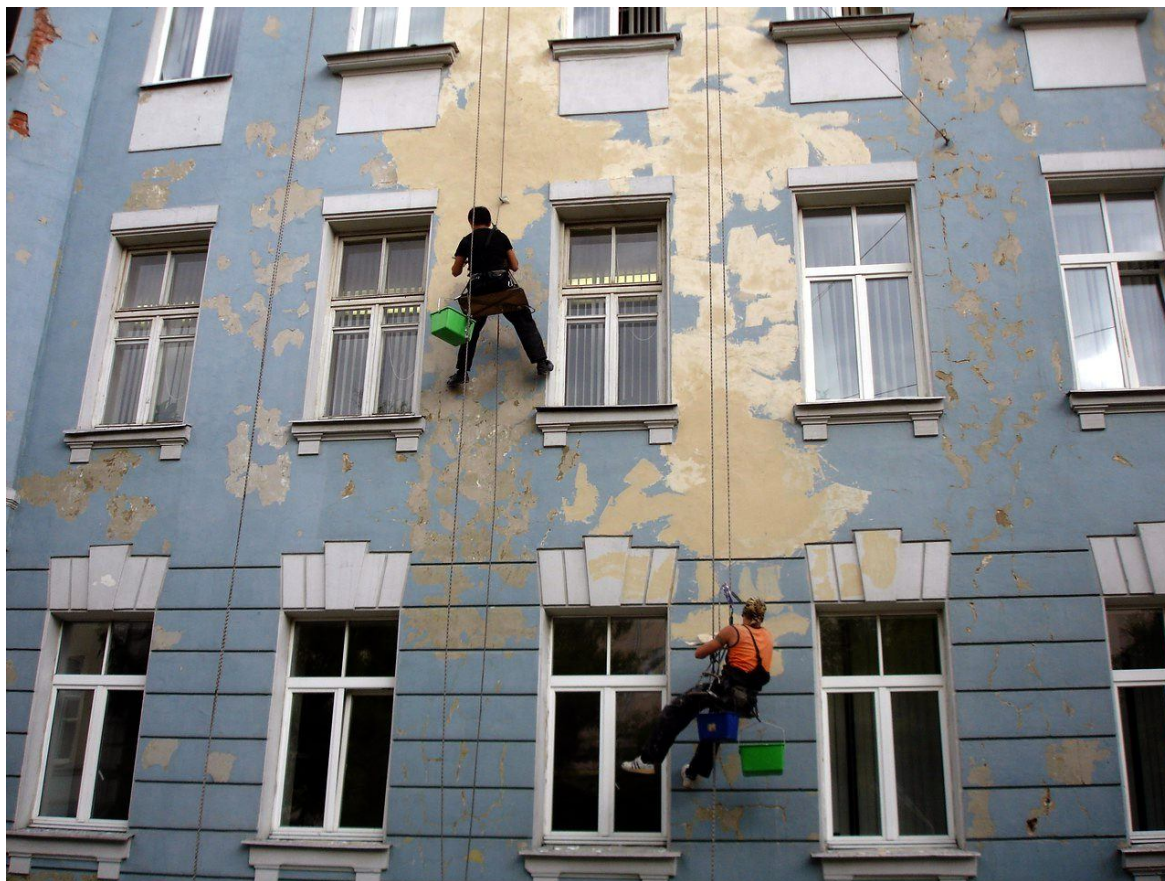
Рисунок 7.3 – Ремонт малярних покриттів фасадів
