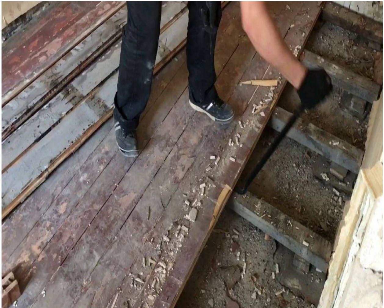
Рисунок 8.8 – Розбирання дощатої підлоги
