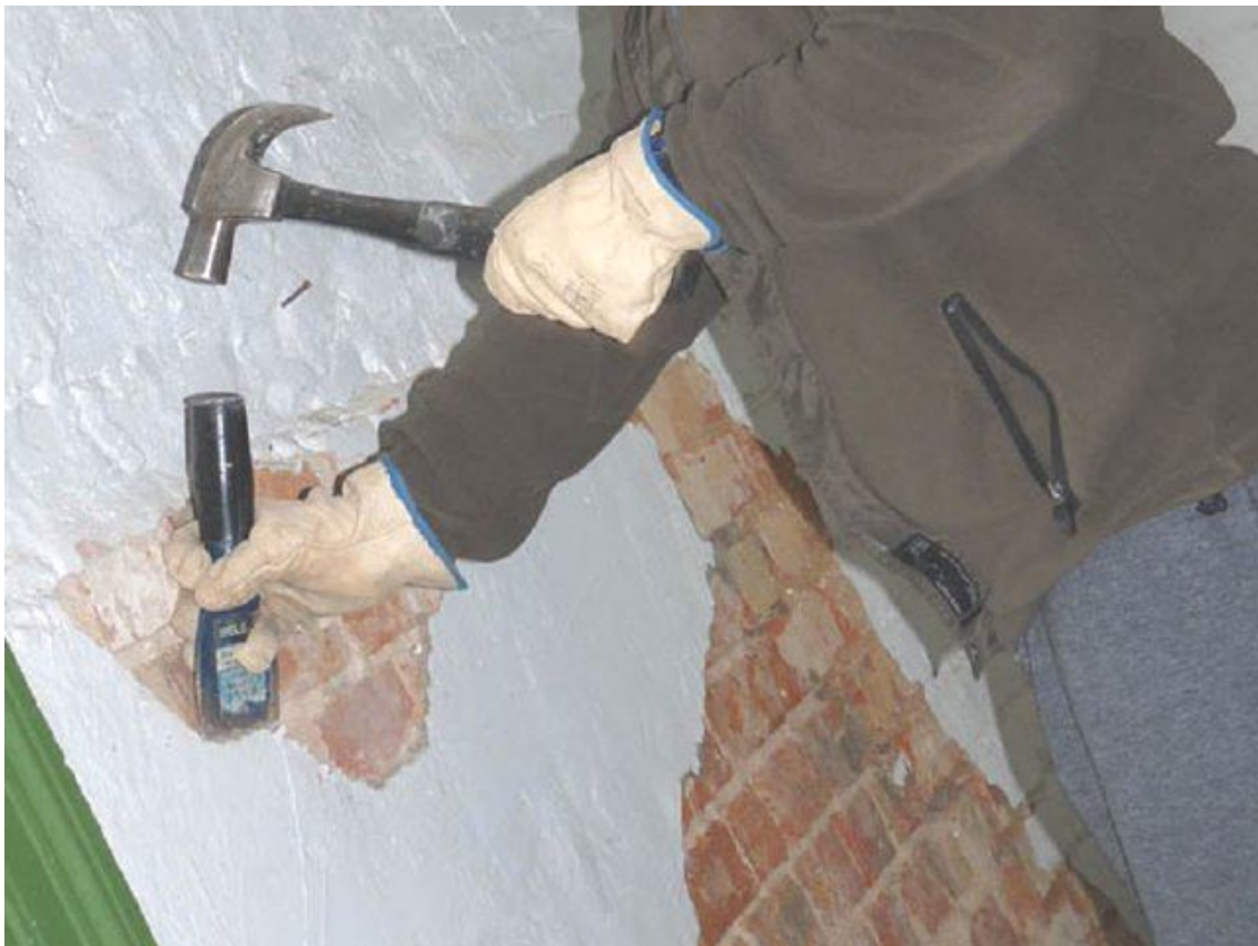
Рисунок 7.4 – Ремонт внутрішньої штукатурки стін
