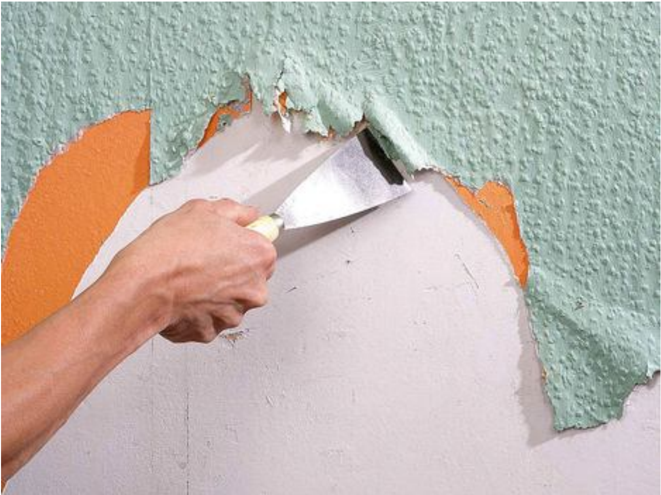
Рисунок 7.7 – Ремонт шпалерних покриттів
