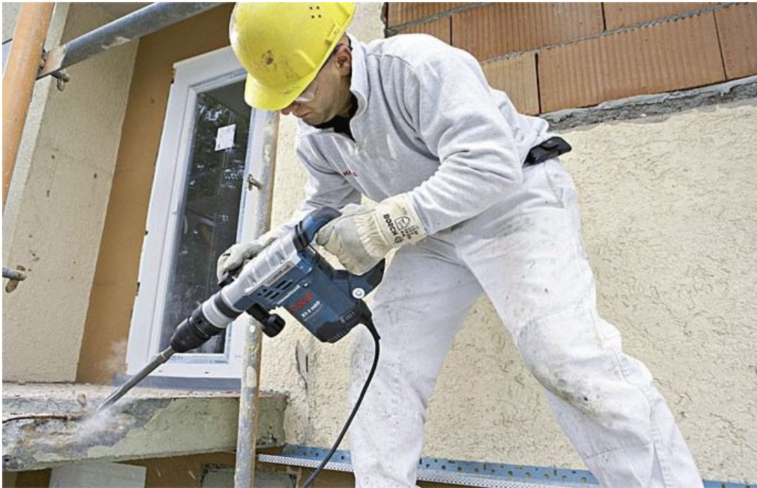
Рисунок 8.16 – Розбирання бетонних плит балконів
