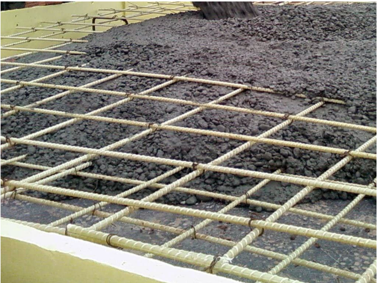
Рисунок 2.14 – Застосування АНК для армування підлог і плит по ґрунту
