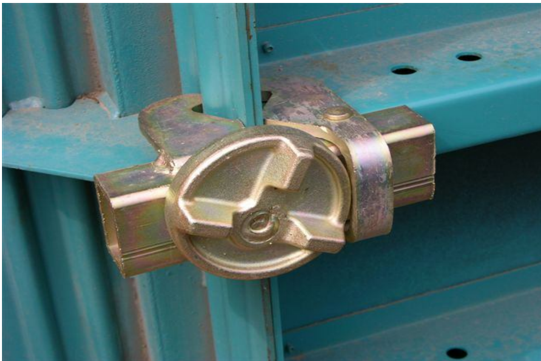
Рисунок 1.2 – Замок ексцентриковий
