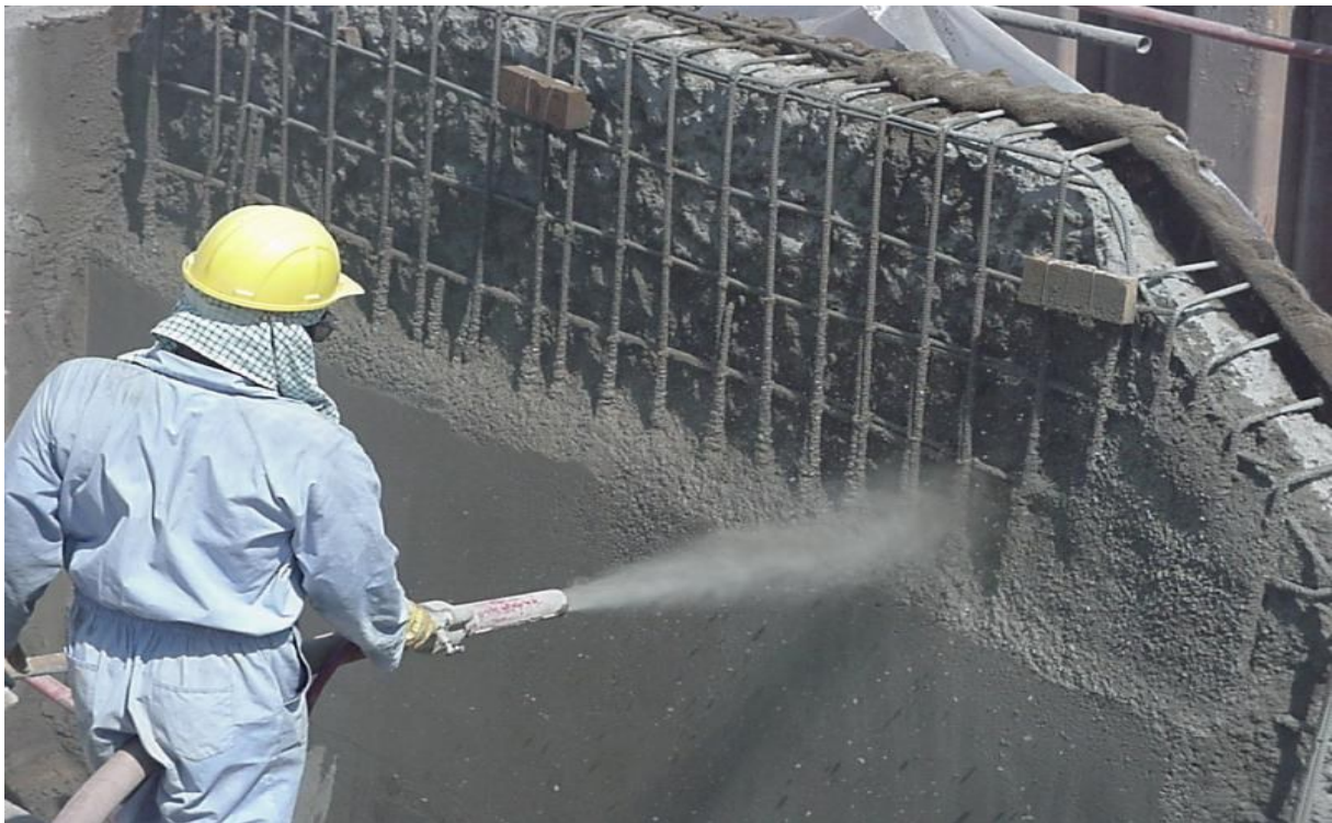
Рисунок 5.13 – Нанесення торкретного покриття
