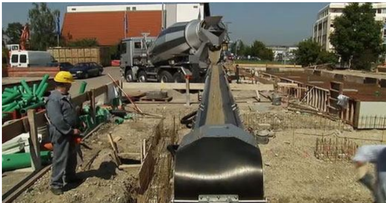
Рисунок 4.9 – Використання стрічкового конвеєра для укладання бетонної суміші
