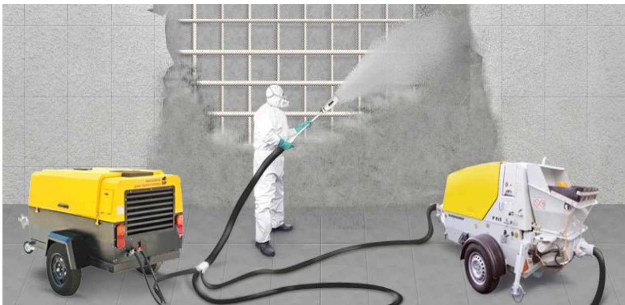
Рисунок 5.11 – Нанесення бетону на поверхню методом торкретування
