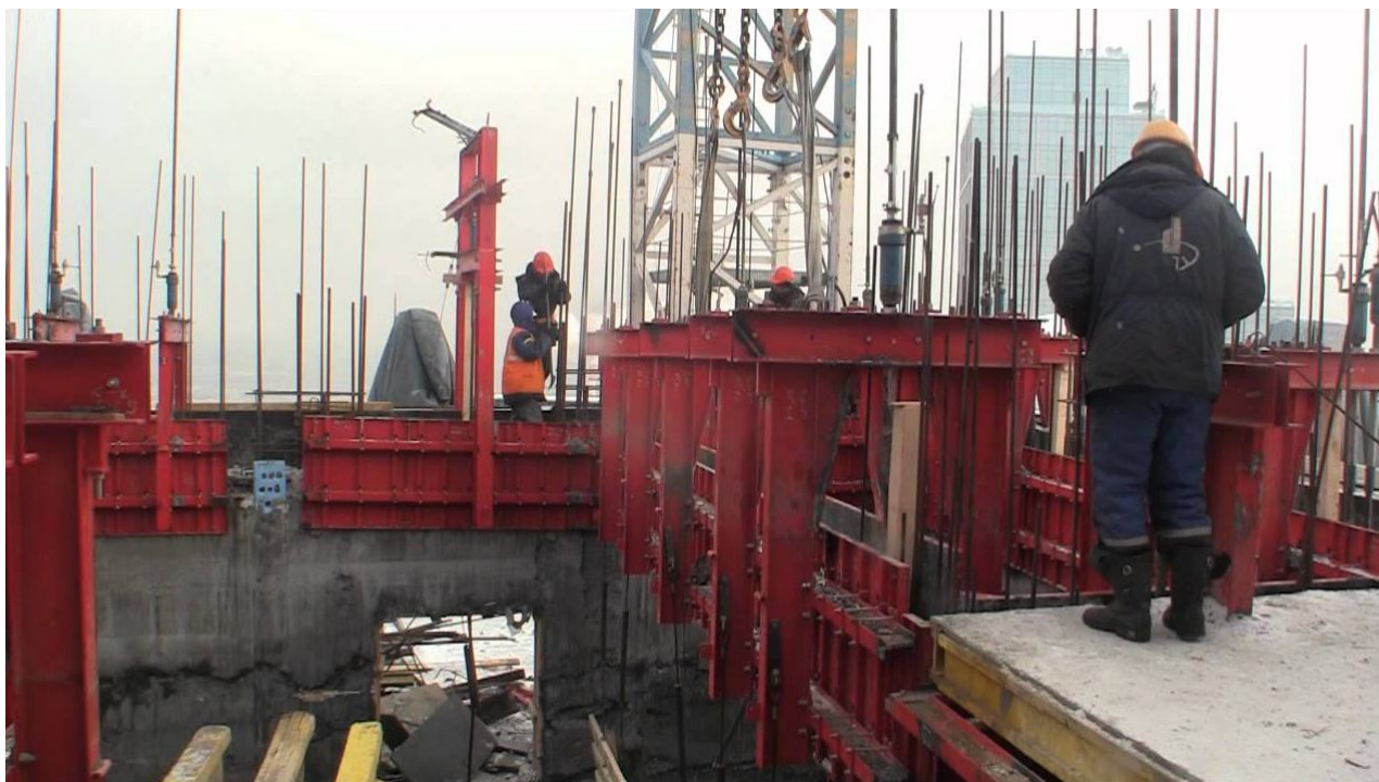
Рисунок 1.19 – Демонтаж ковзної опалубки
