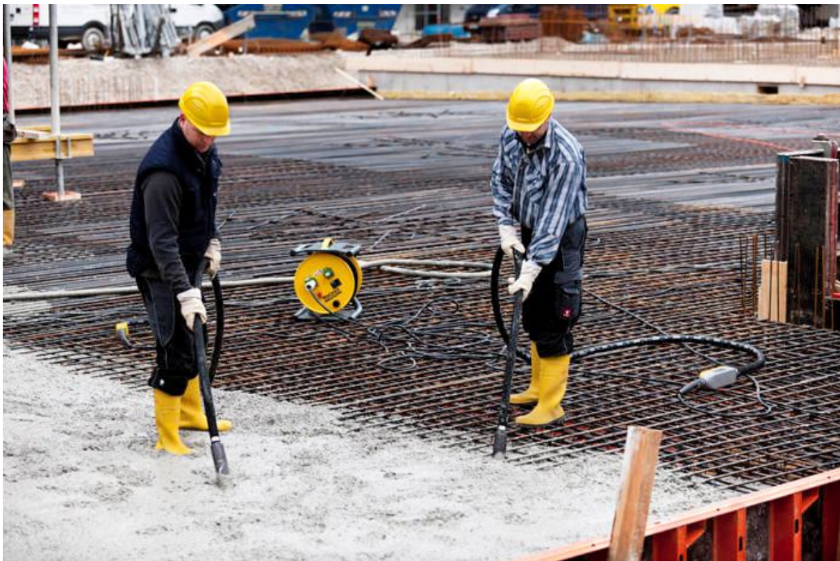
Рисунок 4.13 – Ущільнення бетону глибинним вібратором
