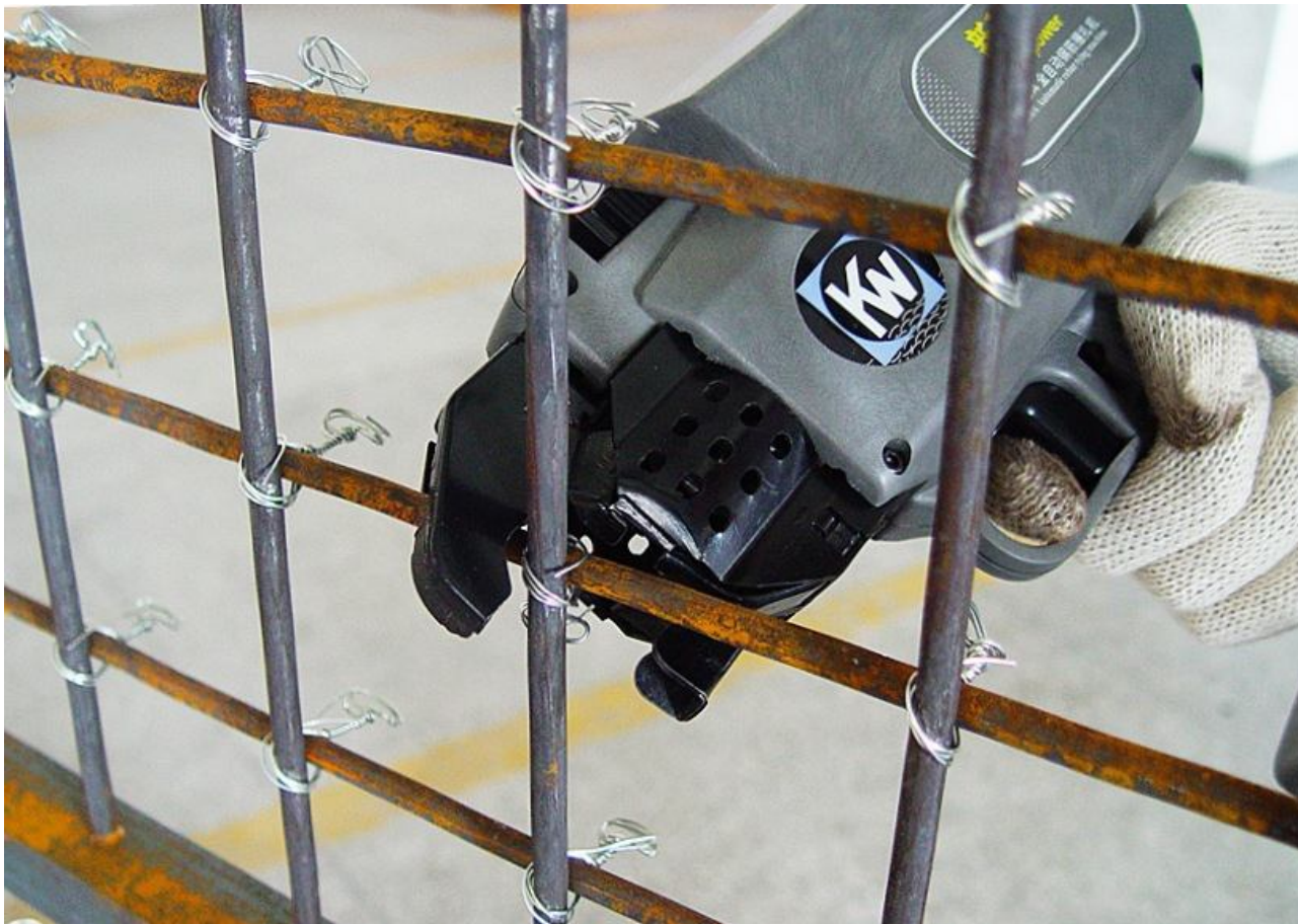
Рисунок 2.9 – Зв'язування арматури за допомогою акумуляторного пістолета
