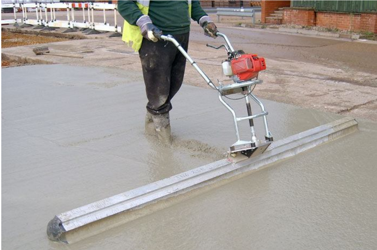
Рисунок 4.14 – Поверхнєве ущільнення бетону віброрейкою
