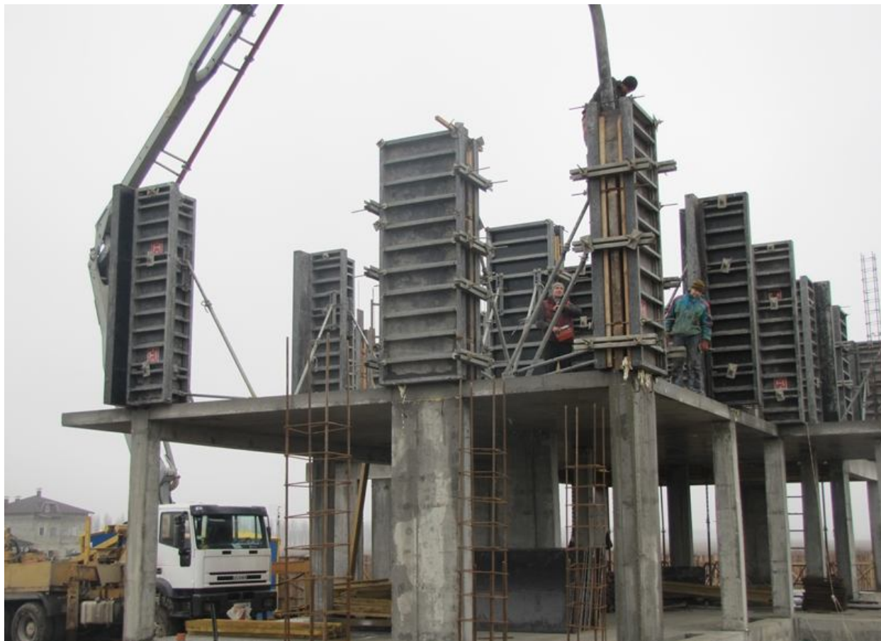
Рисунок 5.6 – Бетонування колон
