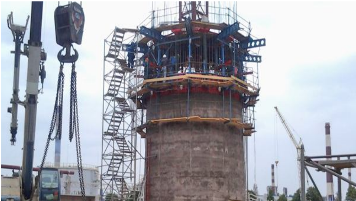
Рисунок 1.13 – Ковзна опалубка
