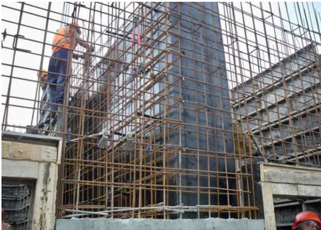
Рисунок 2.17 – Армуння вертикальних стін
