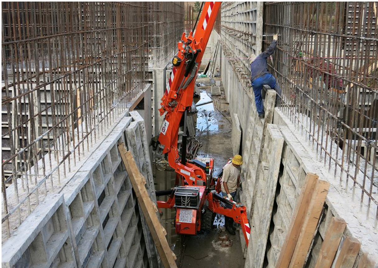
Рисунок 1.18 – Монтаж панелей опалубки
