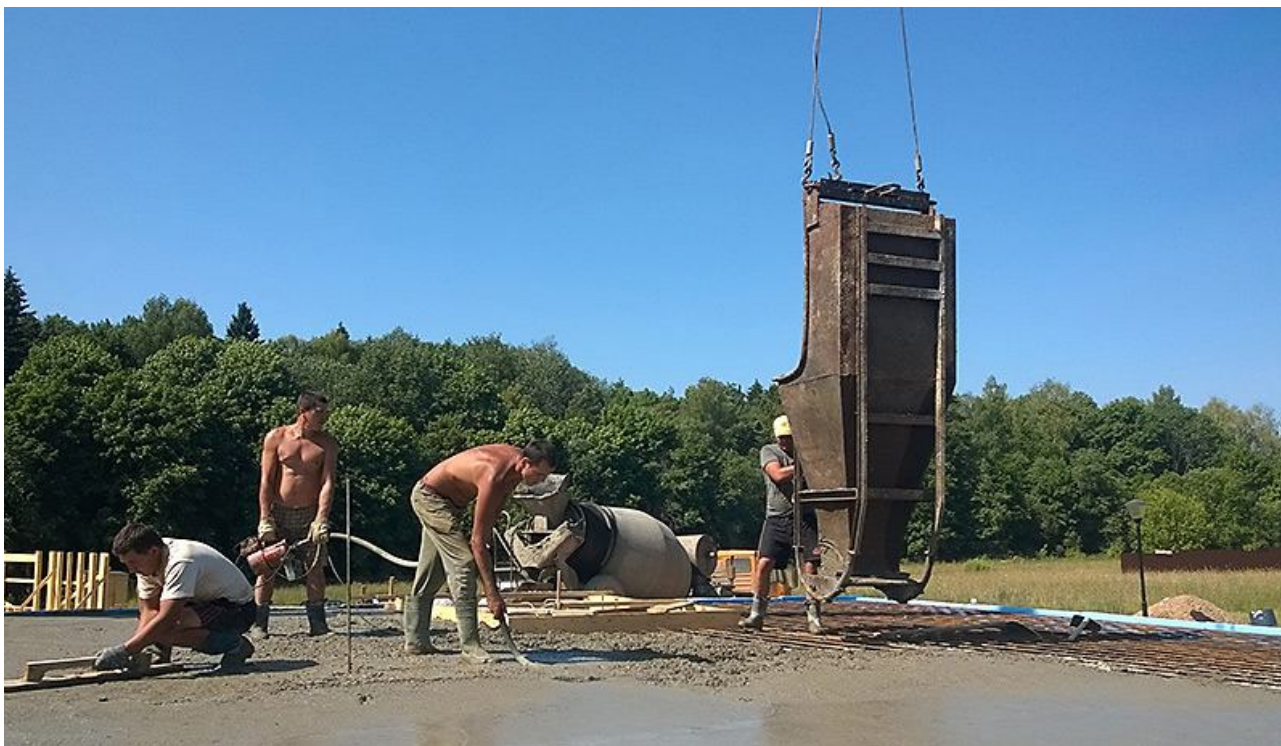
Рисунок 5.1 – Бетонування фундаментної плити за схемою «кран-баддя»
