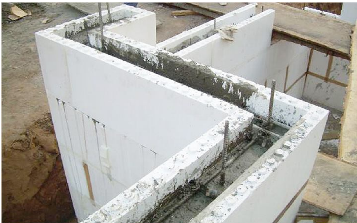
Рисунок 1.17 – Незнімна опалубка
