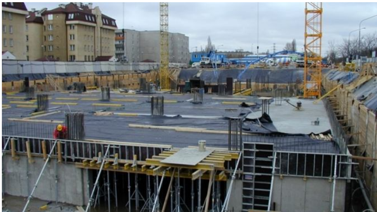
Рисунок 6.1 – Бетонування із застосуванням методу «термоса»
