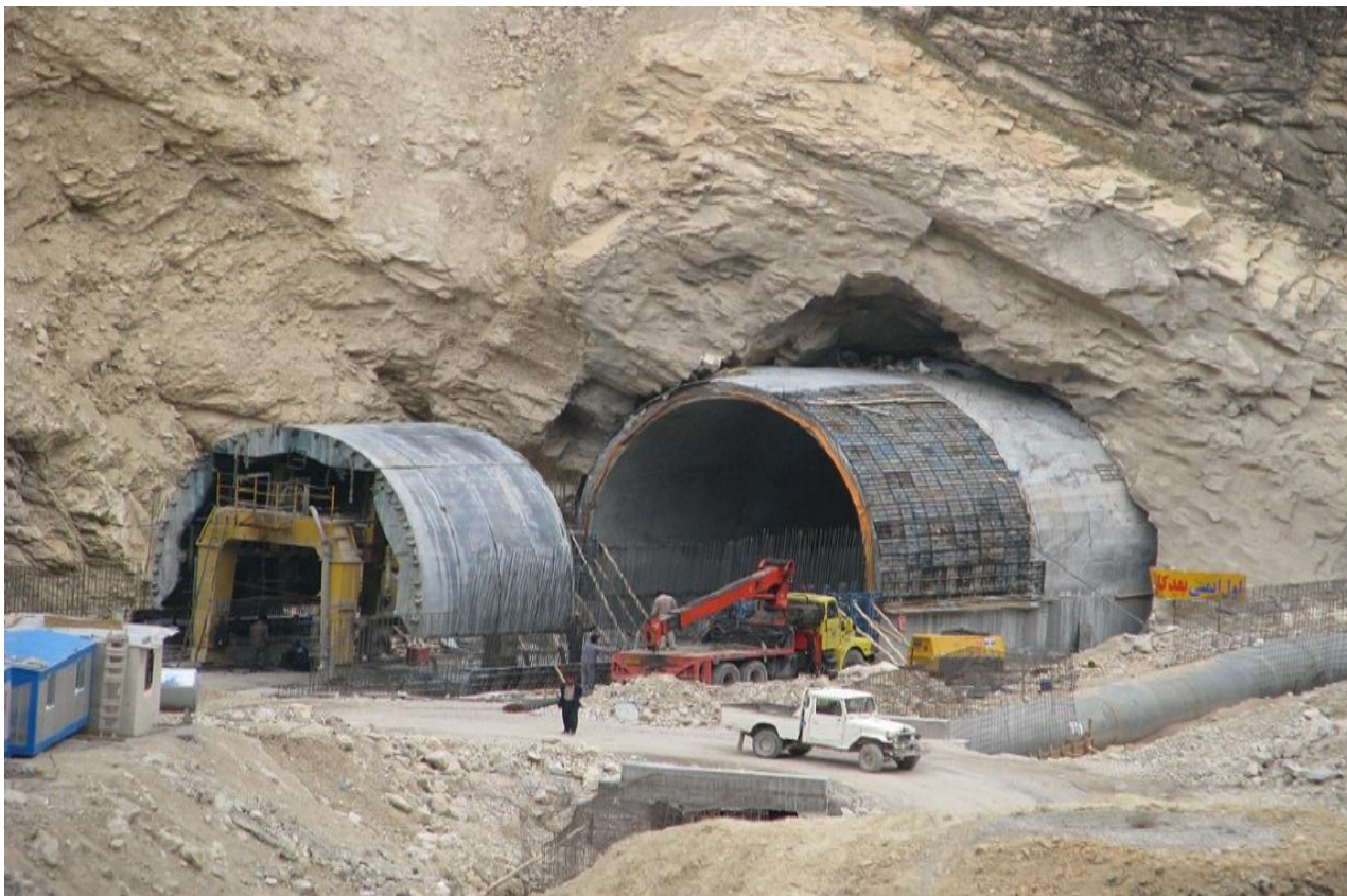
Рисунок 5.9 – Бетонування склепінь великої протяжності
