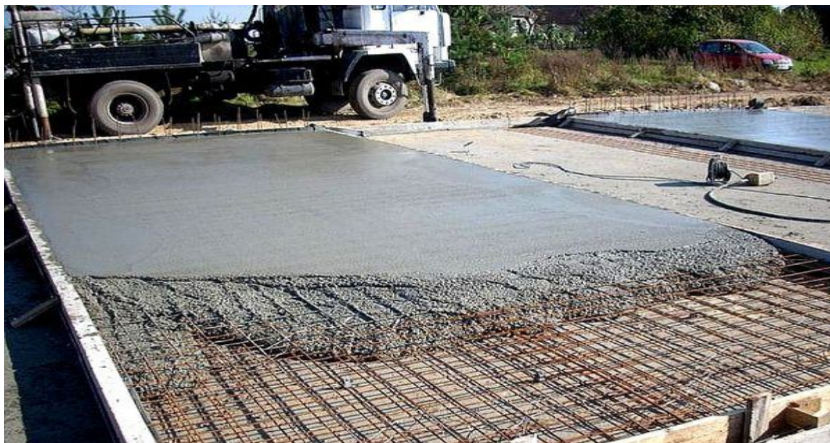
Рисунок 5.5 – Бетонування великорозмірних плит
