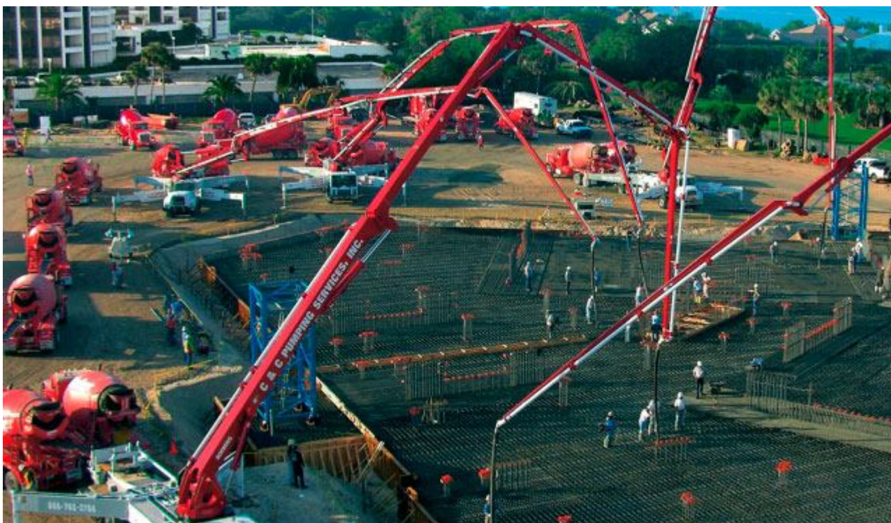
Рисунок 4.7 – Бетонування за допомогою автобетононасосів
