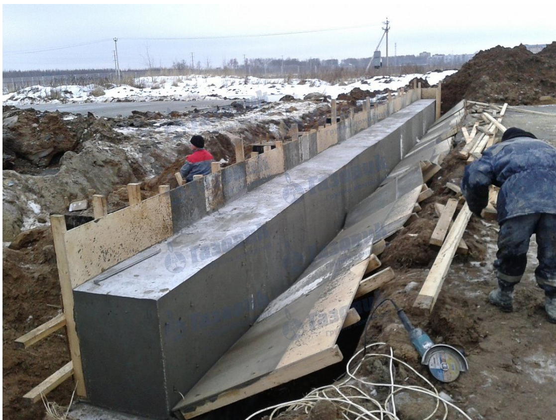
Рисунок 5.15 – Розпалублення монолітних фундаментів
