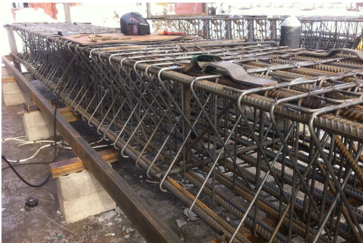
Рисунок 2.16 – Арматурні каркаси, підготовлені до монтажу
