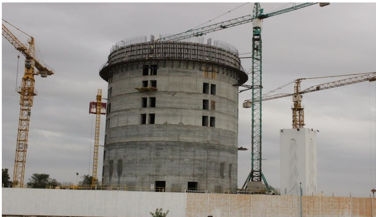
Рисунок 4.5 – Подавання бетонної суміші кранами
