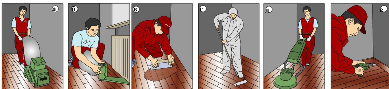
Рисунок 14.21 – Послідовність оздоблювання паркетної підлоги: а, б – шліфування в – шпаклювання та ґрунтування; г – покриття лаком; д – натирання; е – установлення плінтуса
