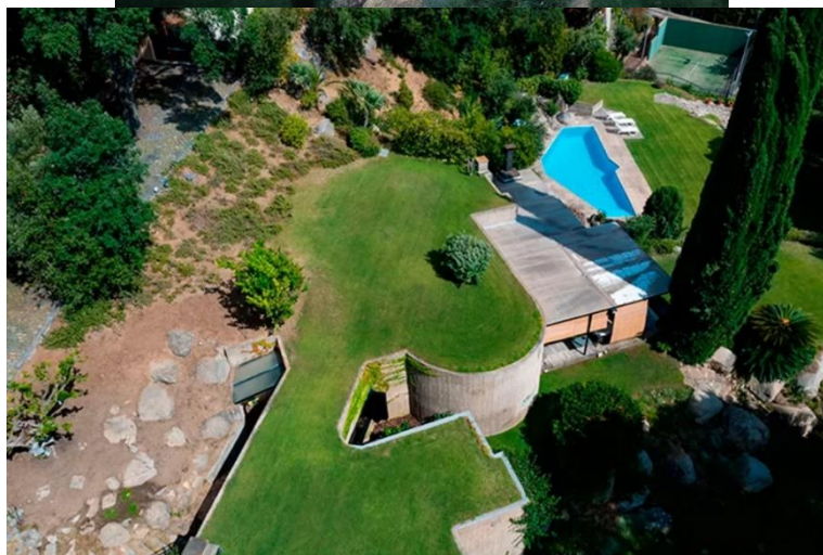
Рисунок 3 – Будинок Riera (Earth-sheltered house) архітектора Хав'єра Барби [3]
