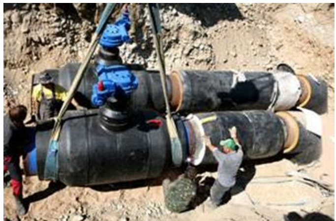
Рисунок 7.38 – Фрагмент теплофікаційного вузла приєднання
