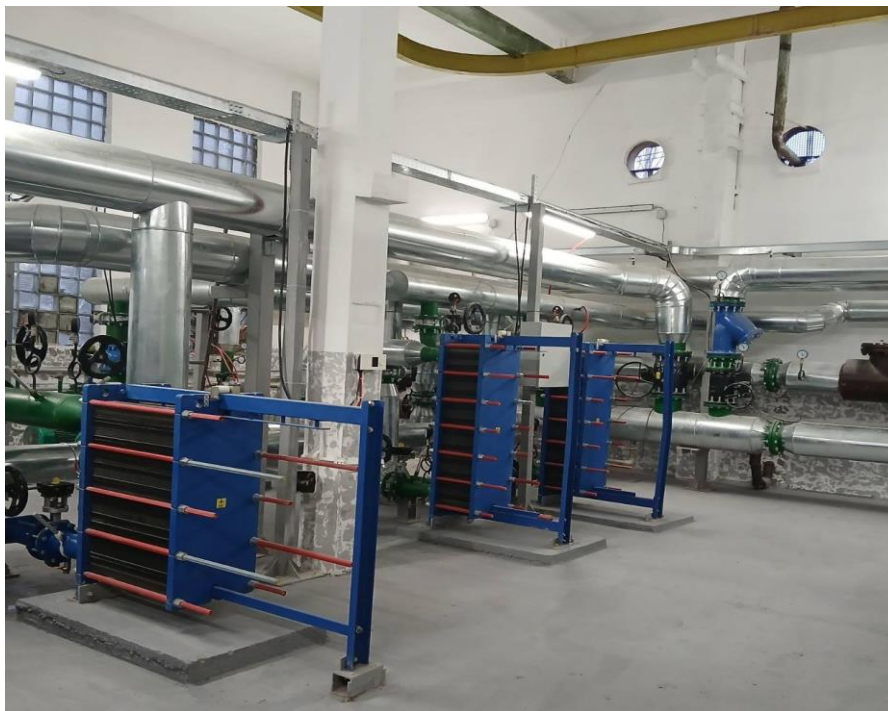
Рисунок 8.14 – Пластинчасті теплообмінники системи гарячого водопостачання. Двоступенева схема
