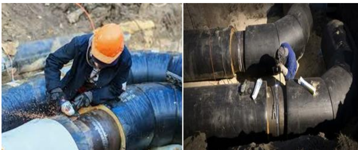
Рисунок 7.15 – Зварювання з'єднань трубопроводів теплотраси
