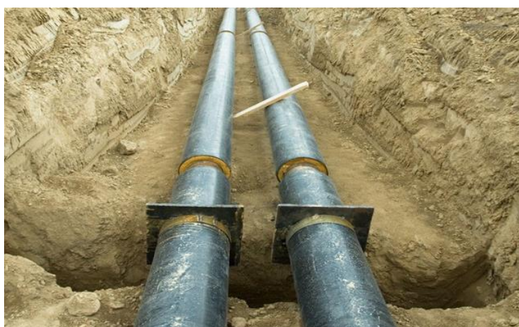
Рисунок 7.14 – Попередньо ізольовані нерухомі опори для підземної прокладки
