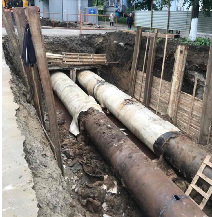
Рисунок 7.1 – Існуюча тепловіддача діаметром 820 мм перед заміною її на нову попередньо ізольовану
