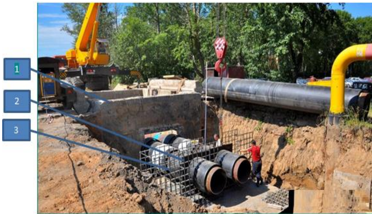
Рисунок 7.30 – Устрій нерозвантаженої посиленої нерухомої опори на діаметрі 820 мм: 1 – теплова камера; 2 – нерухома опора; 3 – якір нерухомої опори
