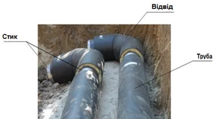
Рисунок 7.13 – Стикування відводу і прямого ділянки труби
