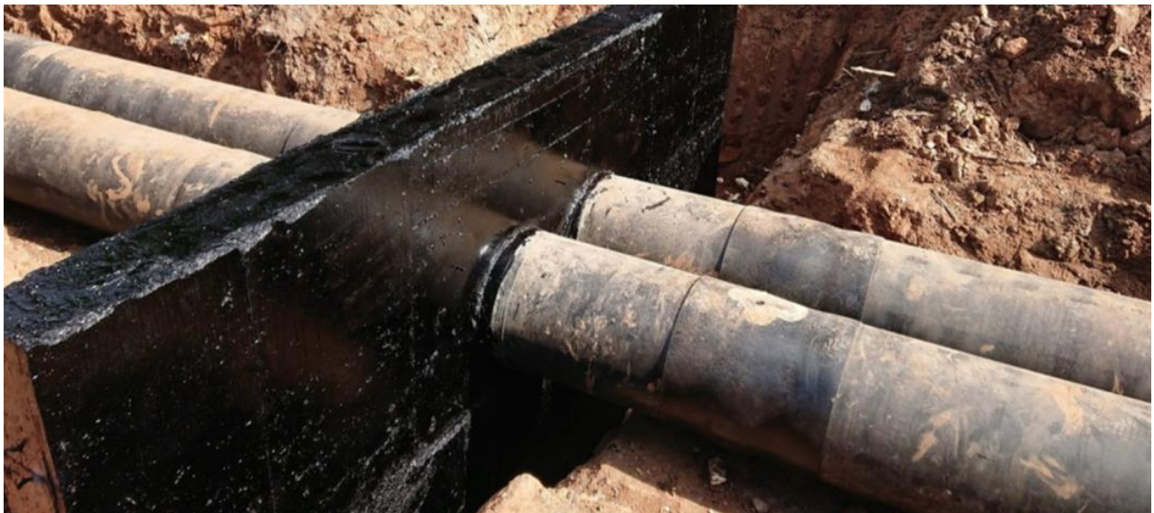
Рисунок 7.29 – Тримальні конструкції нерухомих розвантажених опор у ґрунті
