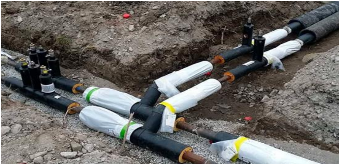
Рисунок 7.38 – Фрагмент теплофікаційного вузла приєднання
