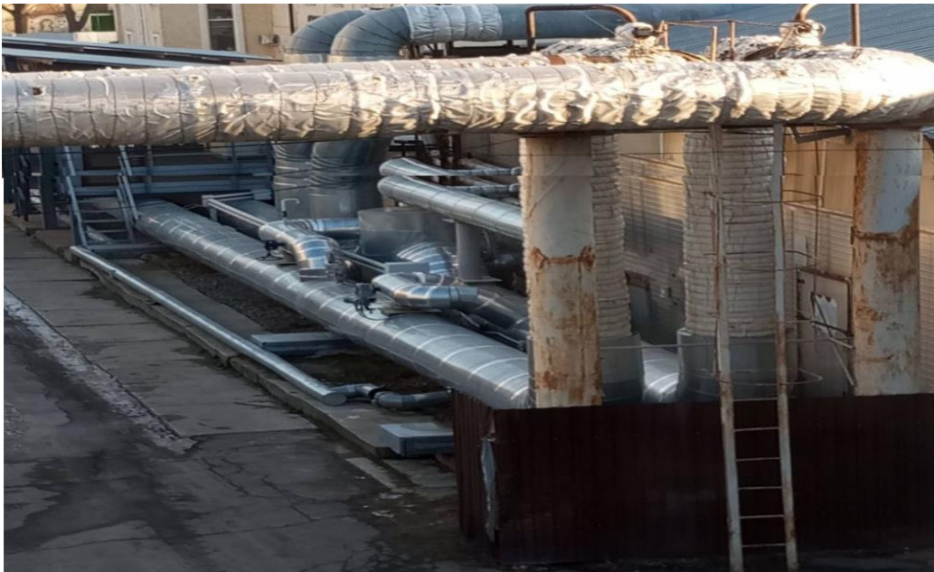
Рисунок 7.41 – Теплофікаційний вузол приєднання при надземній прокладці
