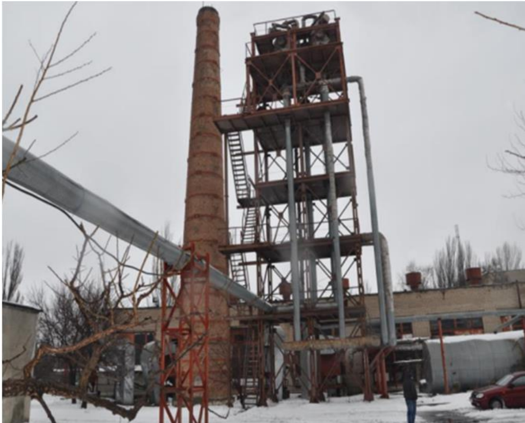
Рисунок 12.3– Вакуумна деаераційна установка на котельні м. Запоріжжя
