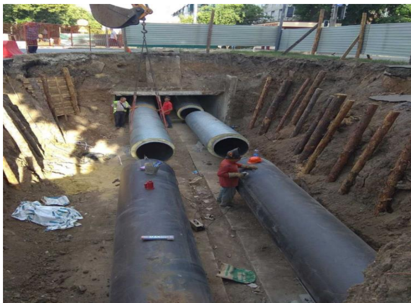
Рисунок 7.12 – Фото нової попередньо ізольованої теплотраси в процесі монтажу
