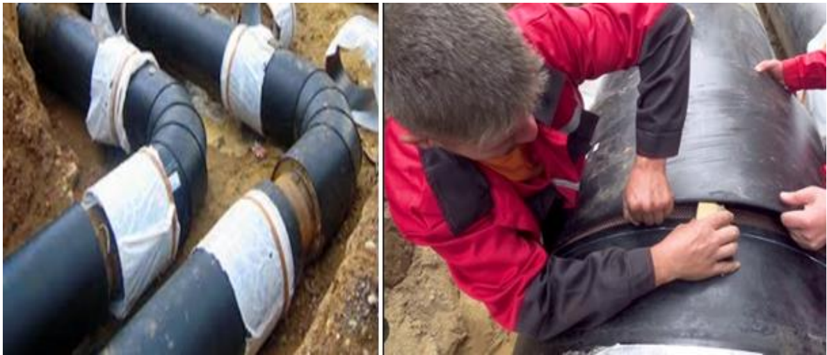
Рисунок 7.16 – Муфтування з'єднань трубопроводів теплотраси
