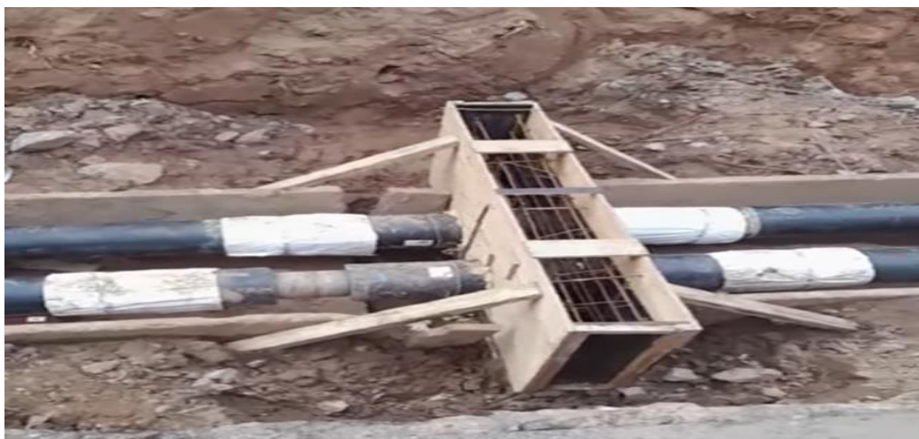
Рисунок 7.27 – Бетонування нерухомої опори
