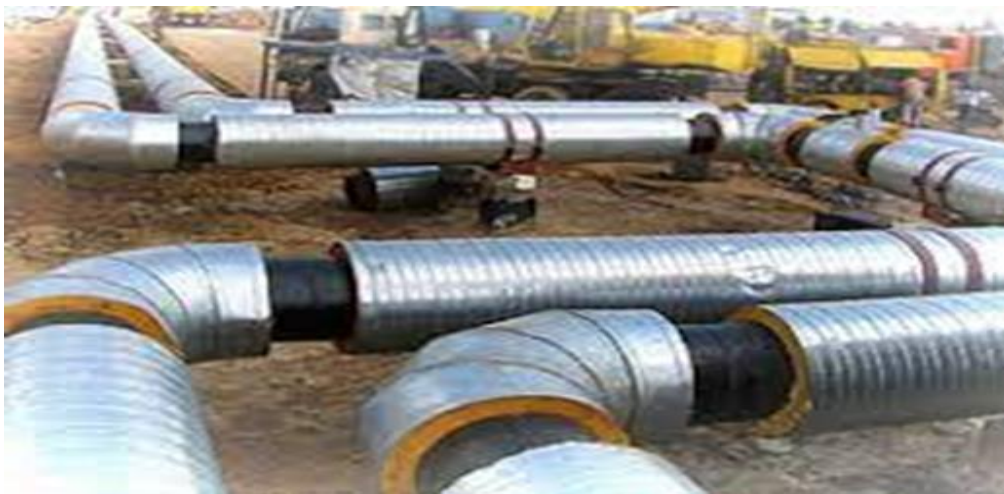
Рисунок 7.18 – Попередньо ізольовані П-подібні компенсатори для надземної прокладки [URL : https://metalukraine.com.ua/ua/p1430390690-truba-predizolirovannaya-spiro.html .]
