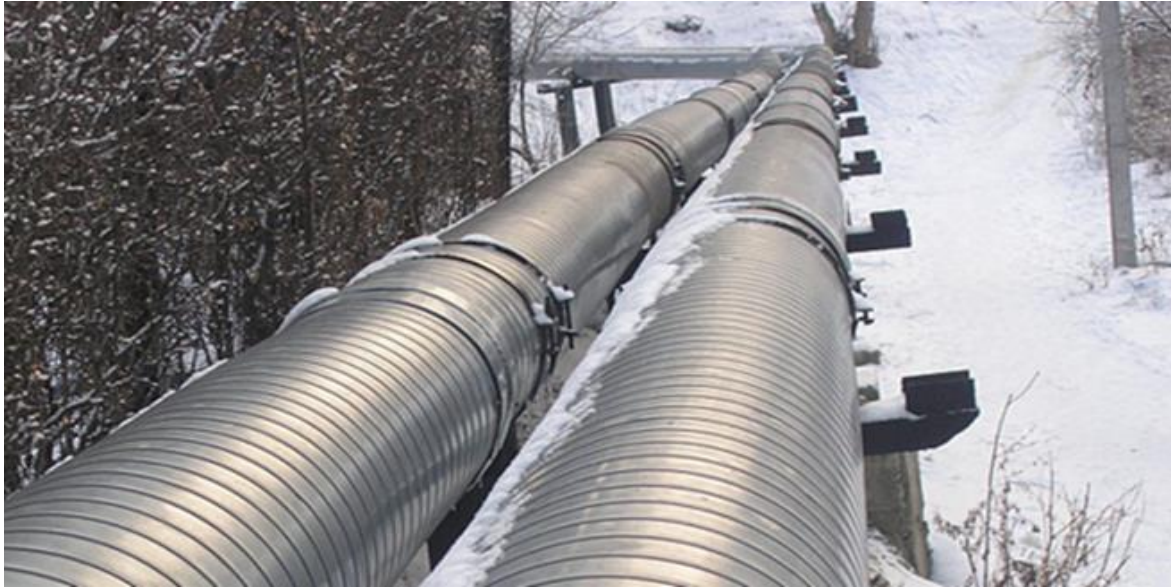
Рисунок 7.17 – Попередньо ізольовані труби
