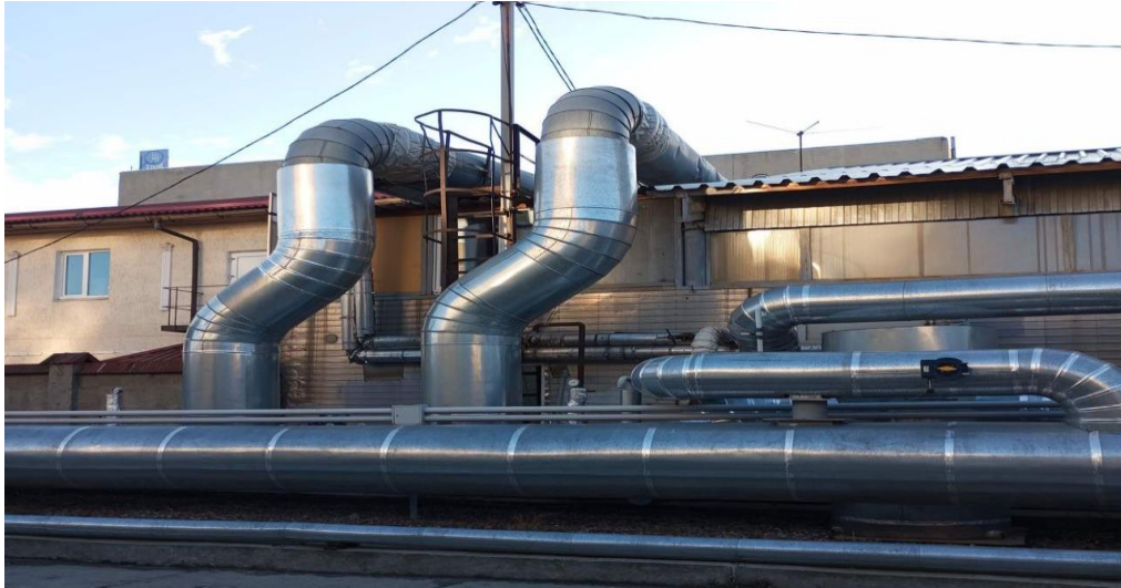
Рисунок 7.40 – Теплофікаційний вузол приєднання при надземній прокладці
