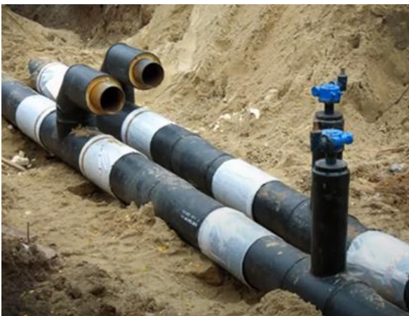
Рисунок 7.38 – Фрагмент теплофікаційного вузла приєднання
