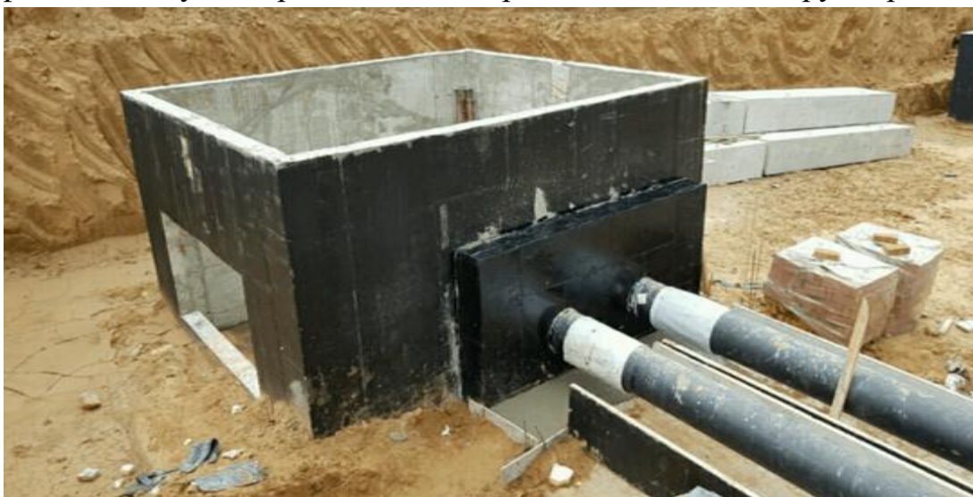
Рисунок 7.36 – Фрагмент залізобетонної теплової камери перед засипкою ґрунтом
