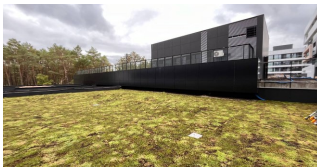
Рисунок 1 – Вигляд озелененого даху екстенсивного типу після завершення робіт з укладання матів
