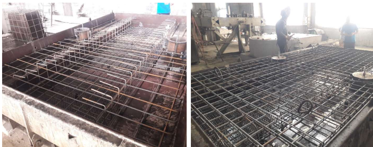
Рисунок 4.16 – Процедура армування пішохідної плити на заводі
