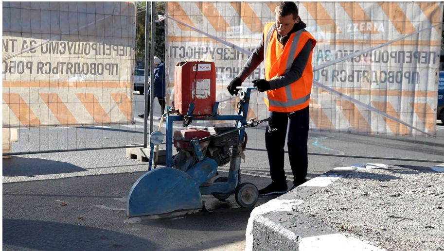
Рисунок 4.21 – Прорізання асфальтового покриття дороги
