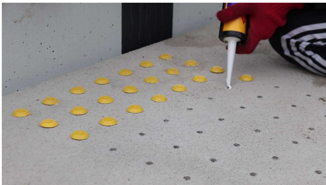
Рисунок 4.19 – Вклеювання тактильних індикаторів
