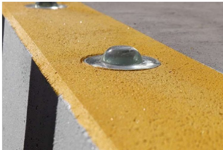
Рис.2.13 – Приклад розміщення світлоповертальних вставок на рефюджі.
