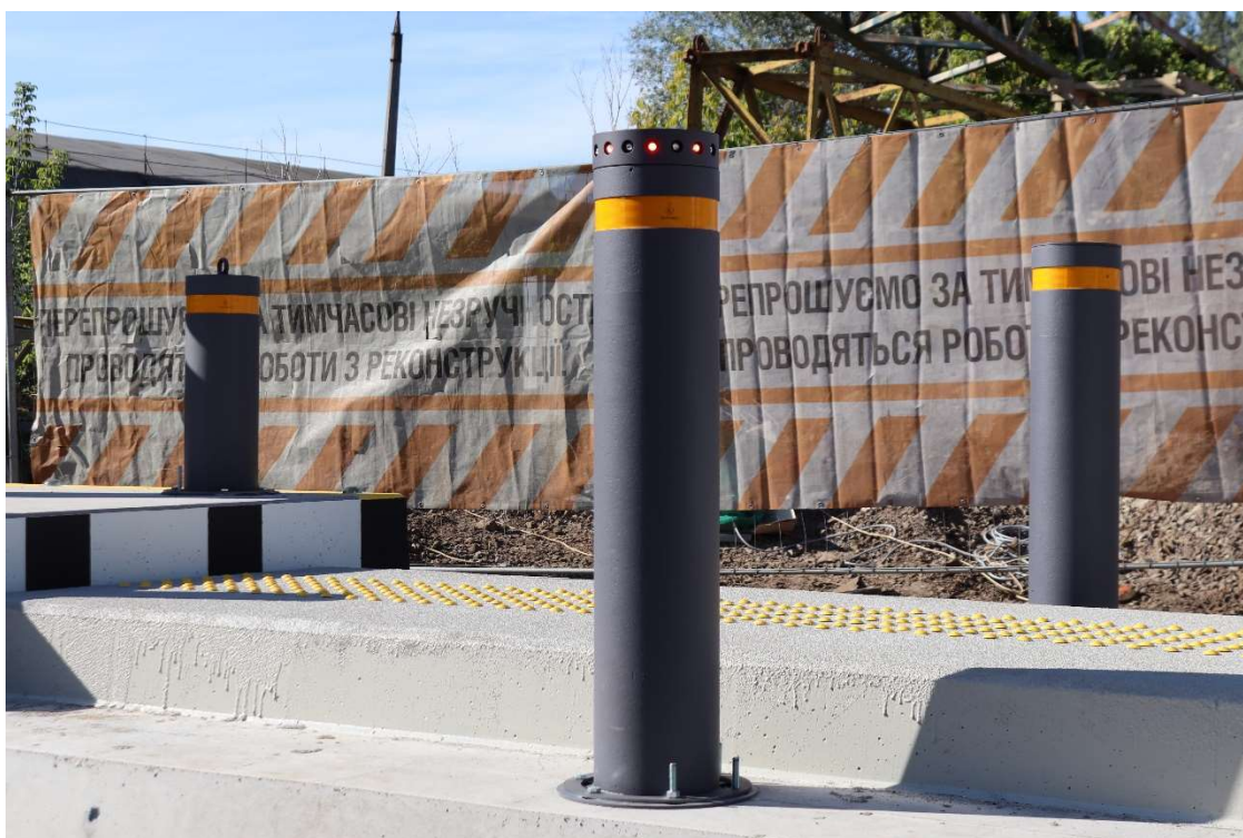
Рисунок 4.20 – Готова конструкція пішохідної плити
