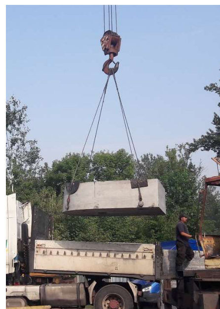
Рисунок 4.11 – Стропування виробу
