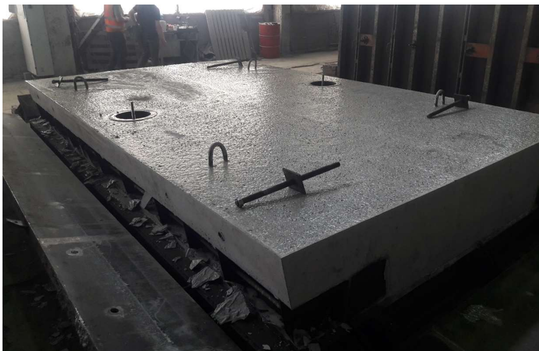
Рисунок 4.17 – Загальний вигляд конструкції після розпалублення
