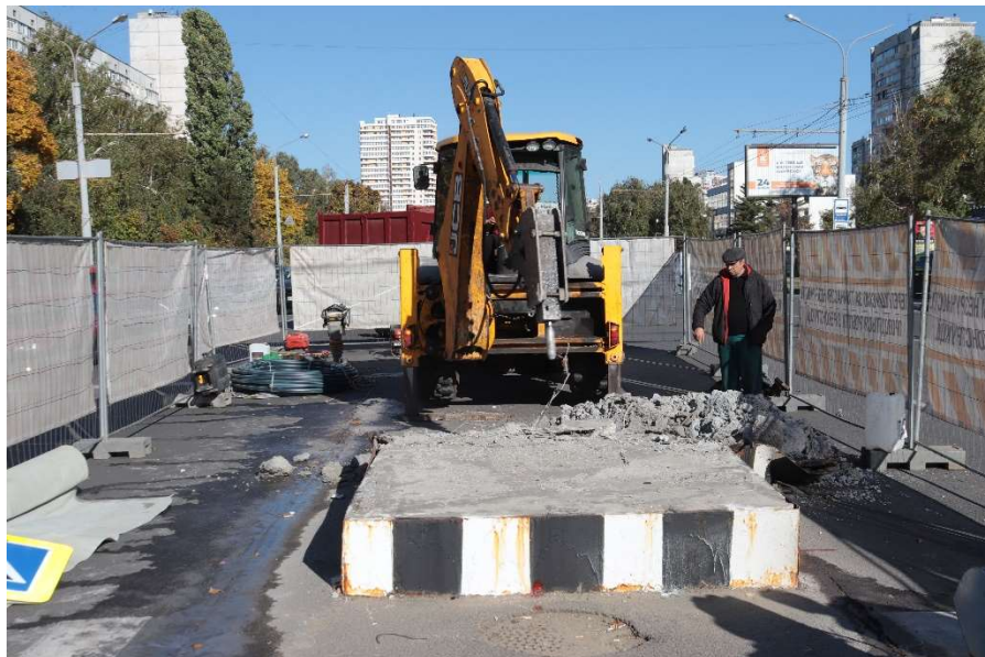
Рисунок 4.22 – Демонтаж існуючого острівка безпеки екскаватором
