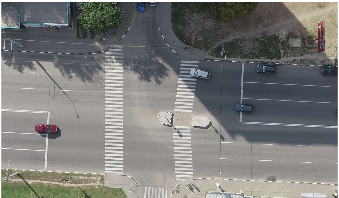
Рисунок 5.3 – Підготовчий етап будівництва на розглянутому перехресті
