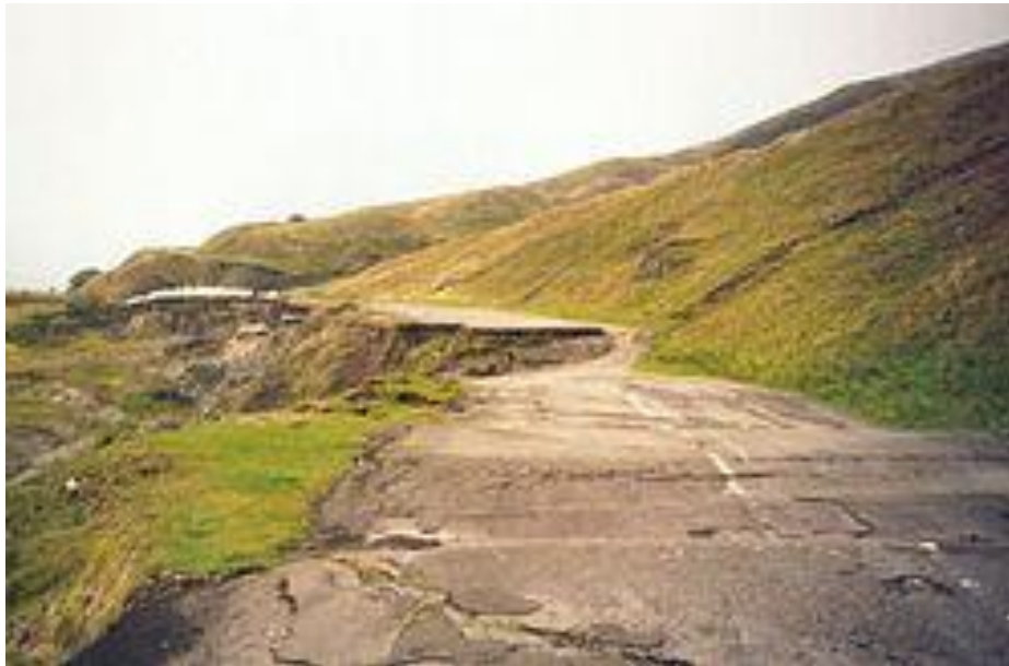
Рисунок 1.7 – Обвальний процес на автошляху
