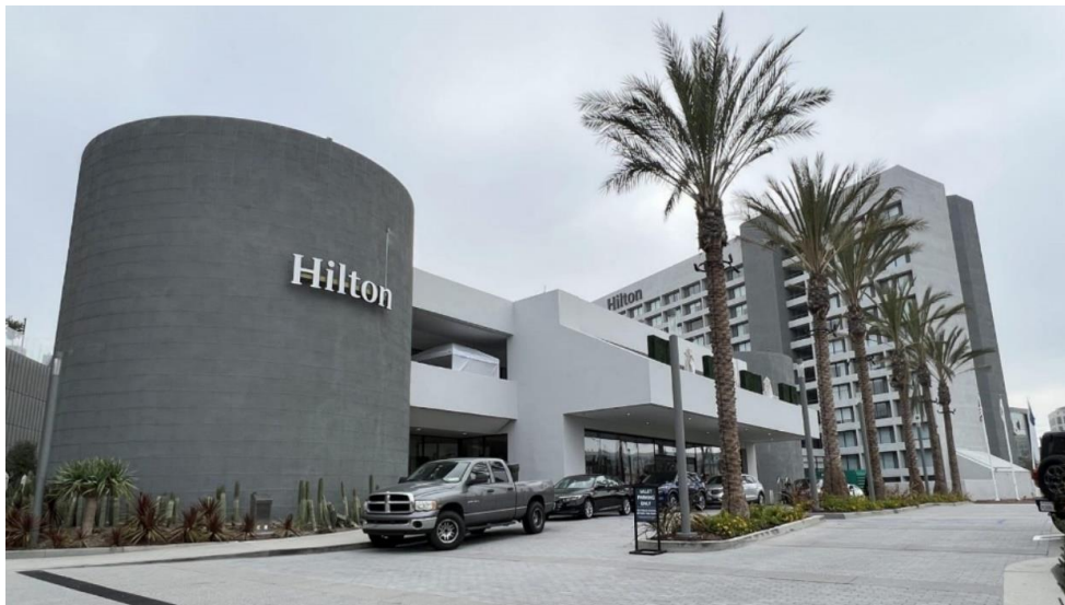
Рисунок В.1 – Готель «Hilton» Los Angeles Culver City
