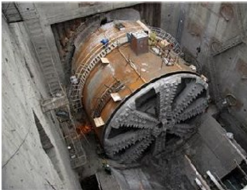
Рисунок 12.2 – Фотознімок прохідного щита
