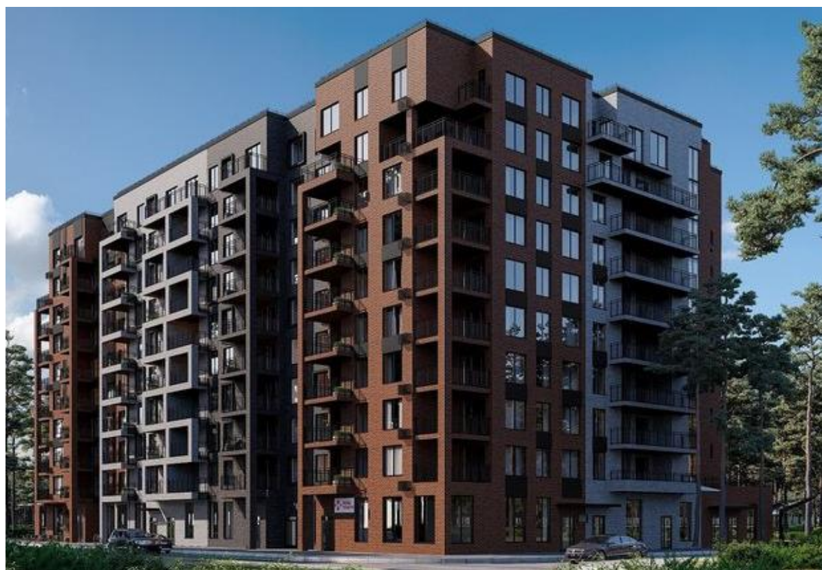
Рисунок Г.4.2 – Загальний вигляд
