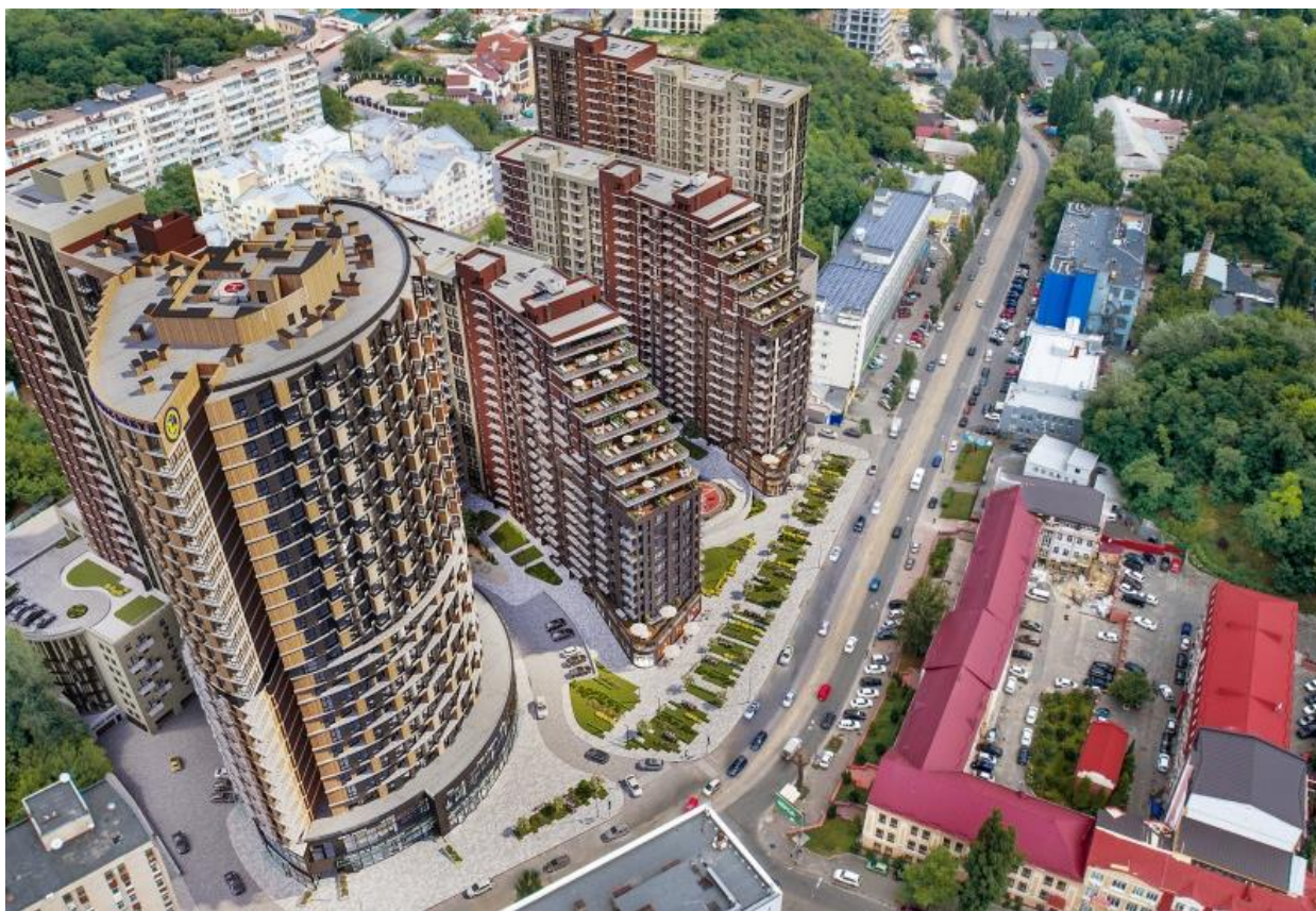
Рисунок Г.3.1 – Загальний вигляд
