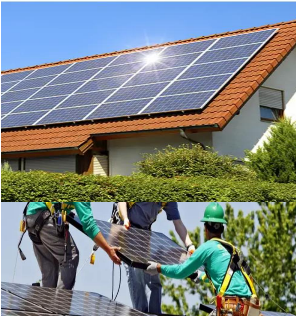
Рисунок 2 – Монтаж сонячних панелей
