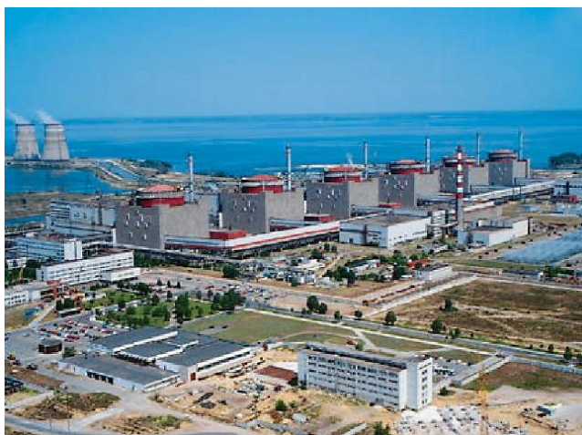
Рисунок 8.1 – Загальний вигляд промайданчика Запорізької АЕС
