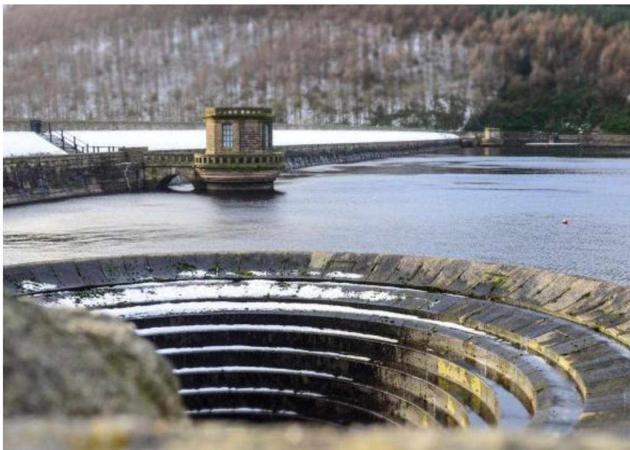
Рисунок 50 – Шахтний водоскид на озері Ледібауер, Великобританія
