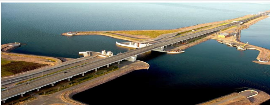
Рисунок 102 – Регуляційна споруда (струмененапрямна дамба)
