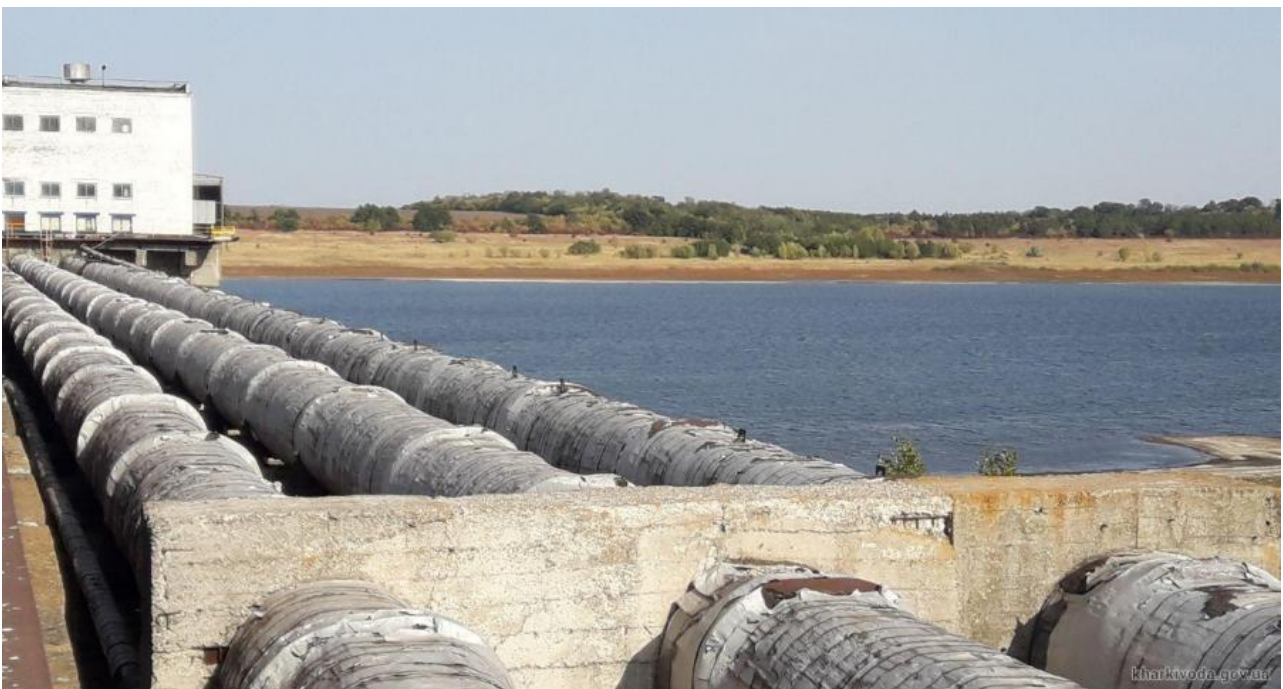
Рисунок 55 – Водозабірна споруда, Краснопавлівське водосховище,
