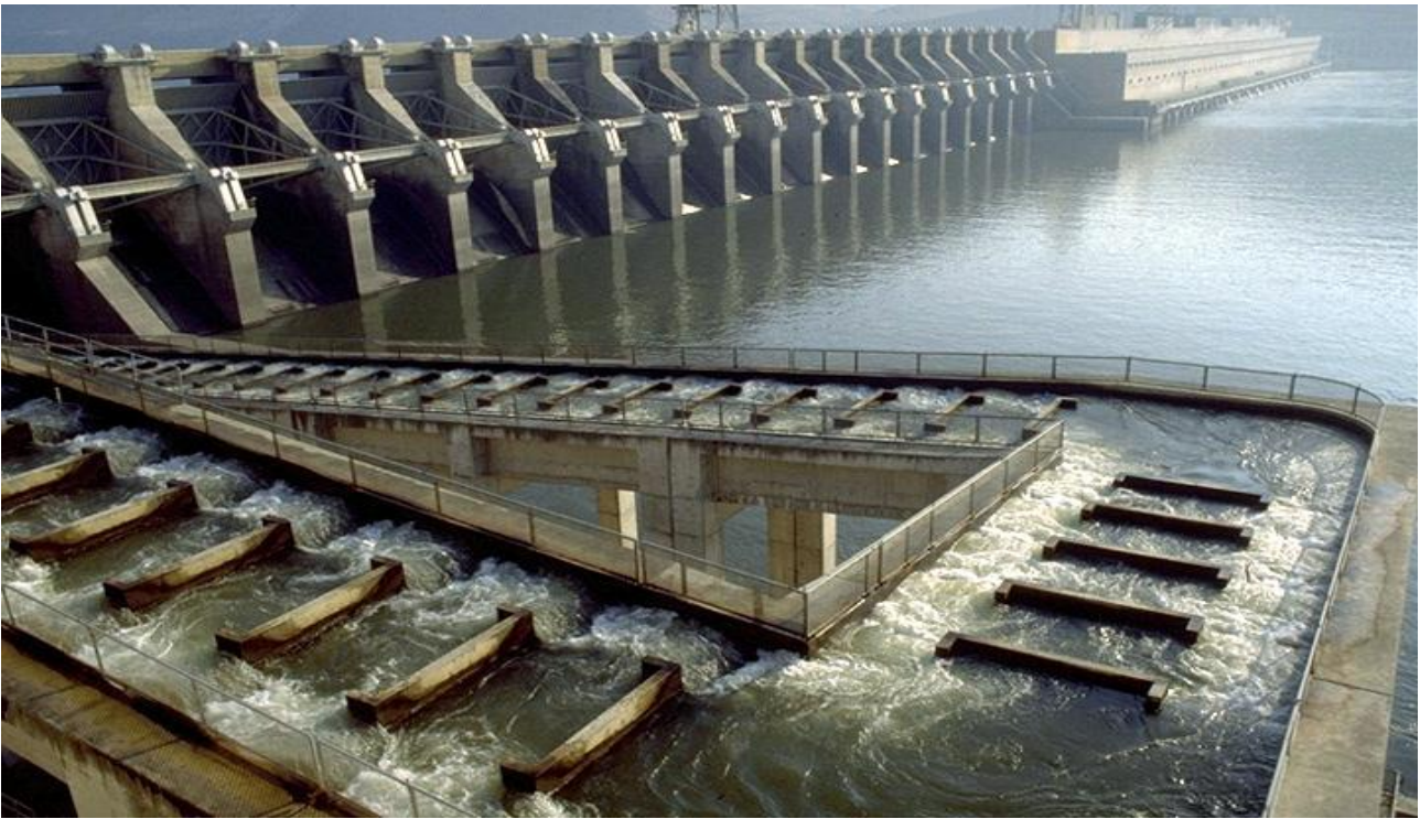
Рисунок 36 – Рибопрохід на греблі «Джон Дей» на річці Джон-Дей, США
