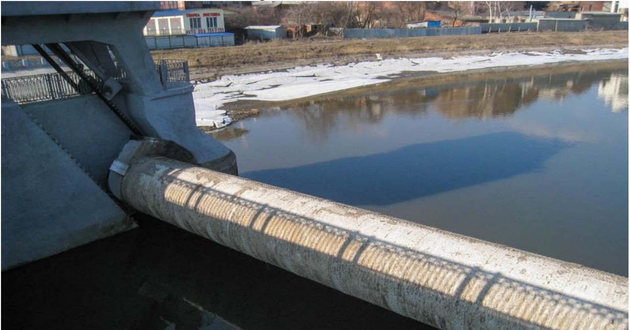
Рисунок 54 – Вальцьовий затвор, Гончарівська гребля, Харків, Україна
