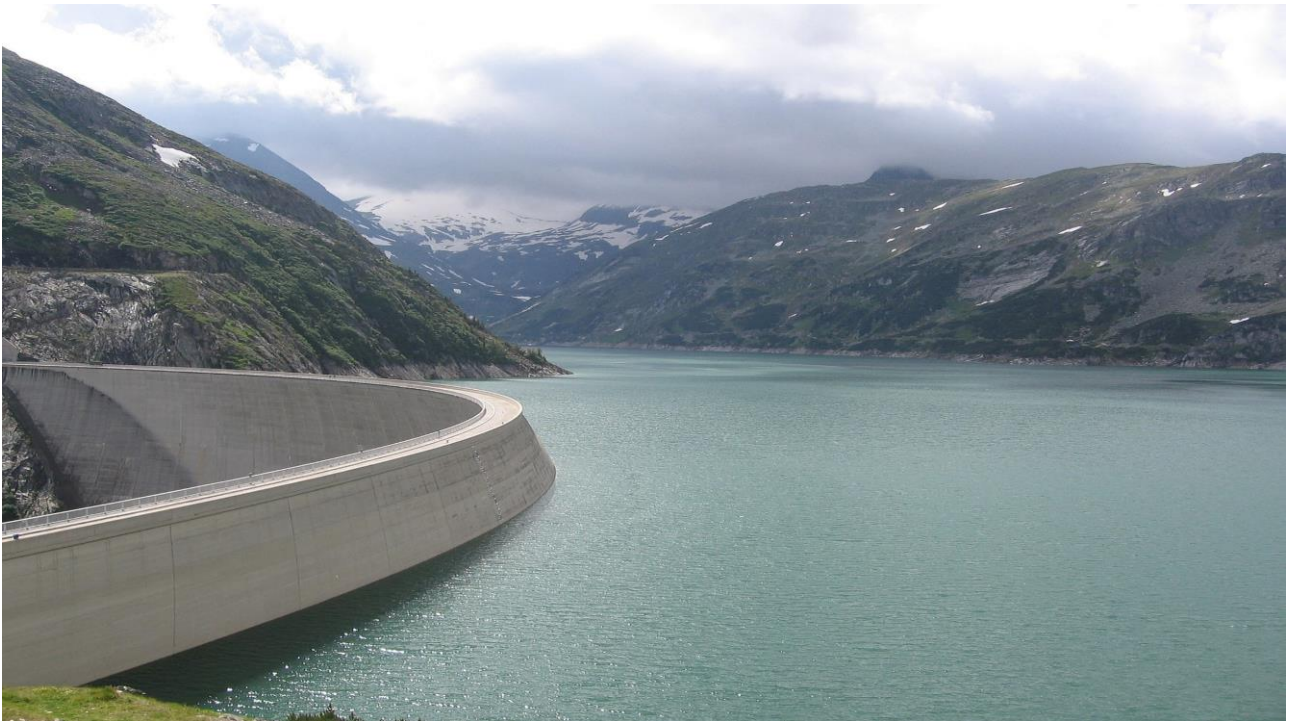
Рисунок 43 – Аркова гребля Кельнбрейн, Австрія
