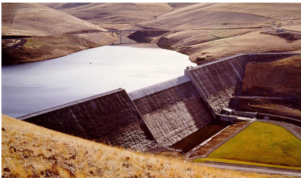
Рисунок 42 – Бетонна гравітаційна гребля Уіллоу Крік, штат Орегон, США
