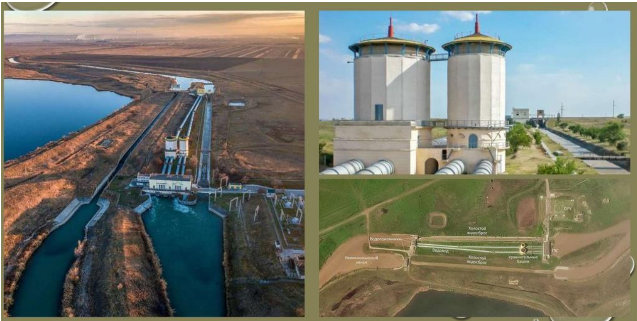
Рисунок 67 – Зрівняльний резервуар
