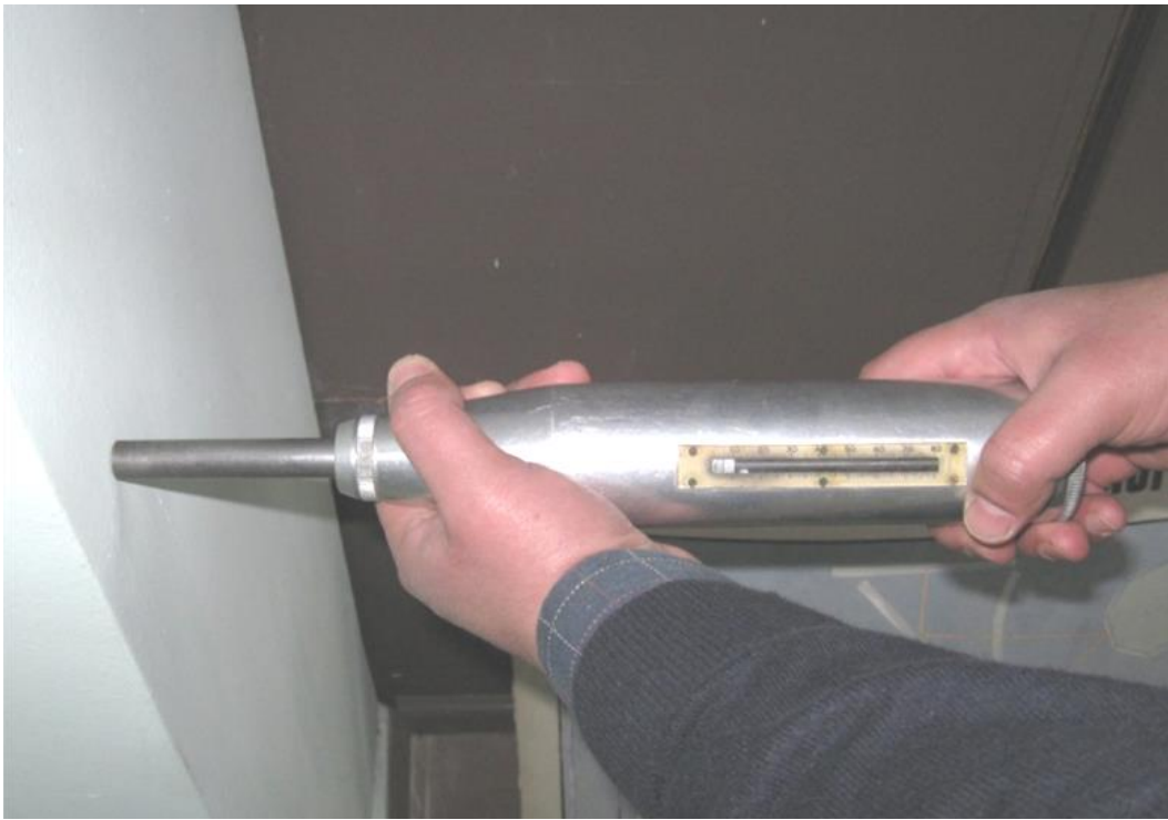
Рисунок 3.9 – Визначення міцності бетону за допомогою склерометра Шмідта
