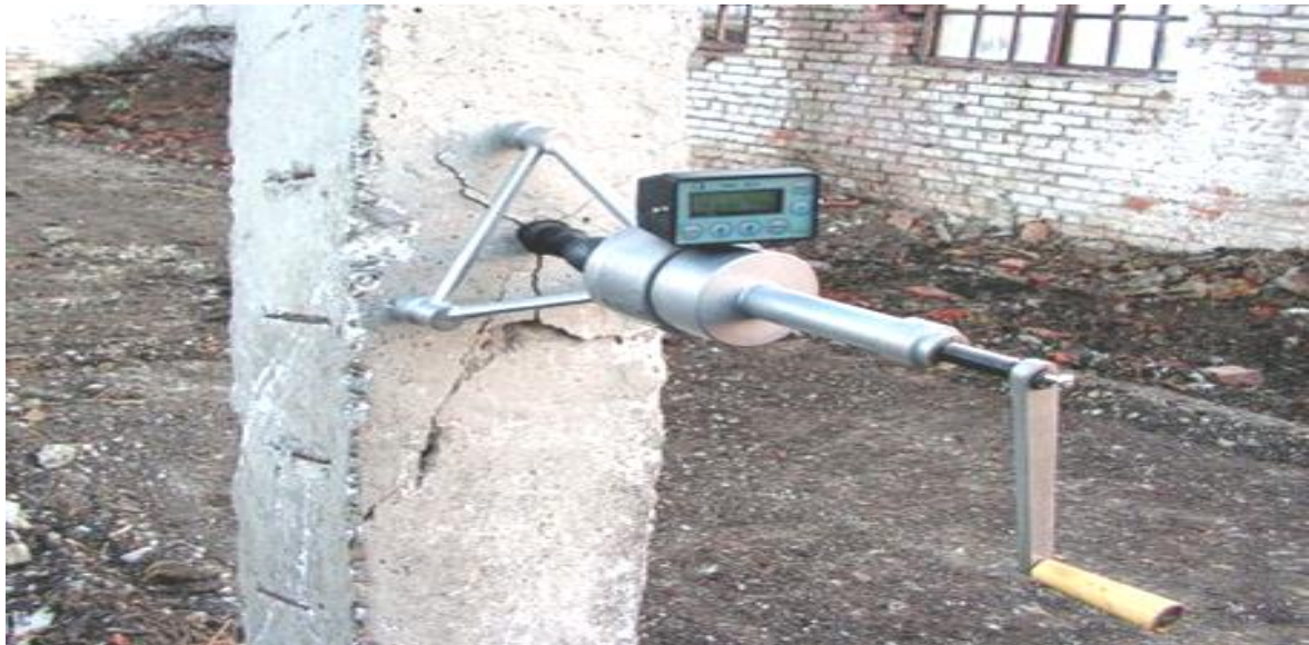
Рисунок 3.2 – Випробування міцності бетону методом відриву за допомогою приладу ПОС-50МГ4
