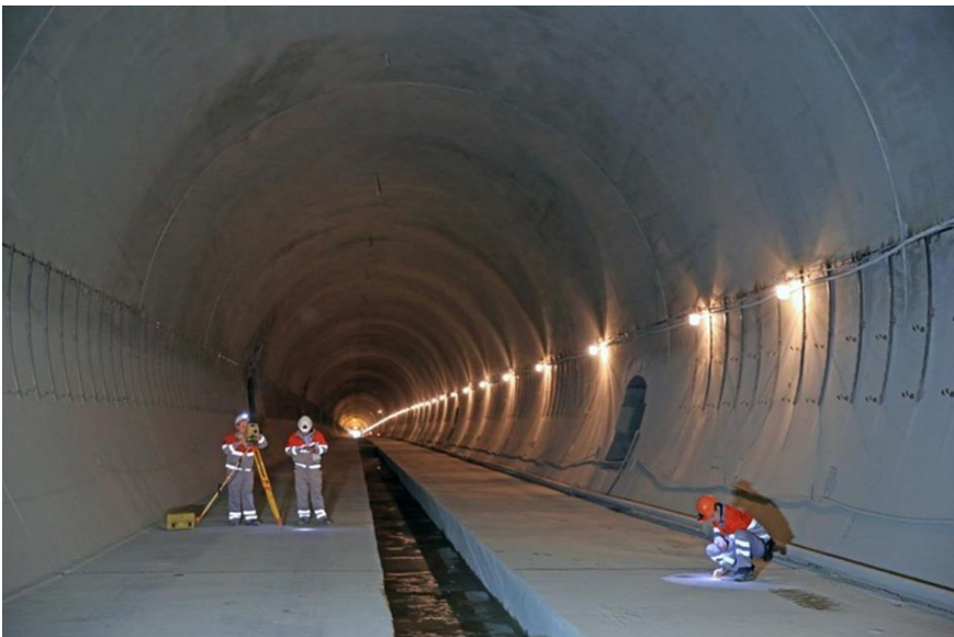
Рисунок 4.11 – Зображення геодезичних робіт при будівництві тунелів
