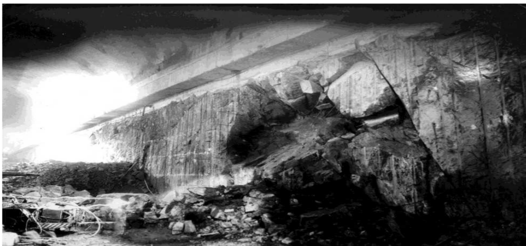
Рисунок 77 – Вивал у стіні машинної зали
