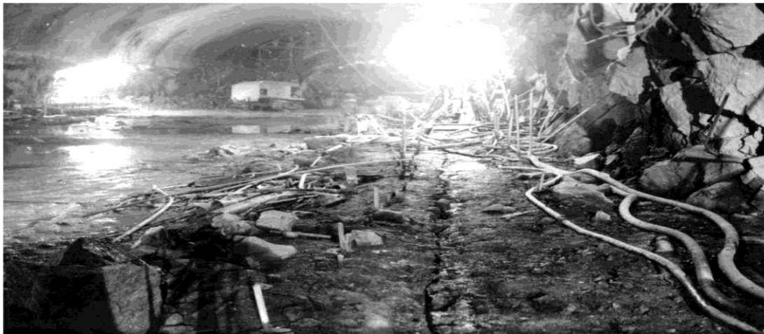
Рисунок 76 – Загальний вигляд підсклепінного простору і утворена методом гладкого підривання щілина
