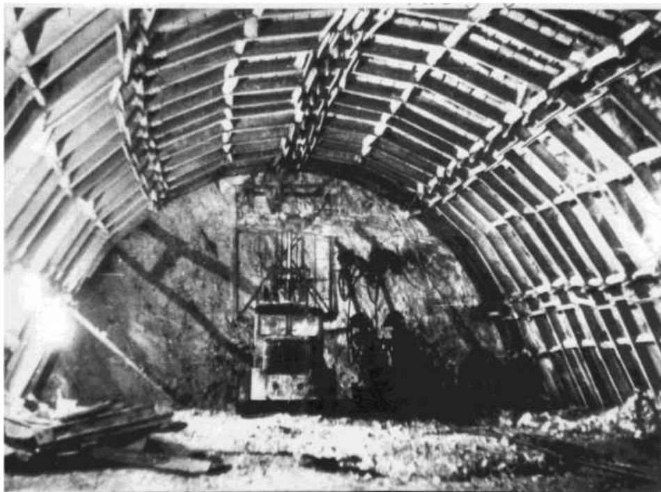
Рисунок 61 – Металеве арочне кріплення в дериваційному тунелі Інгурської ГЕС (Грузія)
