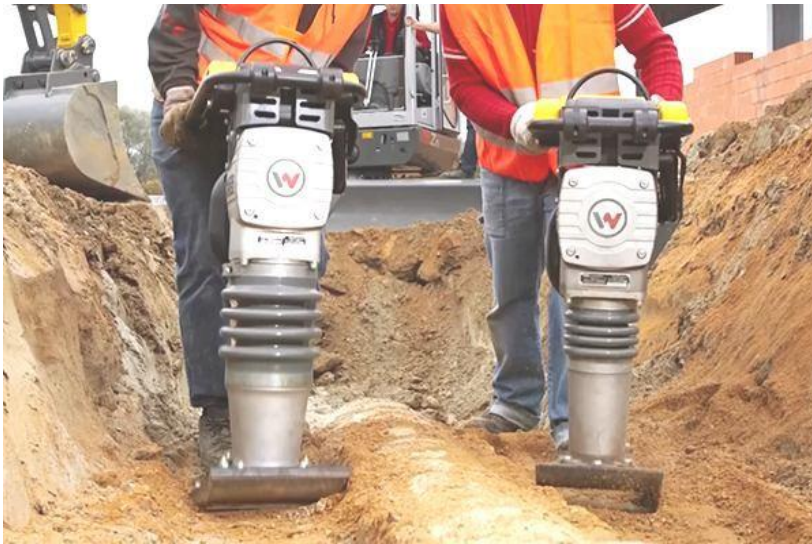
Рисунок 1.18 – Використання трамбовок із ручним керуванням
