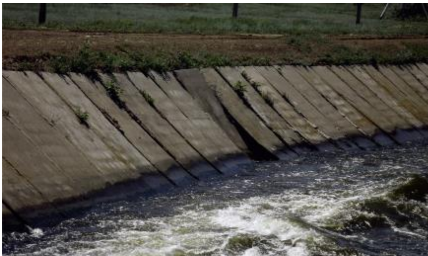
Рисунок 4.16 – Розташування плит збірного залізобетонного облицювання
