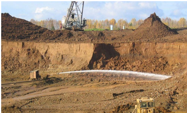
Рисунок 2.1 – Гідромеханічний спосіб виконання земляних робіт
