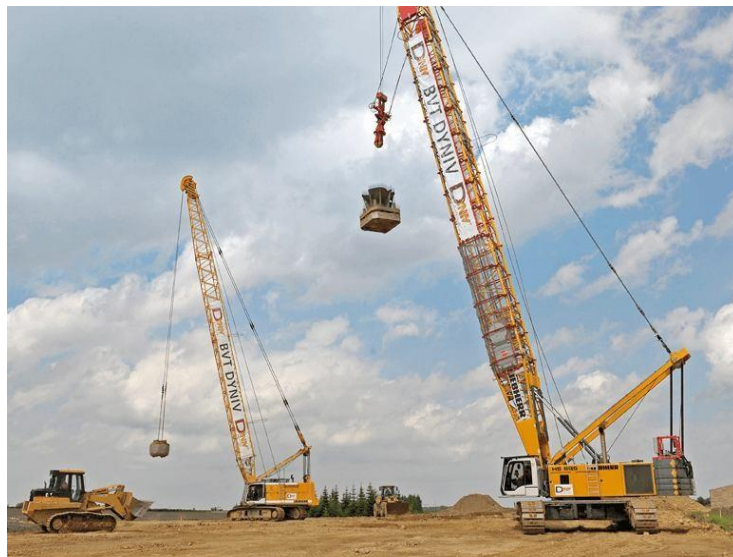
Рисунок 1.16 – Використання підвісної (до крана) віброплити для ущільнення ґрунту
