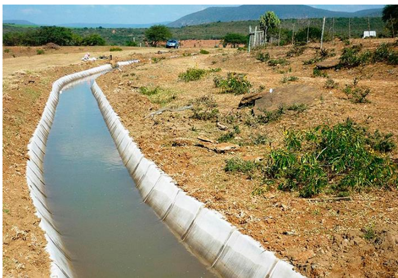
Рисунок 4.21 – Зрошувальний канал із плівковим покриттям
