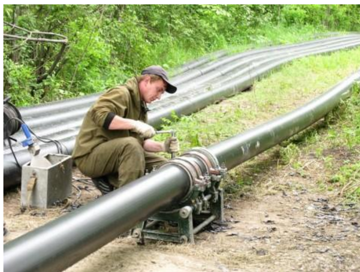
Рисунок 1.40 – Стикування та центрування труб для виконання з'єднання
