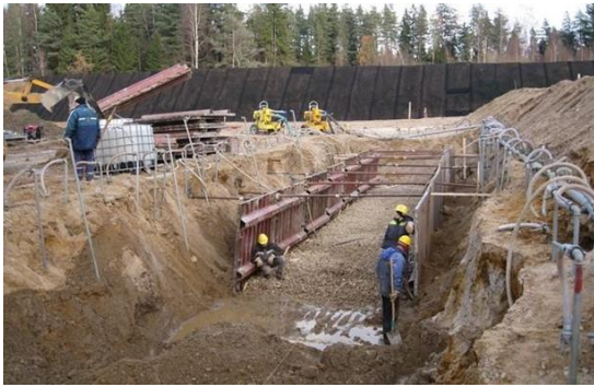
Рисунок 1.3 – Голкофільтровий спосіб зниження рівня ґрунтових вод
