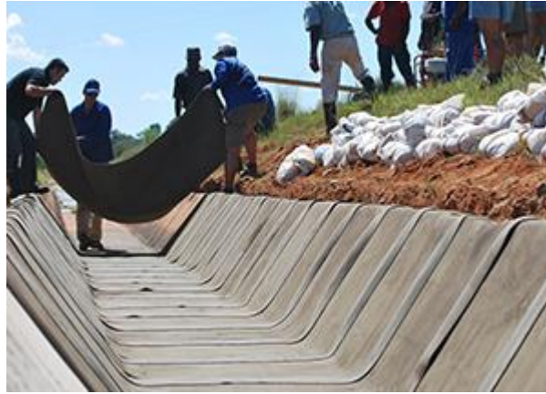
Рисунок 4.20 – Улаштування монолітного бетонно-плівкового покриття
