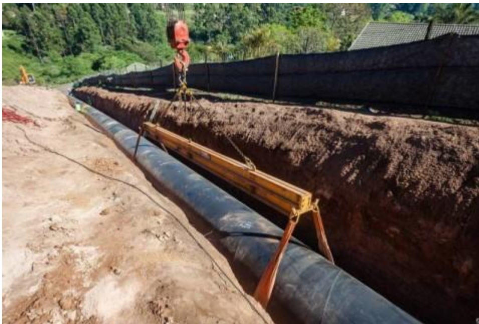
Рисунок 1.35 – Укладання труб у траншею
