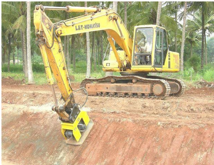
Рисунок 1.17 – Використання навісних трамбувальних плит для ущільнення ґрунту
