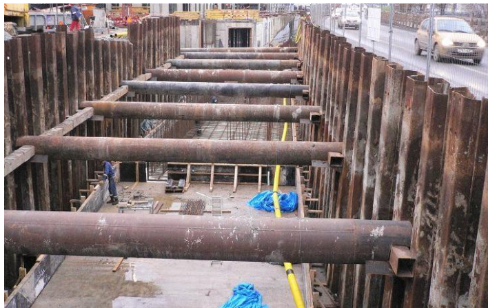
Рисунок 1.9 – Шпунтово-розпірне обгородження котловану
