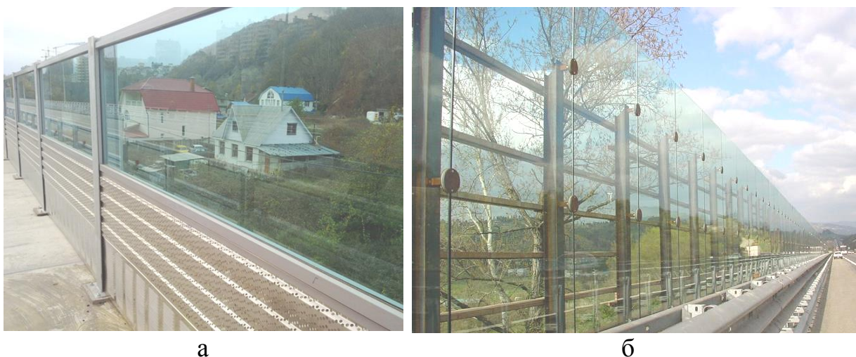
Рисунок 16.6 – Акустичні екрани з: а – комбінованих панелей з ПММА і панелі зі звукопоглинанням; б – із панелей ПММА [57]
