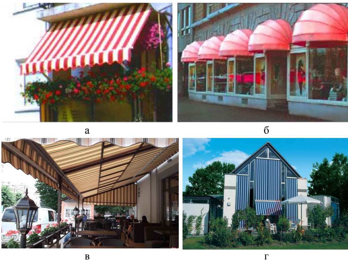
Рисунок 11.18 – Екрани типу «маркіз»: а – балконна маркіза; б – кошова маркіза; в – горизонтальні маркізи для терас; г – вертикальні маркізи [57]
