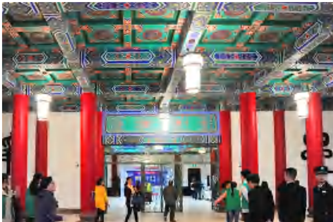
Рис.2.3. Б. Будівля державної бібліотеки у Шанхаї, 1934-1936 рр. Головний зал з відреставрованими розписами на стелі та «павиними воротами».
