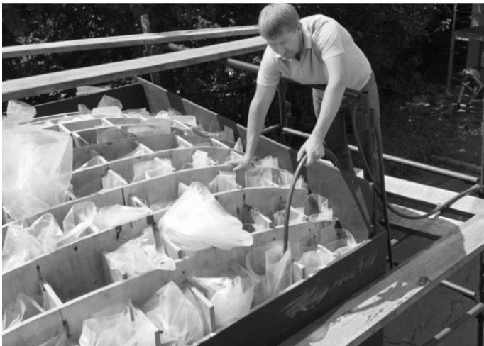
Рис. 3. Заполнение ячеек водой над сферической оболочкой
