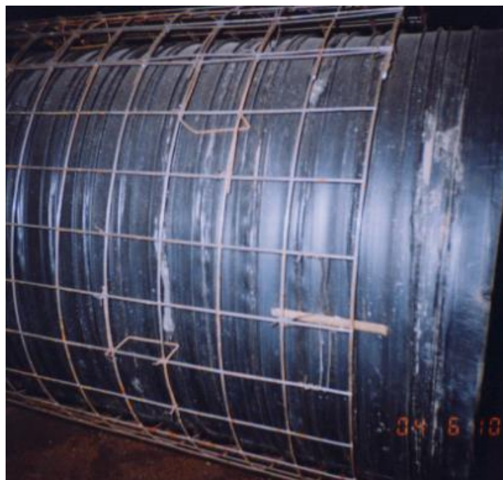
Рисунок 1.5 – Армування майбутнього склепіння з установкою фіксаторів
