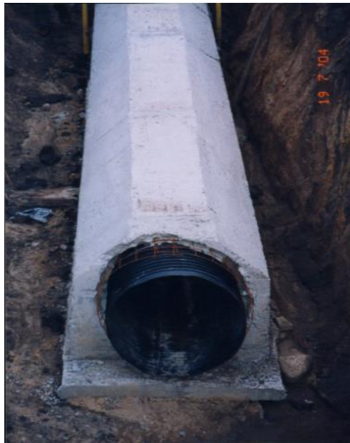
Рисунок 1.6 –Поверхня склепіння перед гідроізоляцією
