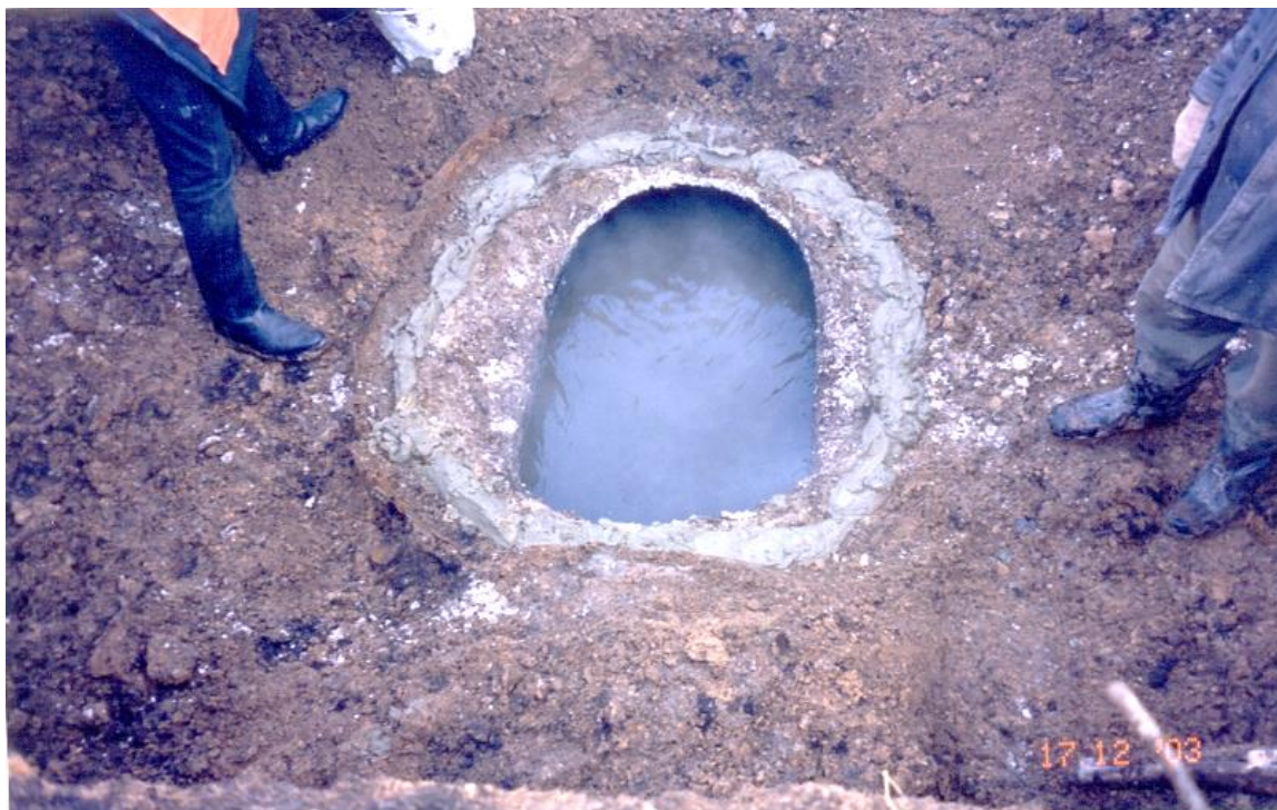
Рисунок 2.2 – Руйнація колектора
