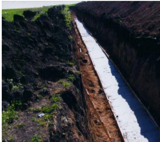
Рисунок 1.4 – Підготовка постілі для монтажу трубопроводу з арматурним каркасом
