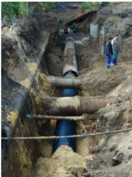
Рисунок 1.11 – Реконструкція колектора Д1000 мм, ХТЗ, м. Харків
