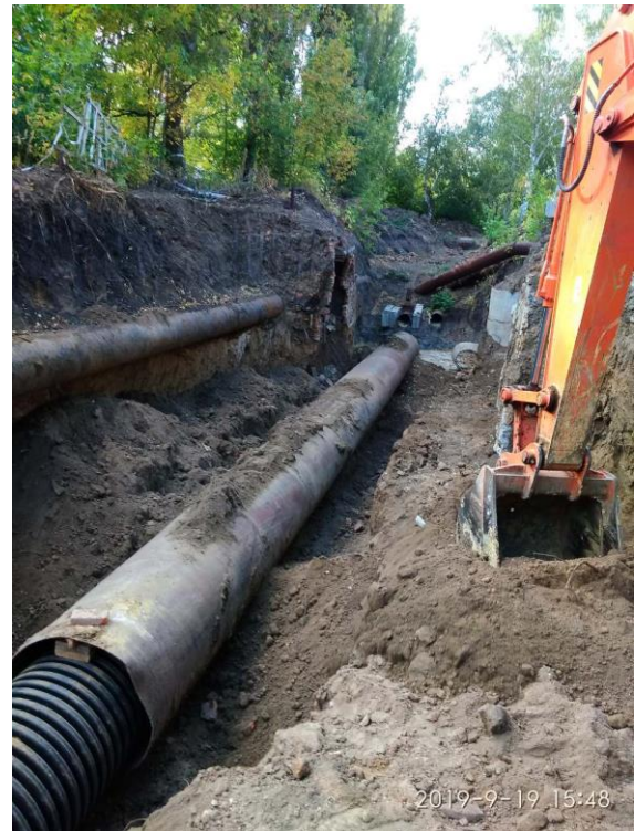
Рисунок 1.13 – Відновлення трубопроводами Корсис 1000 мм
