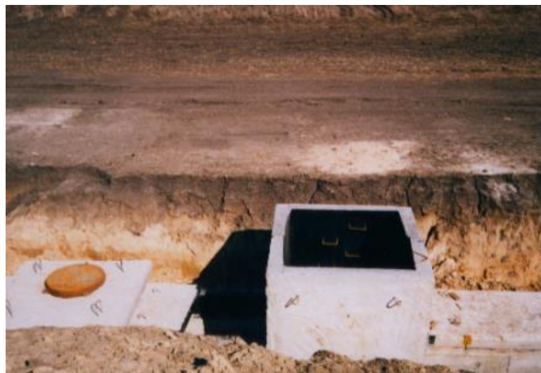
Рисунок 1.7 –Оглядових колодязів, що захищено від корозії листовим ребристим поліетиленом
