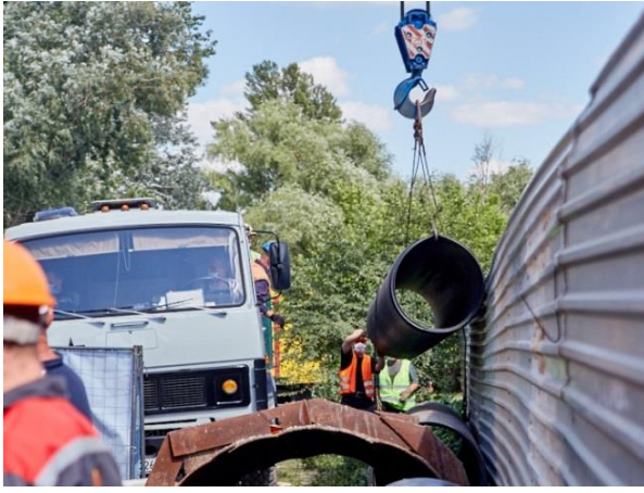
Рисунок 1.12 – Колектора Д800 ПЕ, Салтівка, м. Харків
