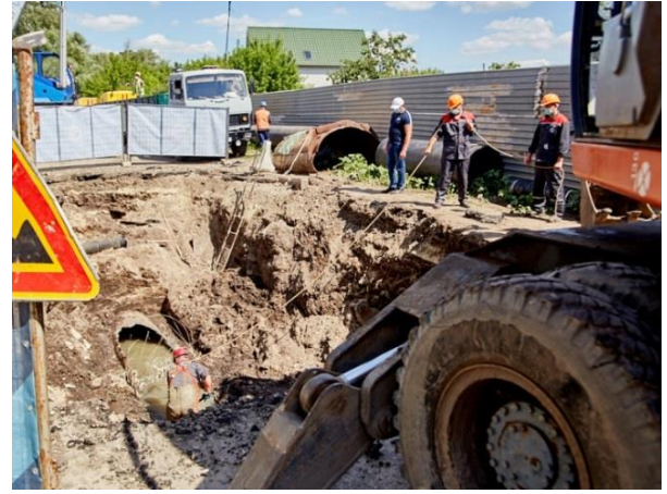
Рисунок 1.12 – Колектора Д800 ПЕ, Салтівка, м. Харків
