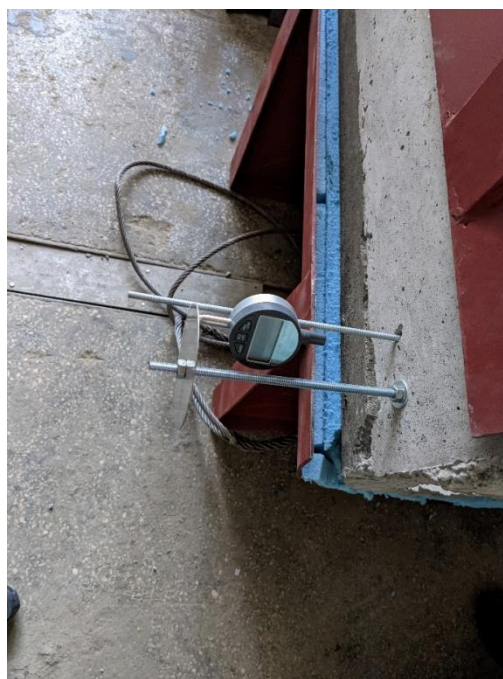
Рисунок 4.8 – Установка індикаторів для проведення випробувань
