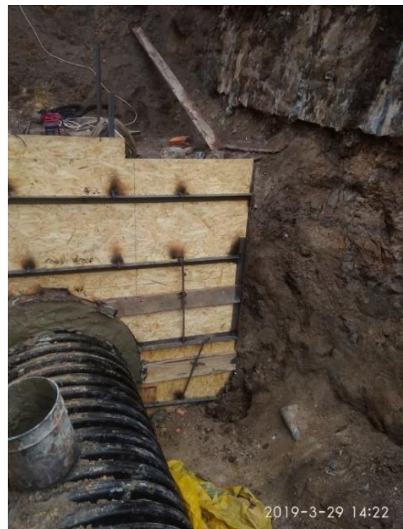
Рисунок 1.11 – Реконструкція колектора Д1000 мм, ХТЗ, м. Харків
