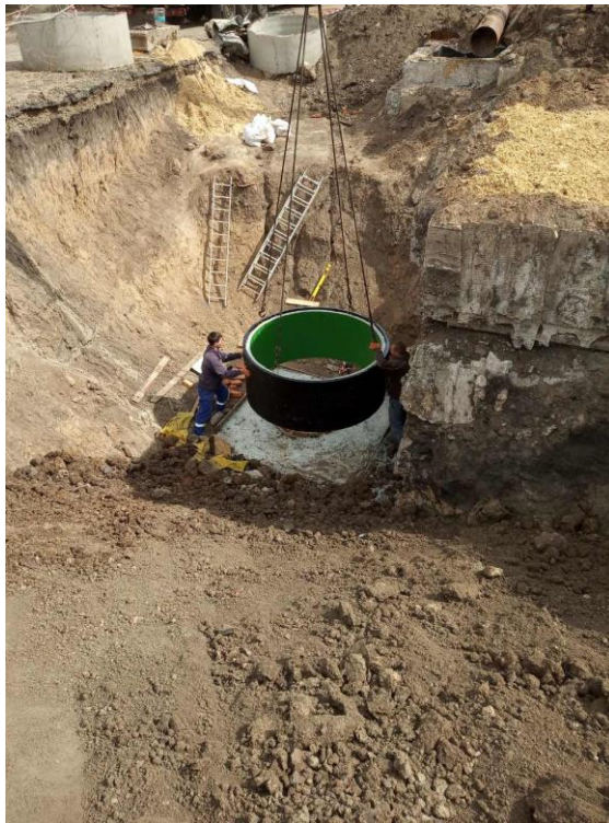
Рисунок 1.13 – Відновлення трубопроводами Корсис 1000 мм
