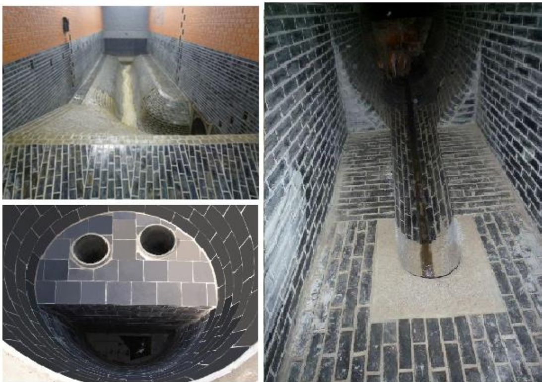
Рисунок 3.3 – Футерування внутрішньої поверхні каналізаційної мережі плиткою кам'яного лиття
