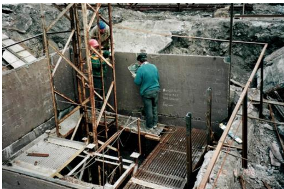
Рисунок 3.14 – Монтаж шлаколитих панелей
