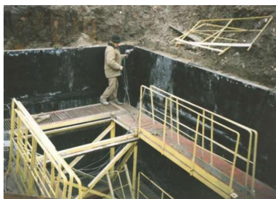
Рисунок 3.13 – Відновлення оглядової шахти з використанням ребристого поліетилену: а - фрагмент стінової панелі, облицьований ребристим поліетиленом; б - збирання панелей у монтажний блок; в - зварювання стиків профільованого поліетилену; г - шахта після облицювання
