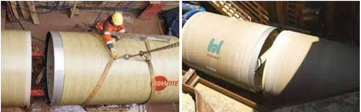
Рисунок 3.10 – Метод «труба в трубі» з використанням склопластикових труб фірм NOBAS
