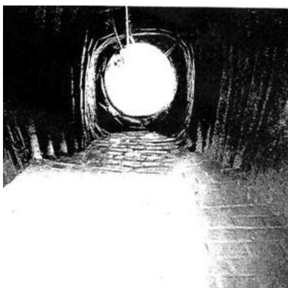
Рисунок 3.12 – Санація оглядової шахти за допомогою поліуретану: a – стан шахти до санації; б – нанесення поліуретану; в – шахта після санації
