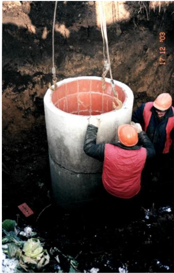
Рисунок 3.16 – Монтаж оглядового колодязя, облицьованого керамічною плиткою
