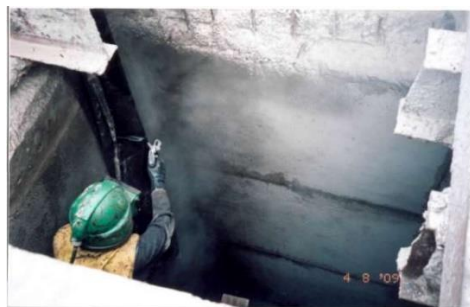
Рисунок 3.2 – Ремонт оглядової шахти з використанням методу «VMX-Базальт».
