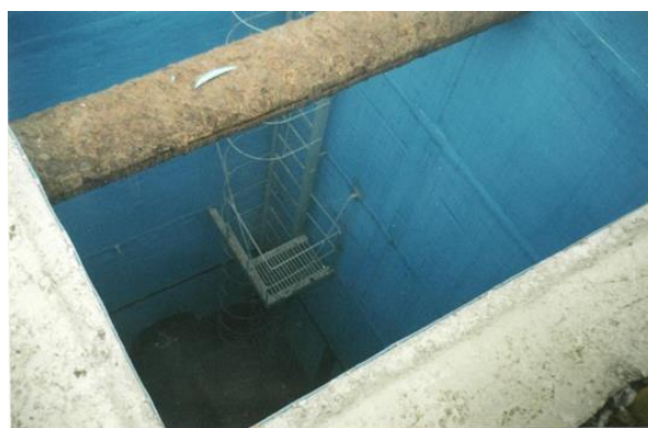
Рисунок 3.13 – Відновлення оглядової шахти з використанням ребристого поліетилену: а - фрагмент стінової панелі, облицьований ребристим поліетиленом; б - збирання панелей у монтажний блок; в - зварювання стиків профільованого поліетилену; г - шахта після облицювання
