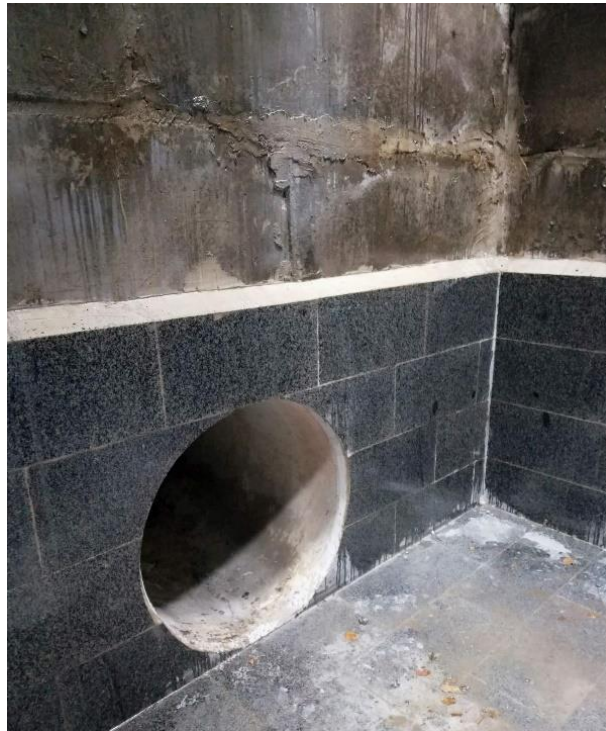
Рисунок 3.17 – Відновлена камера гасіння К-1 за допомогою керамогранітних плит
