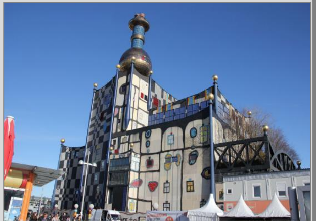
District Heating Plant Spittelau, Відень, Австрія
