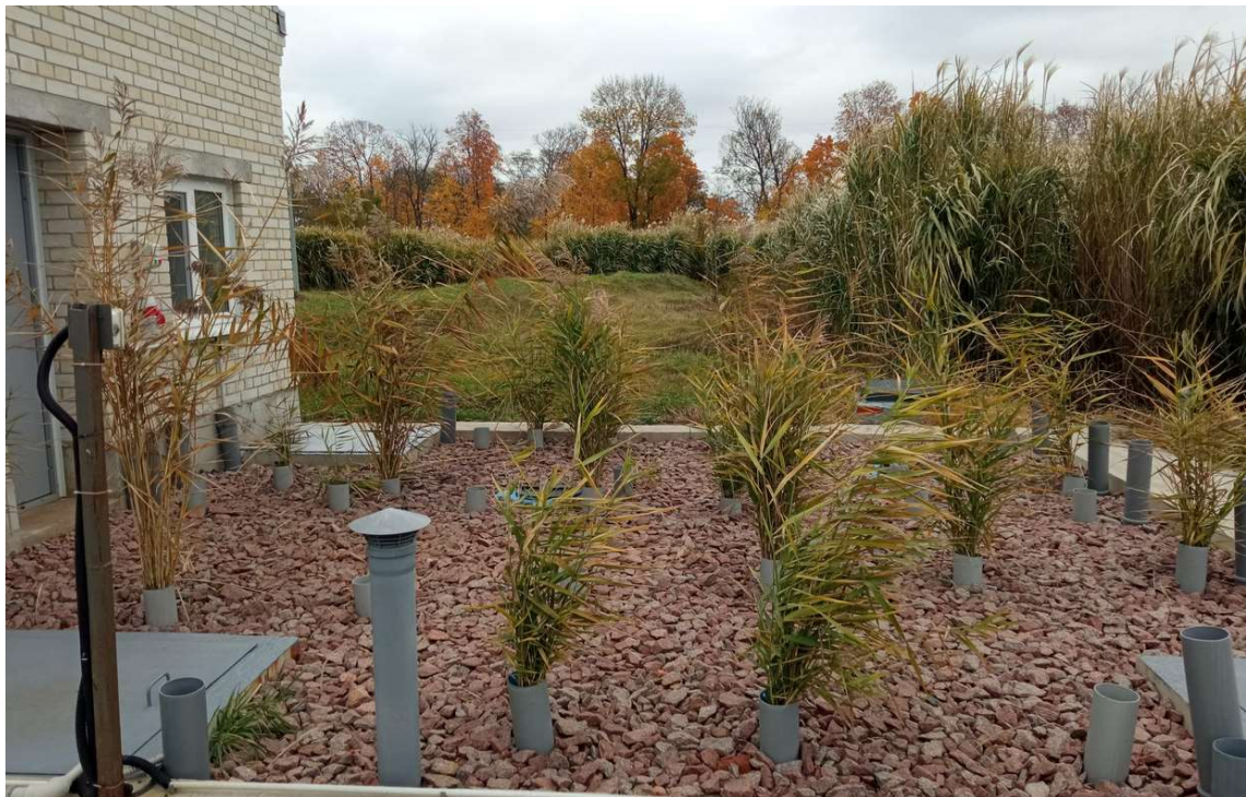
Рисунок 2. Загальний вид закритого біоплато гідропонного типу для доочищення стічних вод фармацевтичного виробництва
