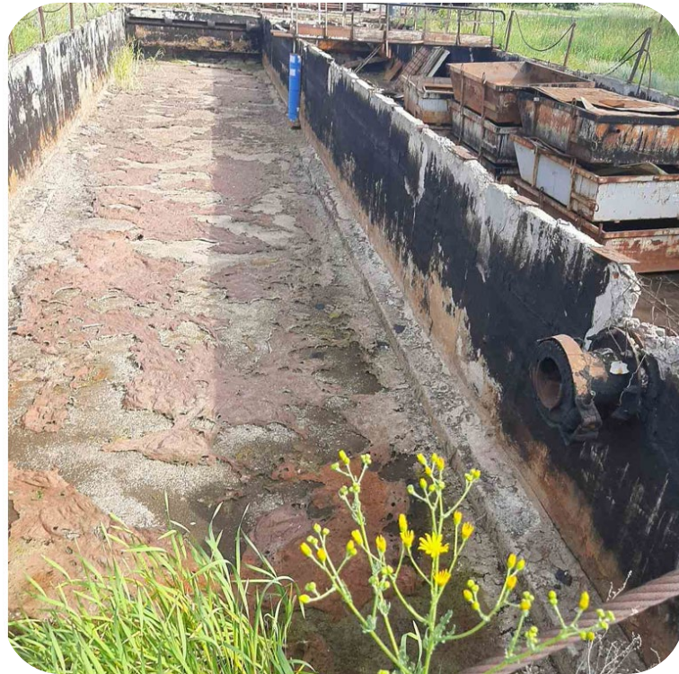
Рисунок 3.1 - Непрацююча нафтопастка, яка була в експлуатації понад 20 років (проба 1)
