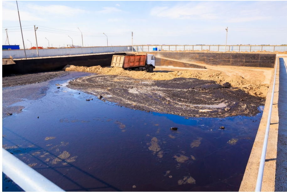
Рисунок 2.8 - Аварійний амбар скидання стічних вод нафтовидобувного комплексу
