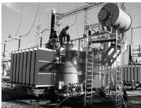
Рисунок 1 – Монтаж силового трансформатора 330/110 кВ
