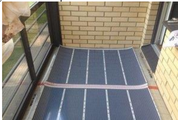
Рисунок 5.2 – Розташування плівкових інфрачервоних елементів
