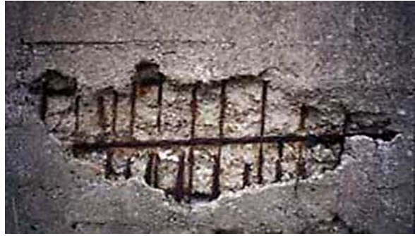
Рисунок 2.6 – Деформація фундаментів – вибоїни і поглиблення [47]
