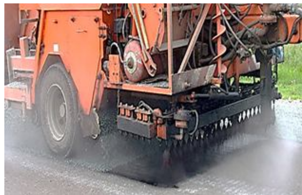
Рисунок 4.71 – Розливання бітуму та розподілення щебеня на покритті
