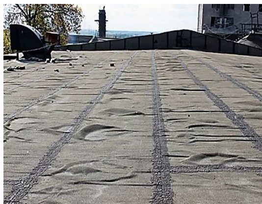
Рисунок 2.22 – Тріщини і здуття рулонного килима
