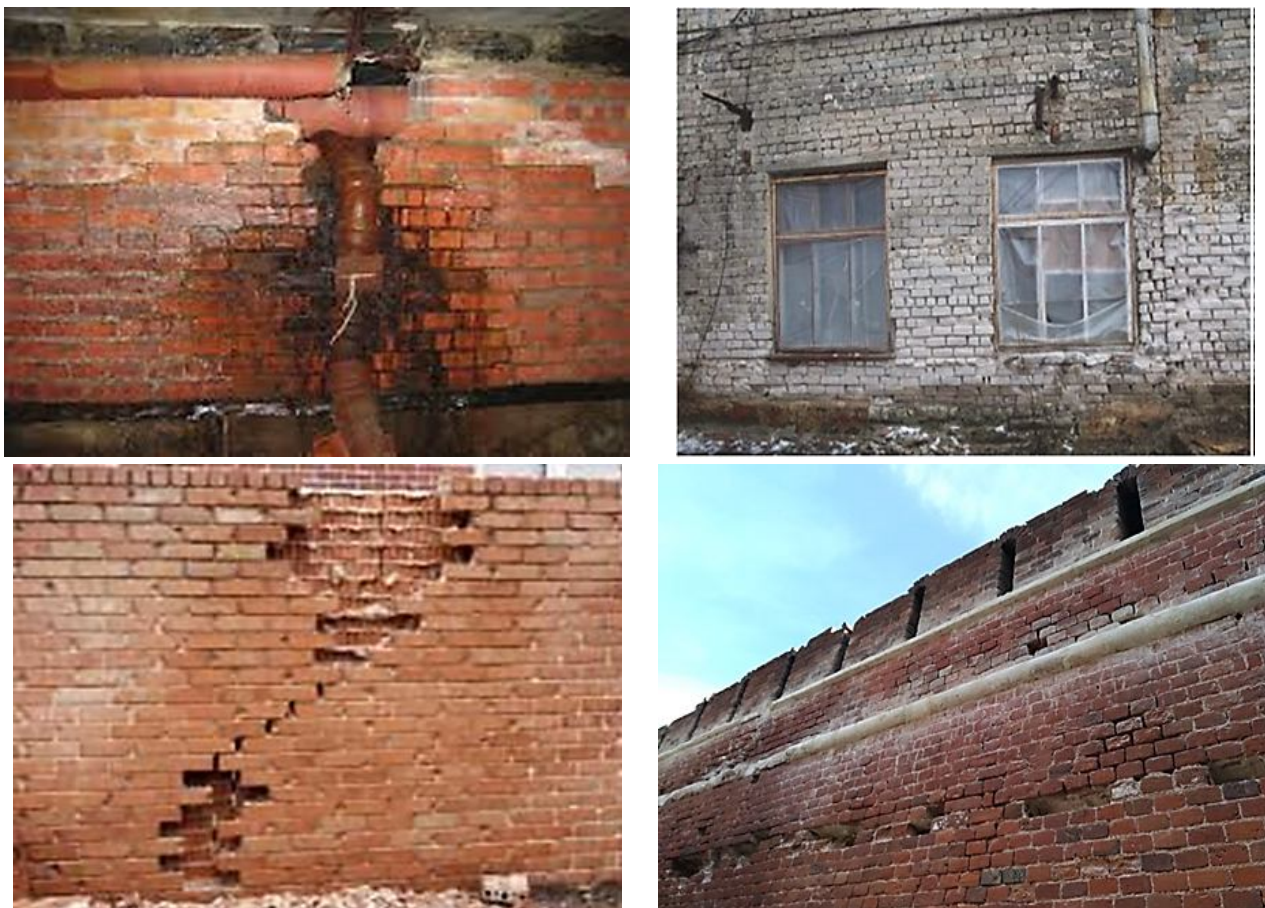
Рисунок 2.14 – Деформації, які виникають під час експлуатації будинків
