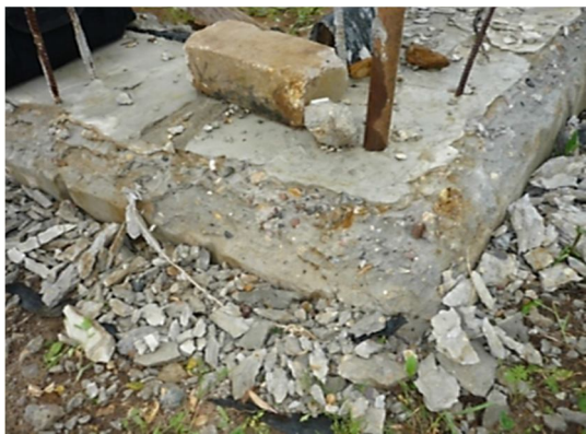
Рисунок 2.8 – Деформації фундаментів [47]
