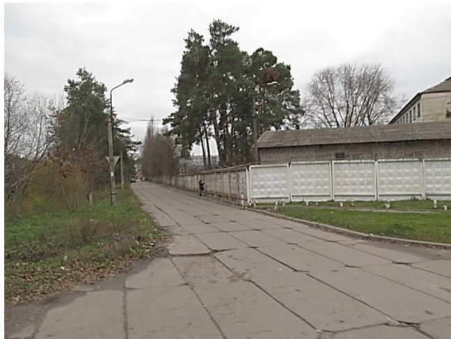
Рисунок 4.48 – Осідання (підняття) плит цементобетонного покриття
