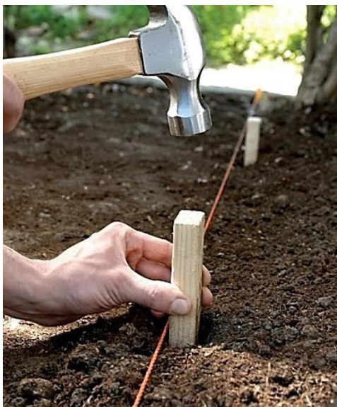
Рисунок 7.9 – Приклад перенесення проєкту «в натуру», закріплення основних ліній
