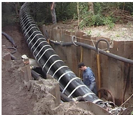
Рисунок 5.14 – Голландський досвід застосування профільних поліетиленових труб діаметром 950 мм для ремонту старого сталевго трубопроводу:
