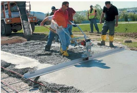
Рисунок 4.84 – Обладнання для ущільнення цементобетонної суміші:
