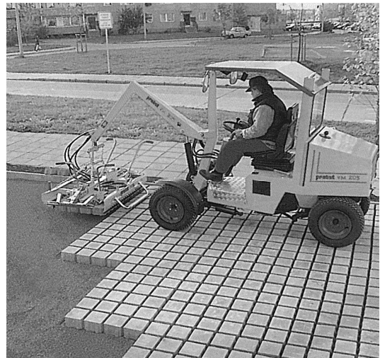
Рисунок 4.90 – Укладання тротуарних плит
