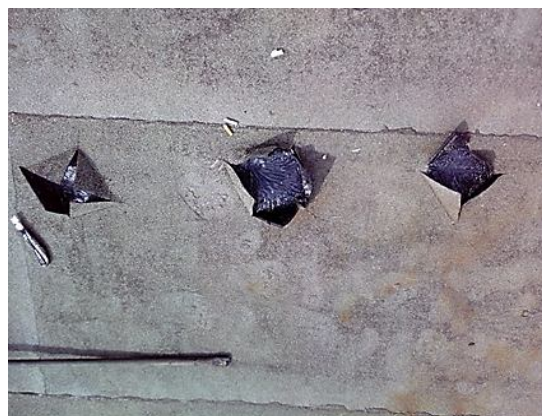
Рисунок 2.22 – Тріщини і здуття рулонного килима
