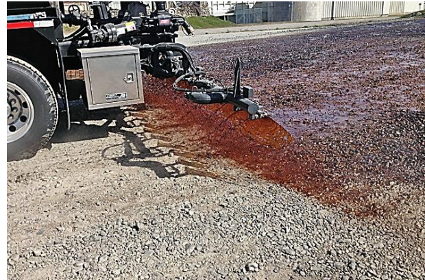
Рисунок 4.12 – Розливання лігносульфонатів [17]
