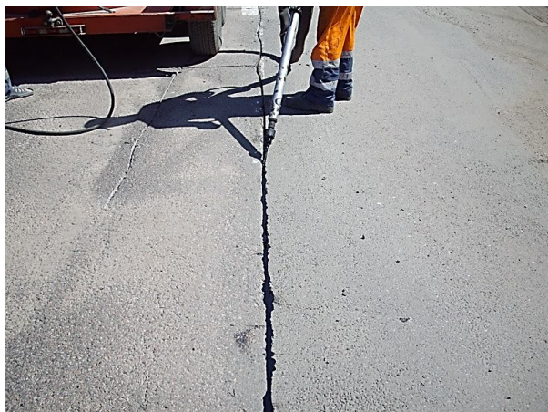
Рисунок 4.67 – Заливання тріщин рідким чи розрідженим бітумом або бітумною мастикою
