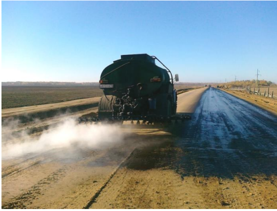
Рисунок 4.91 – Розливання вяжучого автогудронатором
