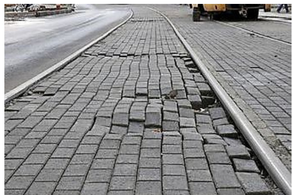
Рисунок 4.59 – Руйнування дорожнього покриття уздовж трамвайних колій
