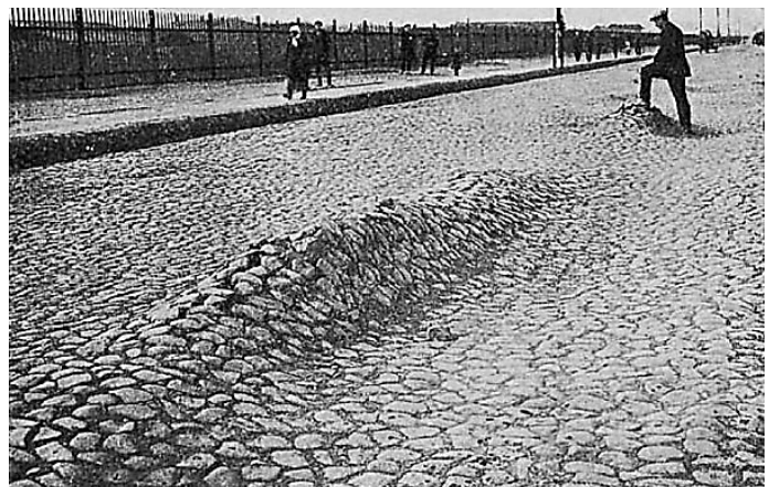
Рисунок 4.36 – Горби, що утворюються на бруківці внаслідок здимання [140]
