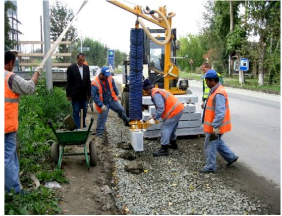
Рисунок 4.92 – Установка бортовых камней: а – ручным способом; б – механизированым способом
