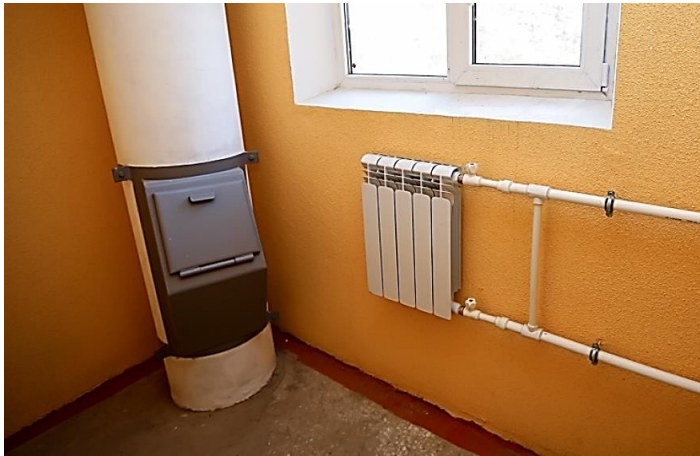
Рисуюнок 3.14 – Смітєпровід у багатоквартирному будинку
