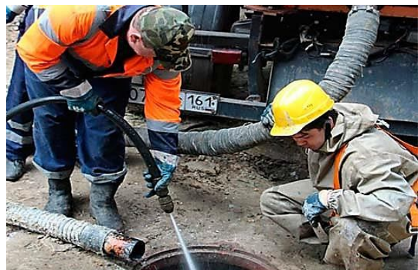
Рисунок 5.7 – Прочищення каналізації гідравлічним способом
