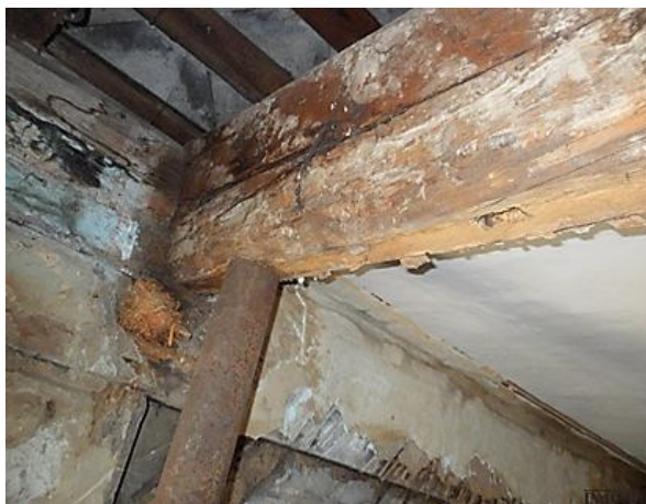
Рисунок 2.20 – Вузол опирання на цегляні стіни
