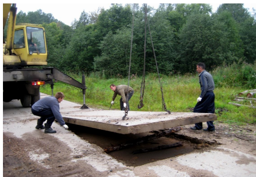
Рисунок 4.87 – Укладання залізобетонних плит збірного покриття:
