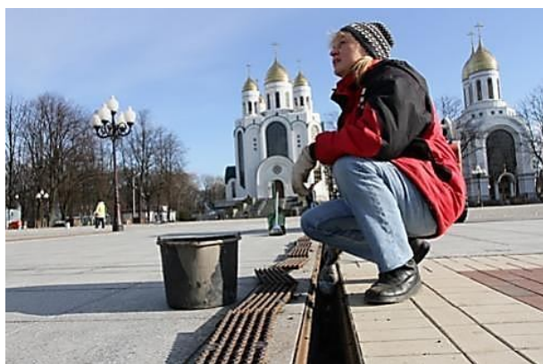
Рисунок 5.3 – Прочищення лотків навесні
