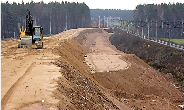
Рисунок 4.62 – Влаштування нового земляного полотна
