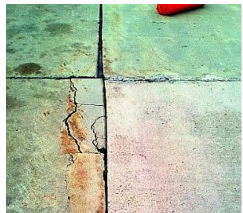
Рисунок 4.50 – Обламування кромки плит [135]
