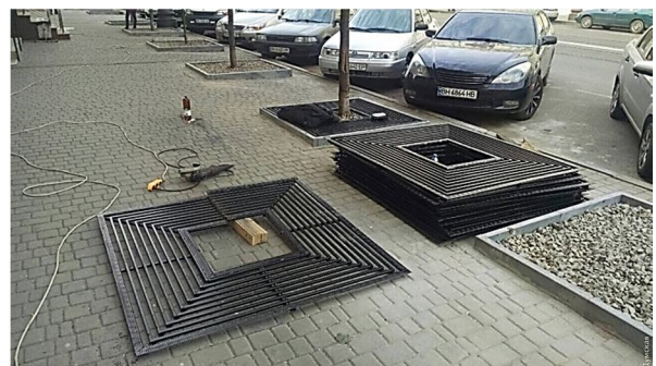
Рисунок 7.43 – Улаштування пристовбурних ґрат
