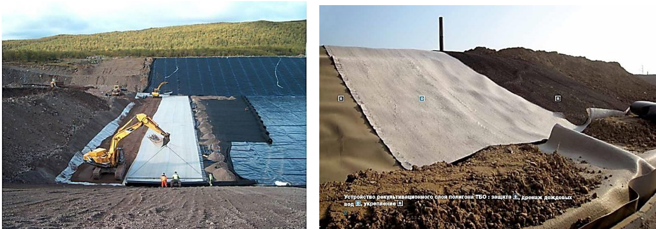
Рисунок 3.61 – Перекриття шарів сміття проміжними ізолюючими матеріалами
