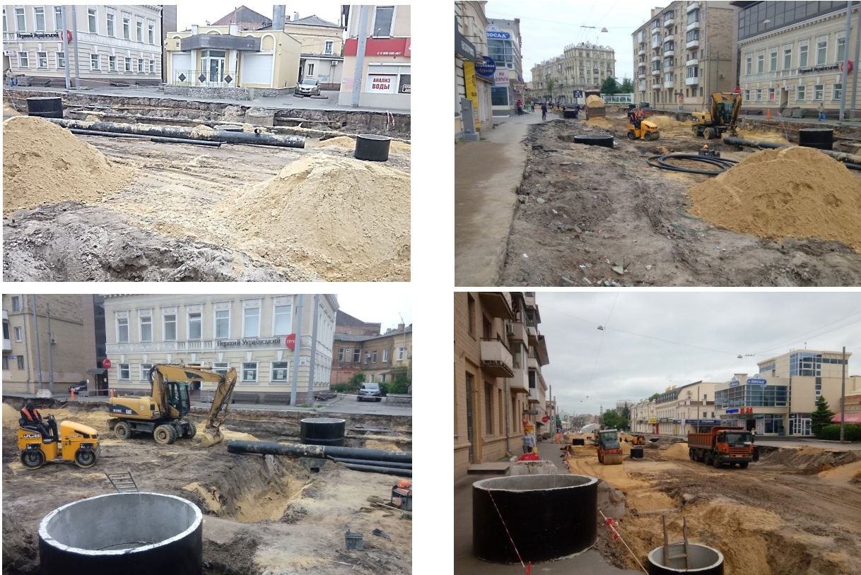
Рисунок 4.78 – Капітальний ремонт вулиці з повною заміною всього дорожнього одягу і закритої системи водовідведення
