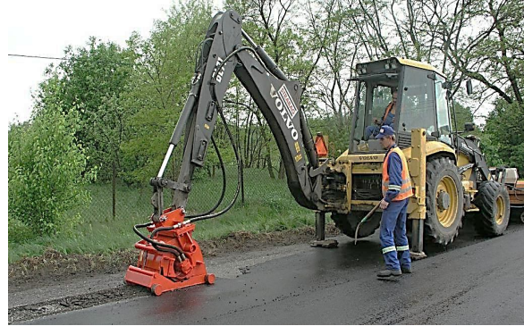
Рисунок 4.82 – Роботи під час дорожнього фрезерування: а – вирізання люків; б – нарізання траншей
