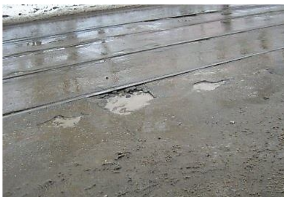
Рисунок 4.59 – Руйнування дорожнього покриття уздовж трамвайних колій
