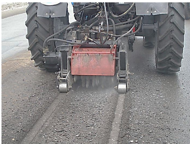
Рисунок 4.68 – Фрезерування покриття
