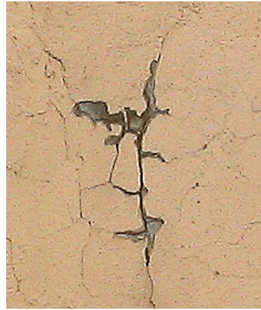
Рисунок 4.49 – Тріщини на цементобетонному покритті
