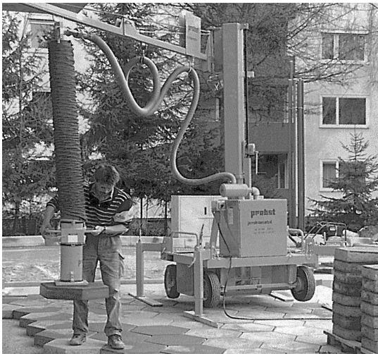
Рисунок 4.90 – Укладання тротуарних плит
