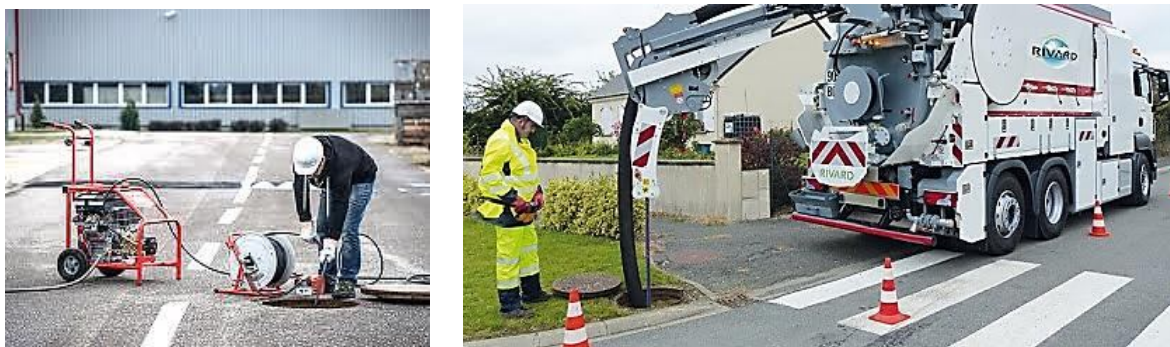
Рисунок 5.8 – Гідродинамічне очищення каналізації
