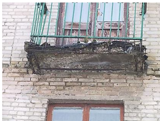
Рисунок 2.32 – Дефекти балконів
