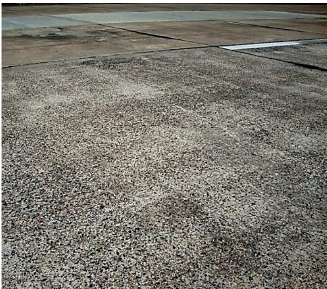
Рисунок 4.51 – Лушення цементобетонного покриття
