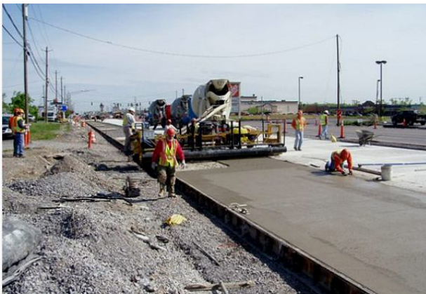
Рисунок 4.86 – Улаштування ділянки монолітного цементобетонного покриття
