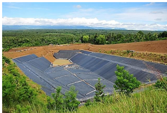
Рисунок 3.60 – Влаштування на дні та укосах полігону ТПВ протифільтраційних екранів із синтетичних матеріалів
