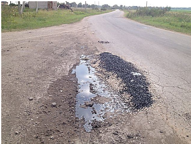
Рисунок 4.35 – Сітка тріщин у вигляді павутиння на асфальтобетонному покритті від здимання
