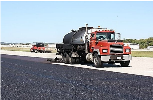
Рисунок 4.70 – Розливання бітуму автогудронатором
