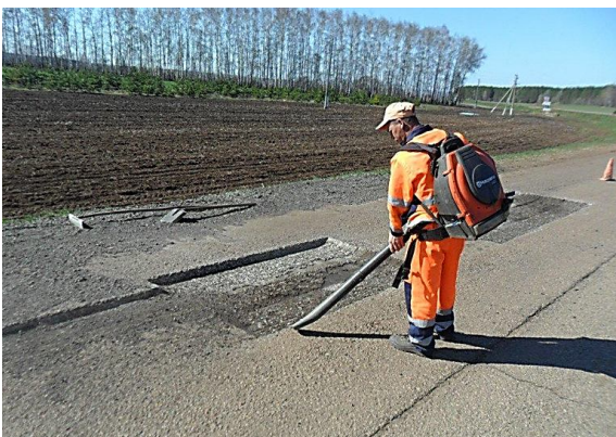
Рисунок 4.64 – Очищення ремонтної карти стисненим повітрям
