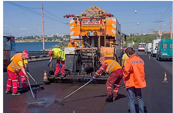
Рисунок 4.74 – Відновлення покриття ортотропної плити на Інгульському мосту в місті Миколаєві сучасною сумішшю «Мультимак»
