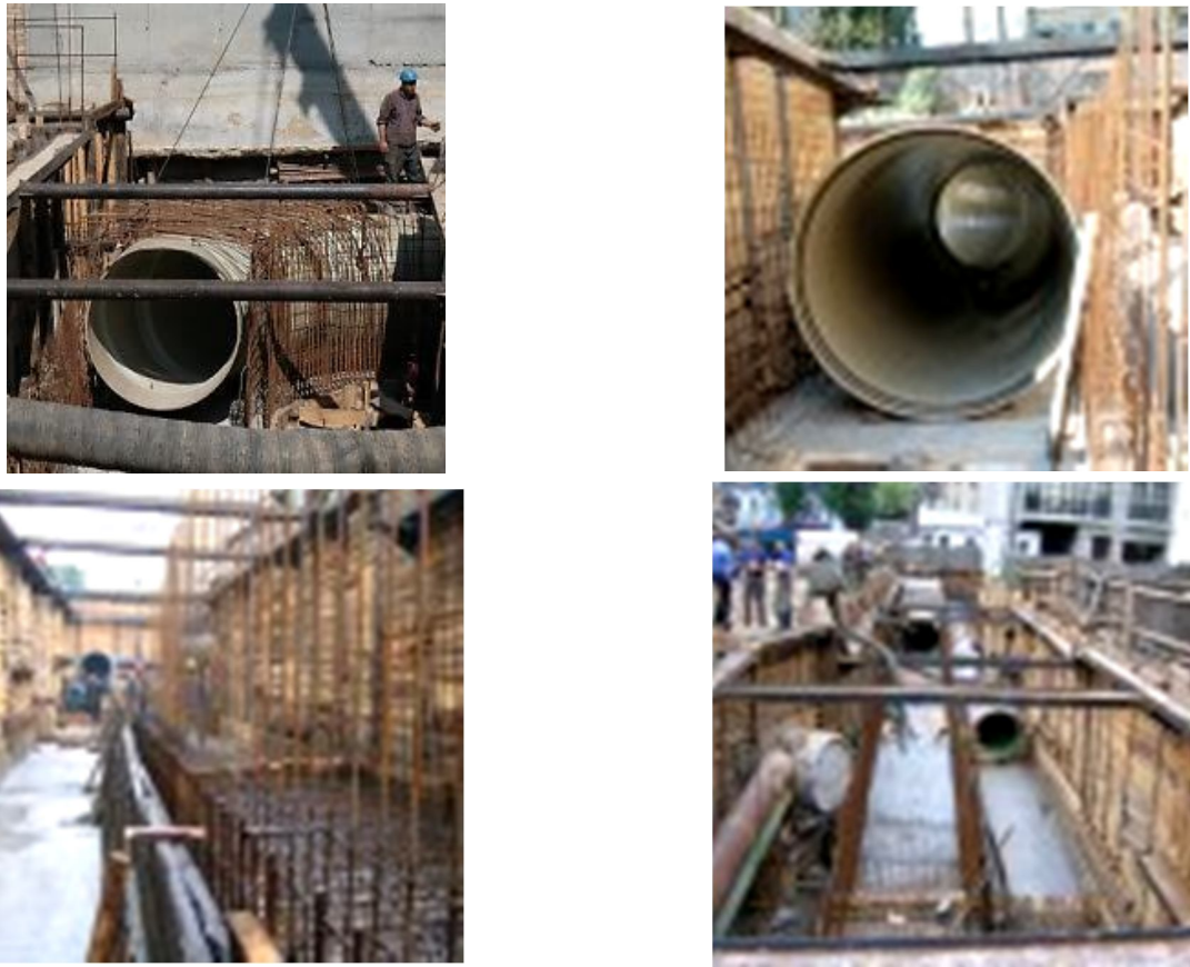
Рисунок 5.10 – Капітальний ремонт ділянки Лук'янівського колектора дощової каналізації
