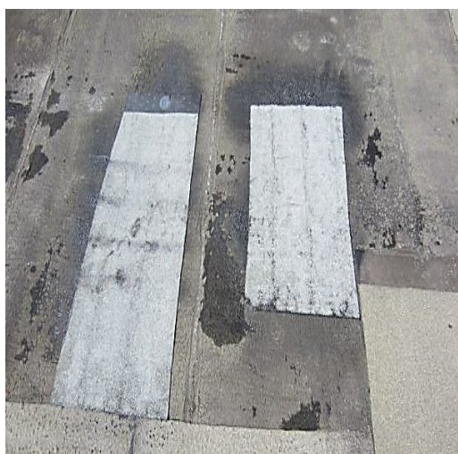
Рисунок 2.23 – Латочний ремонт рулонної крівлі
