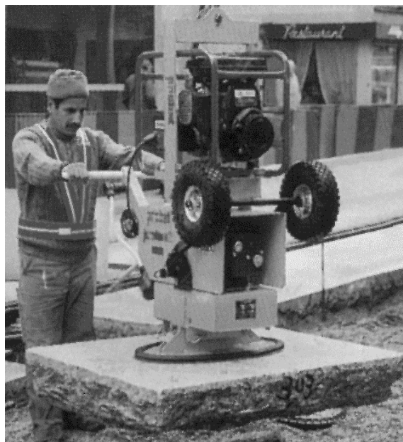
Рисунок 4.88 – Укладання бетонної плити
