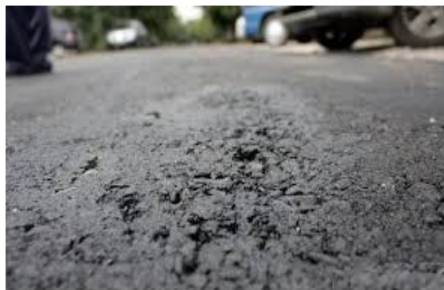
Рисунок 4.46 – Викришування асфальтобетонного покриття [22]
