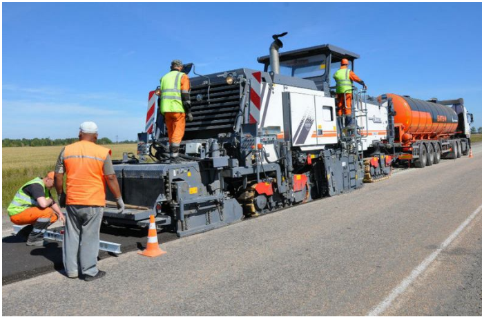
Рисунок 4.80 – Холодний ресайклінг видалення зруйнованих шарів дорожнього покриття [11].
