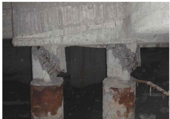
Рисунок 2.8 – Деформації фундаментів [47]
