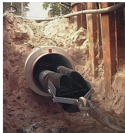
Рисунок 5.14 – Голландський досвід застосування профільних поліетиленових труб діаметром 950 мм для ремонту старого сталевго трубопроводу:
