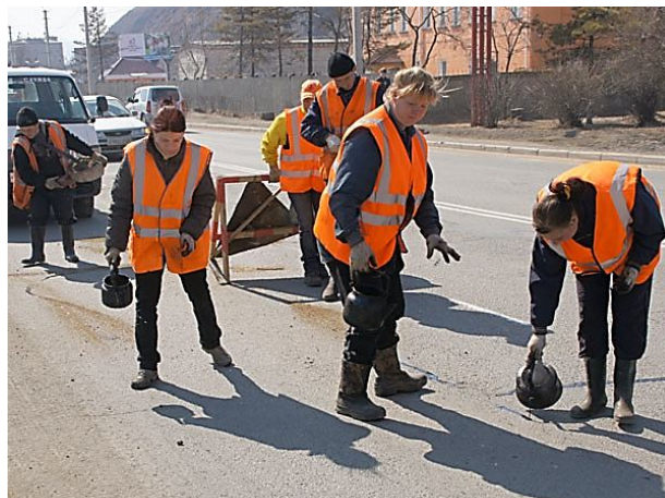
Рисунок 4.67 – Заливання тріщин рідким чи розрідженим бітумом або бітумною мастикою
