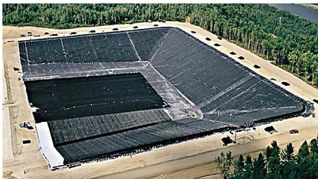
Рисунок 3.60 – Влаштування на дні та укосах полігону ТПВ протифільтраційних екранів із синтетичних матеріалів
