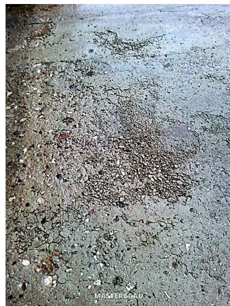
Рисунок 4.51 – Лушення цементобетонного покриття
