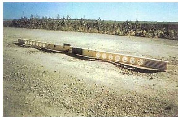
Рисунок 4.56 – Гребінка на щебеному покритті [37]
