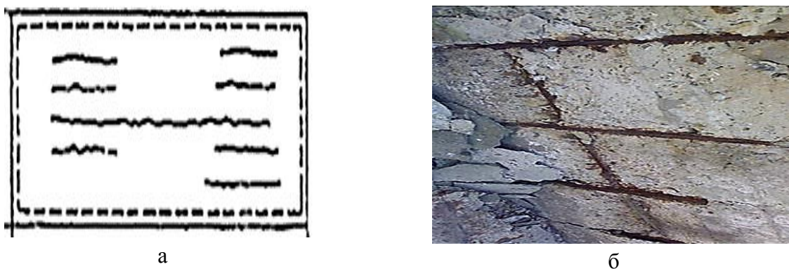
Рисунок 2.16 – Тріщини на нижній поверхні плит: а – основна схема; б – приклад дефекту [80]
