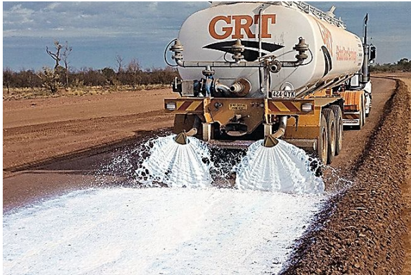
Рисунок 4.11 – Розливання хлористого кальцію [17]
