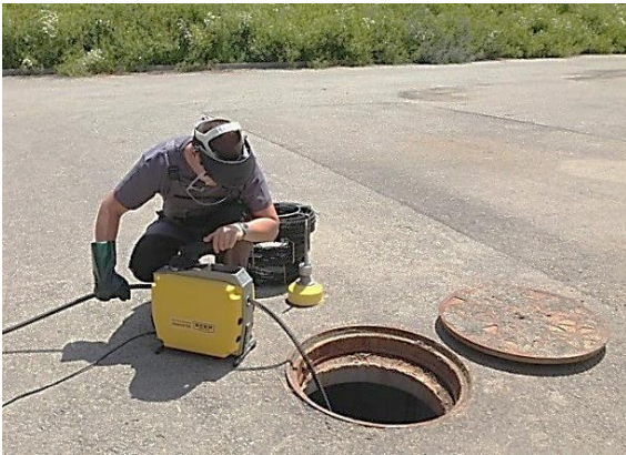
Рисунок 5.4 – Прочищення каналізації тросом
