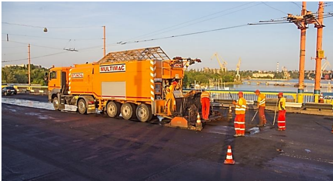
Рисунок 4.74 – Відновлення покриття ортотропної плити на Інгульському мосту в місті Миколаєві сучасною сумішшю «Мультимак»
