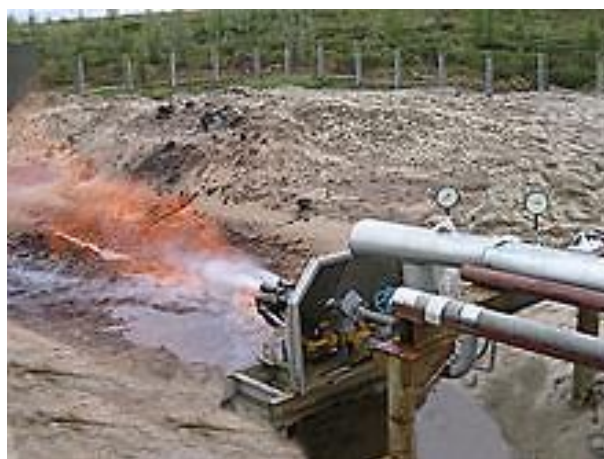
Рисунок 3.80 – Факельна установка для спалювання стоків
