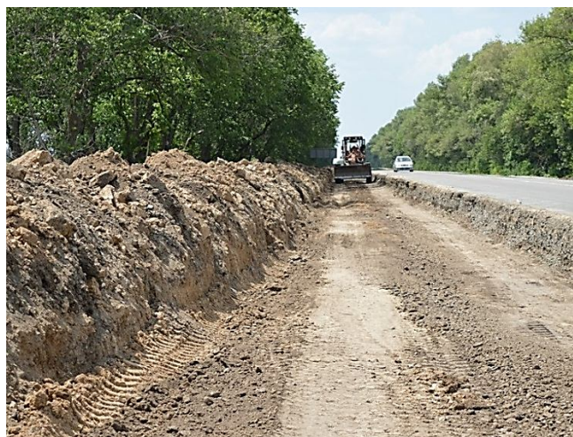
Рисунок 4.61 – Влаштування земляного полотна для додаткових смуг руху
