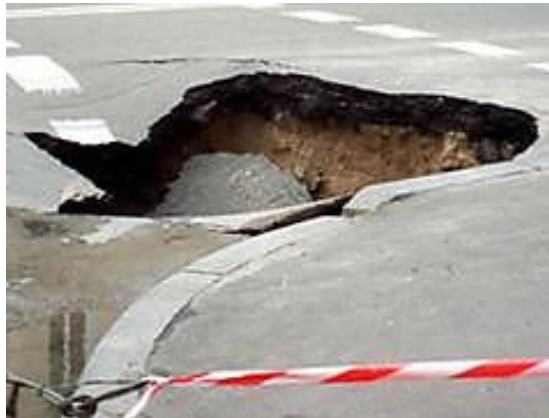
Рисунок 4.44 – Проломи на асфальтобетонному покритті
