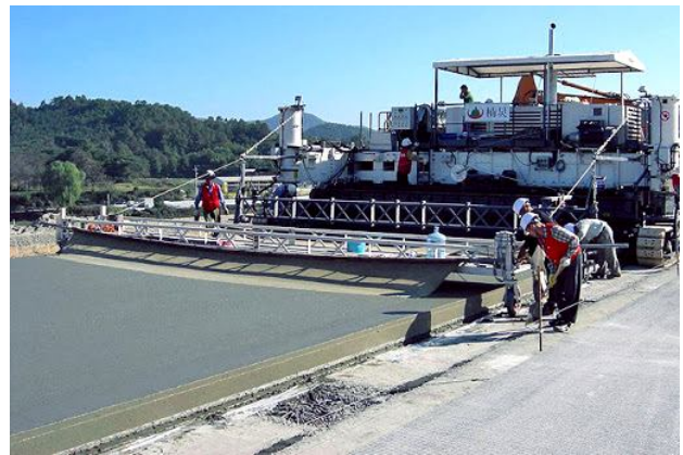
Рисунок 4.86 – Улаштування ділянки монолітного цементобетонного покриття
