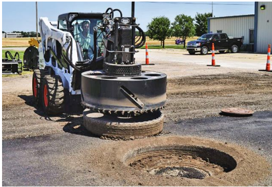
Рисунок 4.82 – Роботи під час дорожнього фрезерування: а – вирізання люків; б – нарізання траншей
