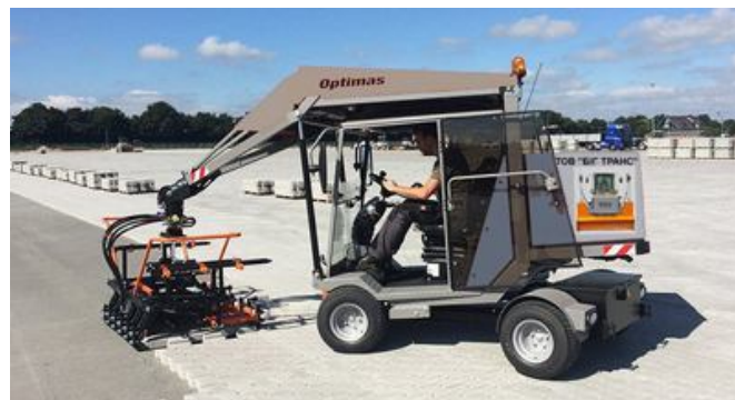
Рисунок 4.87 – Укладання залізобетонних плит збірного покриття:
