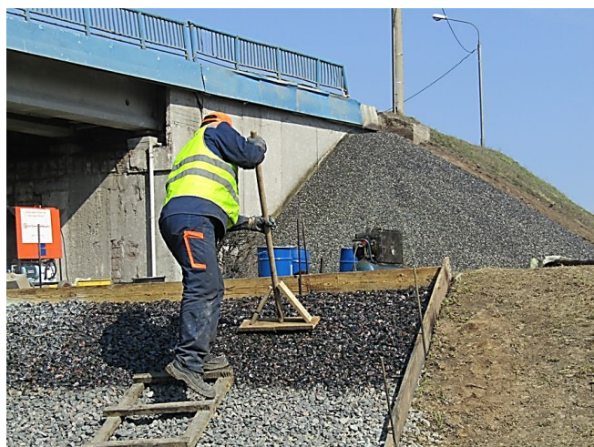
Рисунок 4.60 – Ремонт укосів земляного полотна
