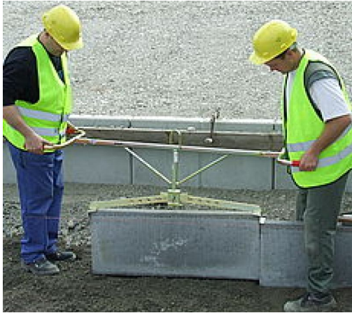
Рисунок 4.92 – Установка бортовых камней: а – ручным способом; б – механизированым способом
