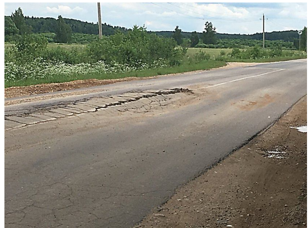
Рисунок 4.35 – Сітка тріщин у вигляді павутиння на асфальтобетонному покритті від здимання
