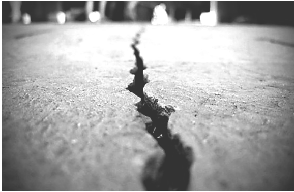
Рисунок 4.49 – Тріщини на цементобетонному покритті
