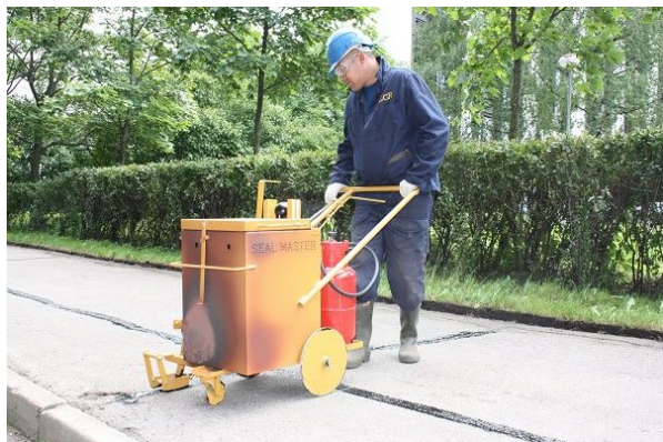
Рисунок 4.83 – Заливання тріщин на тротуарі
