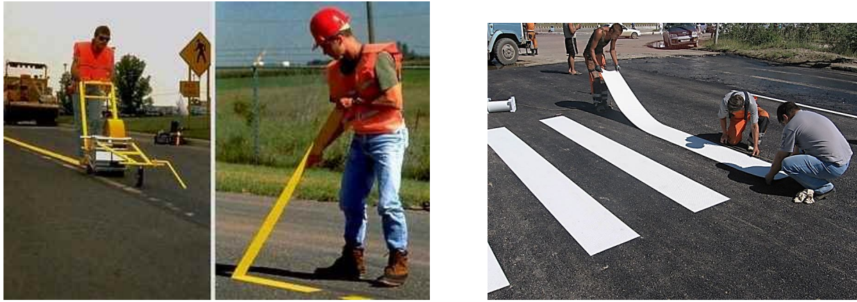
Рисунок 4.19 – Наклеювання полімерної стрічки
