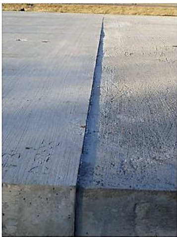
Рисунок 4.48 – Осідання (підняття) плит цементобетонного покриття
