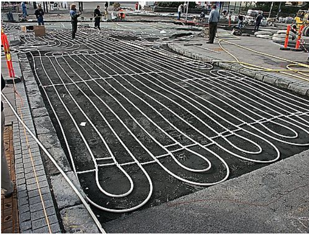
Рисунок 4.34 – Глибинний обігрів за допомогою нагрівальних кабелів
