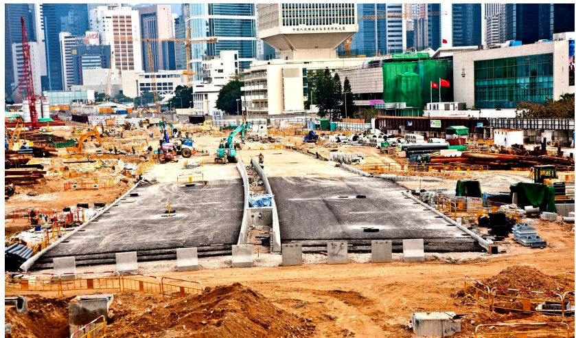
Рисунок 4.94 – Сучасне будівництво доріг у Китаї
