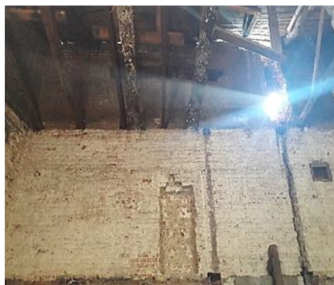
Рисунок 2.19 – Дефекти дерев'яних балок
