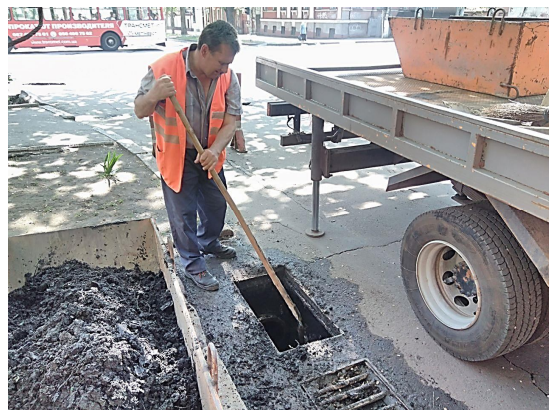
Рисунок 5.5 – Видалення осаду із зливової каналізації
