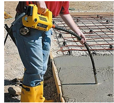
Рисунок 4.84 – Обладнання для ущільнення цементобетонної суміші:
