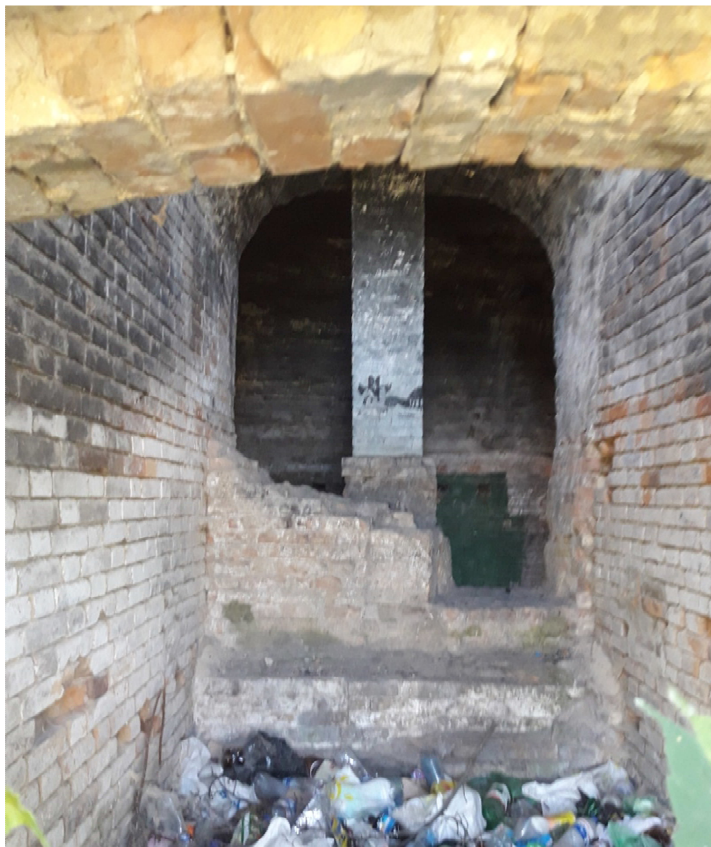
Внутрішній вид споруди. Світлина 2018 р.
