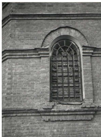
Віконний отвір першого ярусу апсиди
