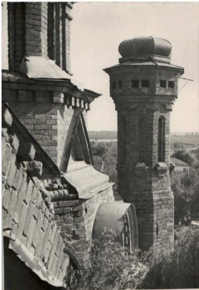
Завершення димохідного каналу
