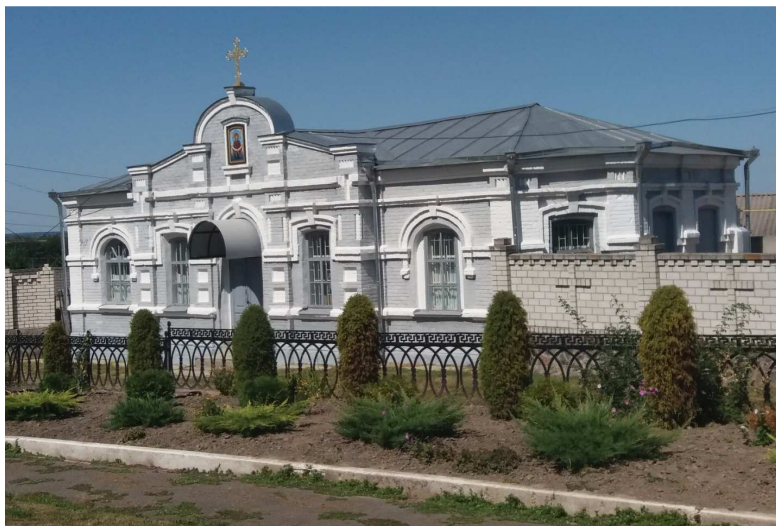
Головний фасад (південний фасад)
