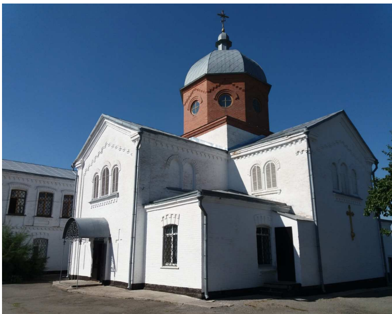
Фрагменти східного фасаду будівлі. Тепла церква Преображення господня
