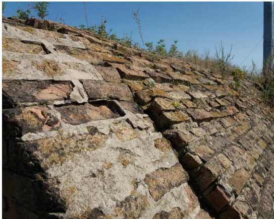
Обвалування споруди та арковий свод
