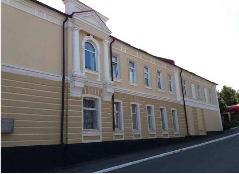
Фасад будівлі по вулиці Монастирській
