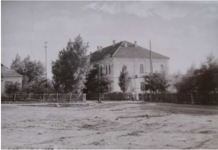
Районна лікарня (сестринські келії до 1929 р., нині терапевтичне відділення центральної районної лікарні), 1968 р.
