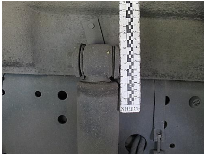
Рисунок В.34 – Детальний вигляд верхнього кріплення амортизатора правого переднього колеса автомобіля MAN TGM
