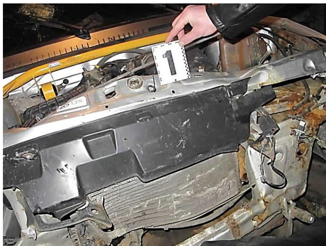
Рисунок 3.98 – Загальний вигляд дійсного стану пошкодженої верхньої поперечини рамки радіатора автомобіля ВАЗ-21134
