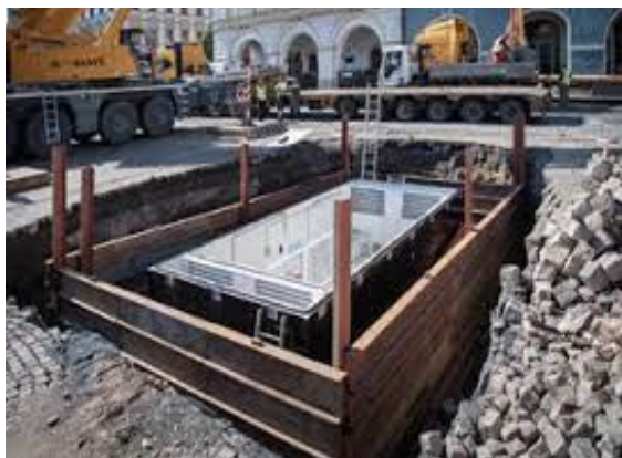
Рис. 1. Підземна тягова підстанція. Етап будівництва
