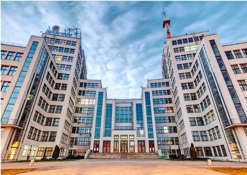
Рисунок 69 – Будівля Харківського Госпрому – найвідоміший зразок архітектури конструктивізму
