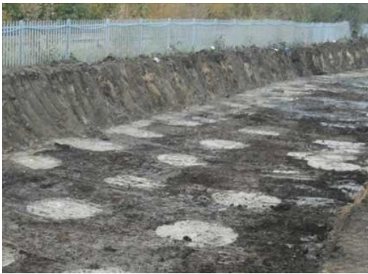
Рисунок 3 - Підсилення основи вертикальними ґрунтоцементними елементами.
