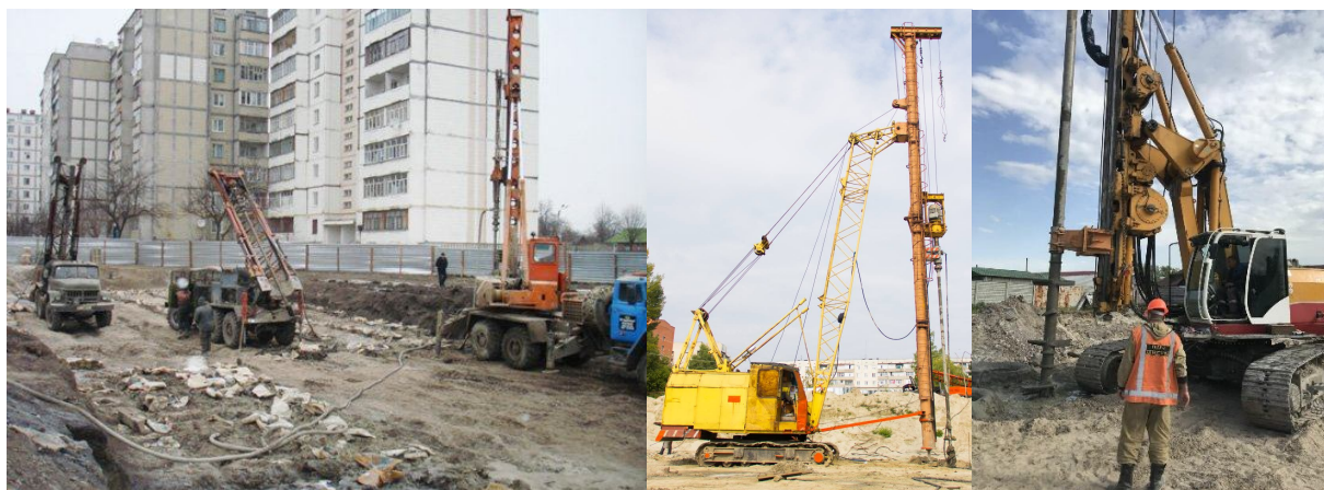
Рисунок 2 – Дослідний агрегат АГС-7 для влаштування а – бурові машини МРК-750-А4 та БМ-811; б – бурове обладнання на базі РДК-250; в - Bauer BG-25 зі спецобладнанням
