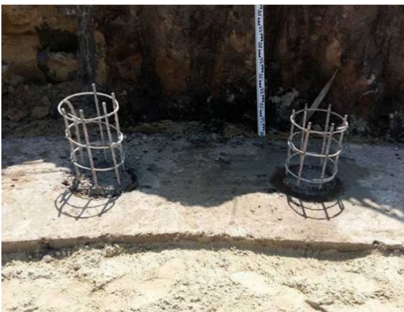
Рисунок 4 – Армована ґрунтоцементна паля.
