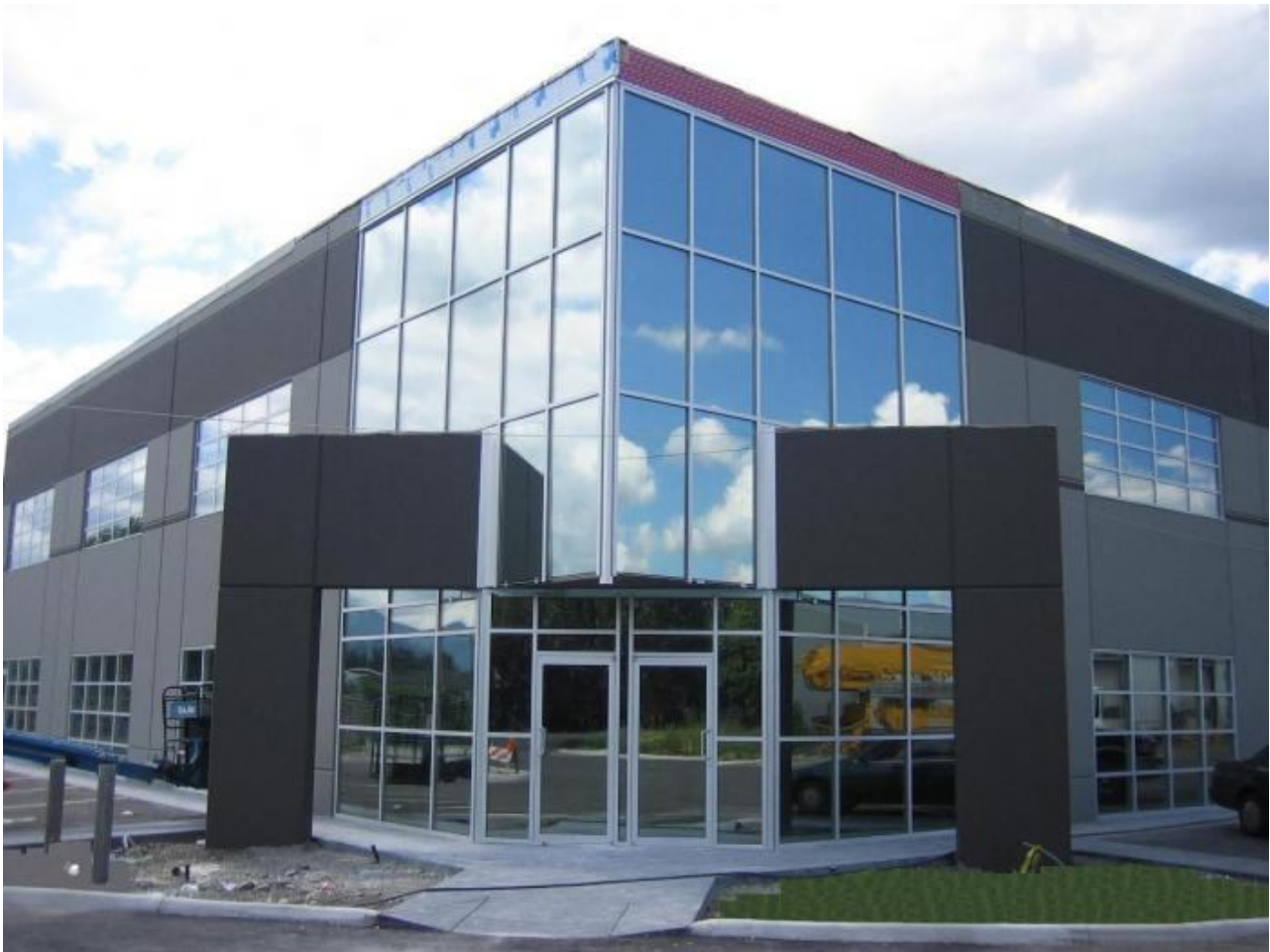
Рисунок 7.59 – Світлопрозорі фасадні системи
