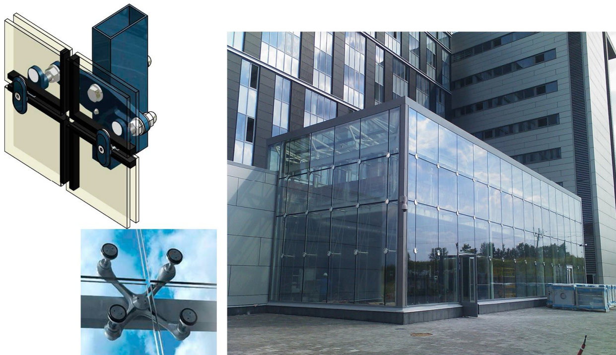
Рисунок 7.60 – Стояково-ригельна система світлопрозорих фасадних систем
