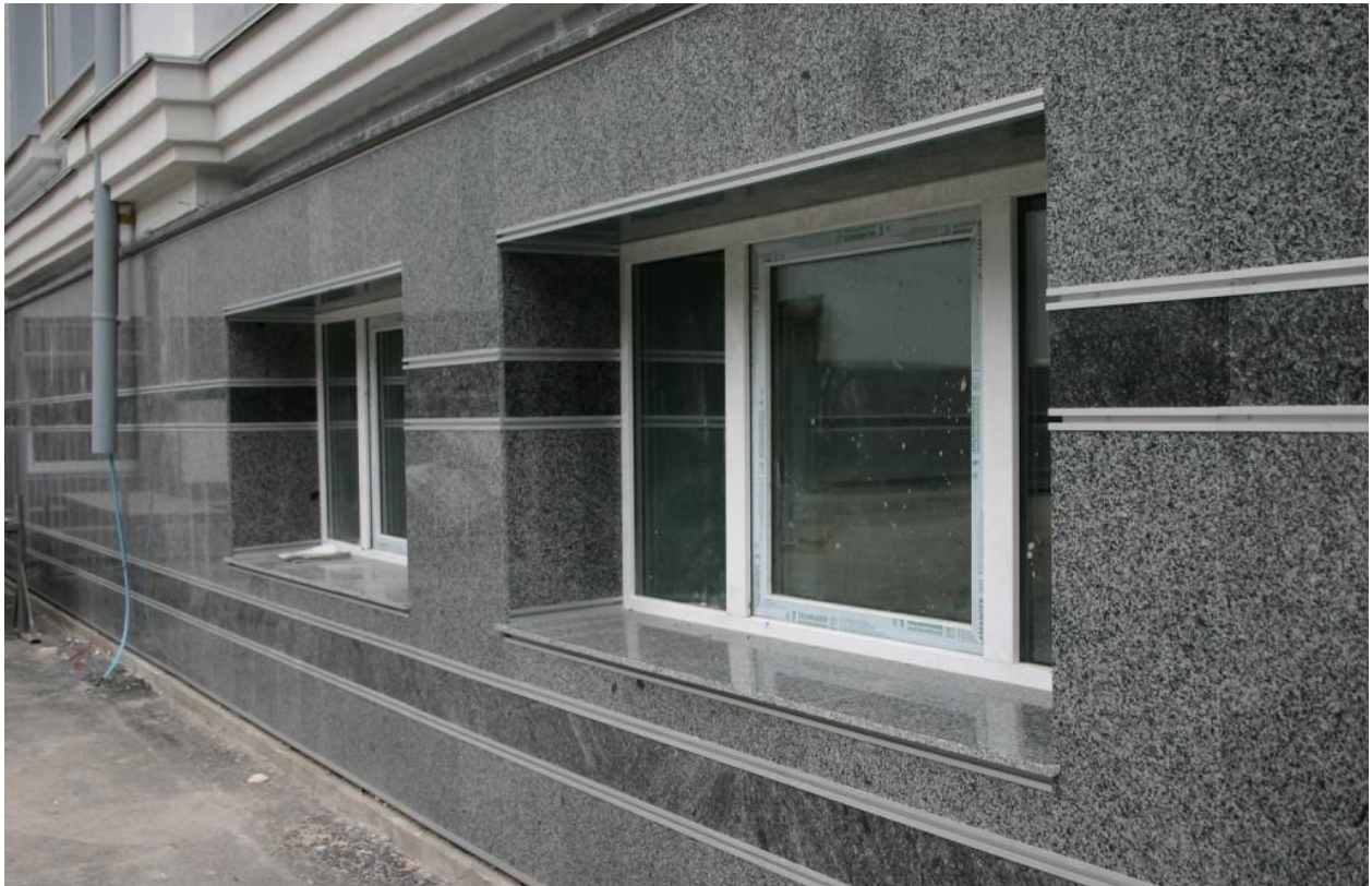
Рисунок 7.57 – Облицювання фасаду натуральним каменем
