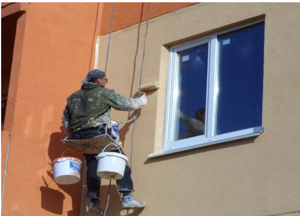
Рисунок 4.10 – Фарбування фасада за допомогою валика
