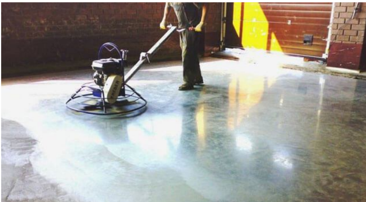
Рисунок 6.34 – Шліфування наливної підлоги
