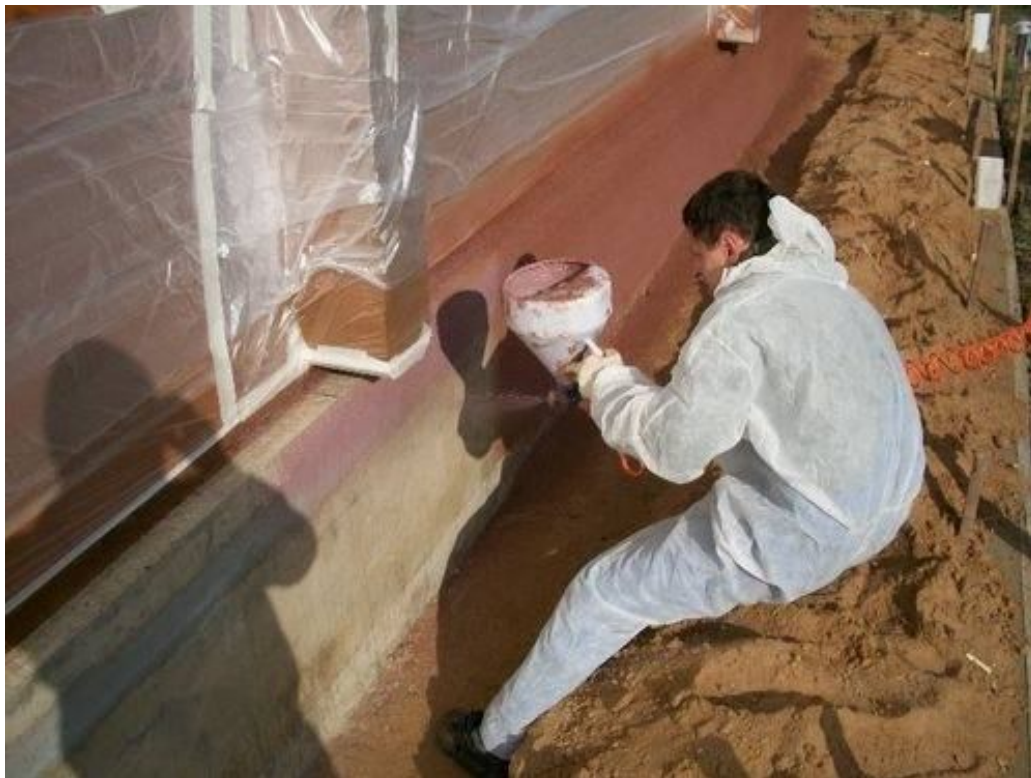
Рисунок 3.27 – Декоративне тинькування з обробленням під набрызк
