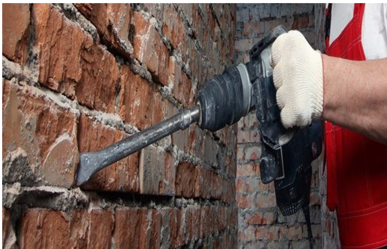
Рисунок 3.3 – Насікання поверхонь цегляних стін
