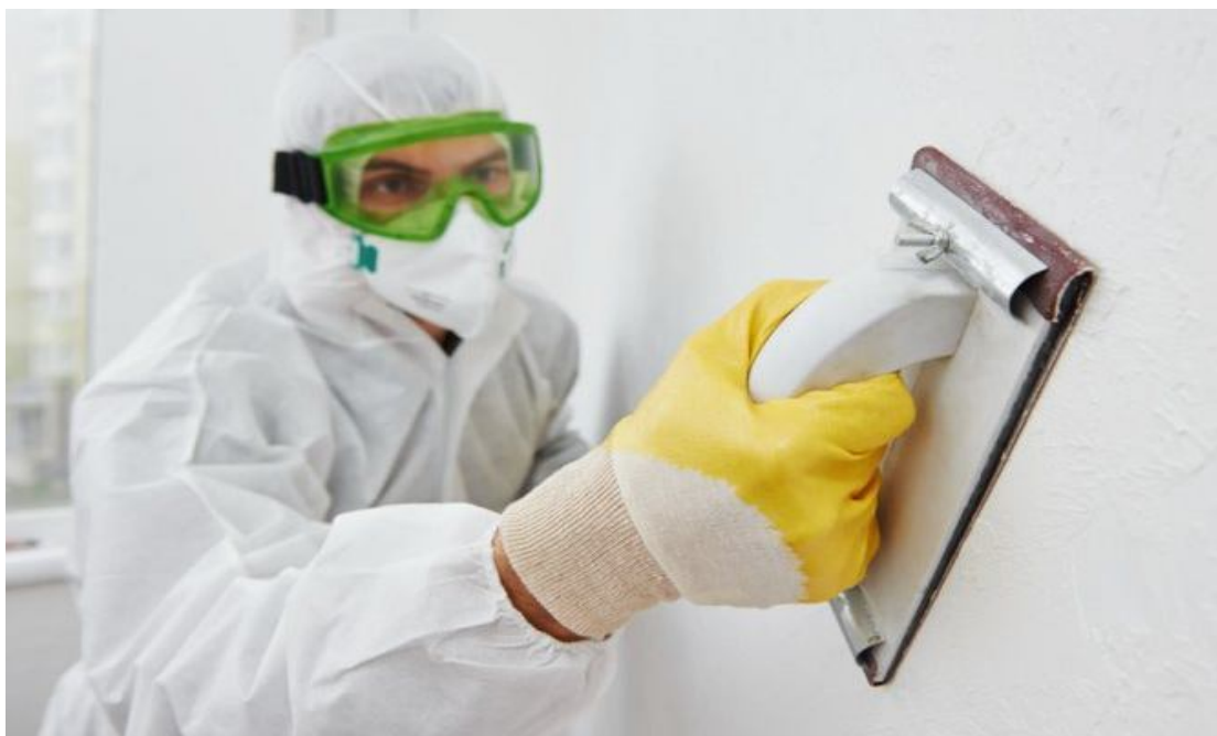
Рисунок 4.5 – Шліфування поверхонь вручну
