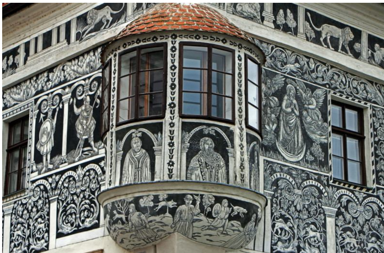
Рисунок 7.3 – Тинькування сграфіто
