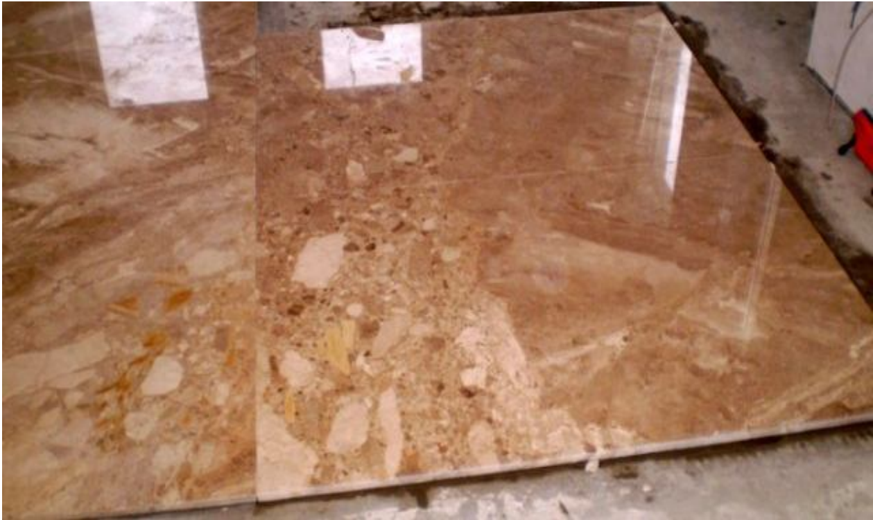
Рисунок 6.21 – Укладання мармурових плит на розчин
