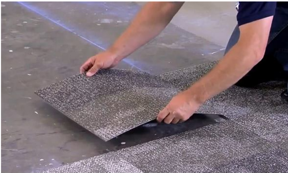
Рисунок 6.17 – Укладання килимової плитки
