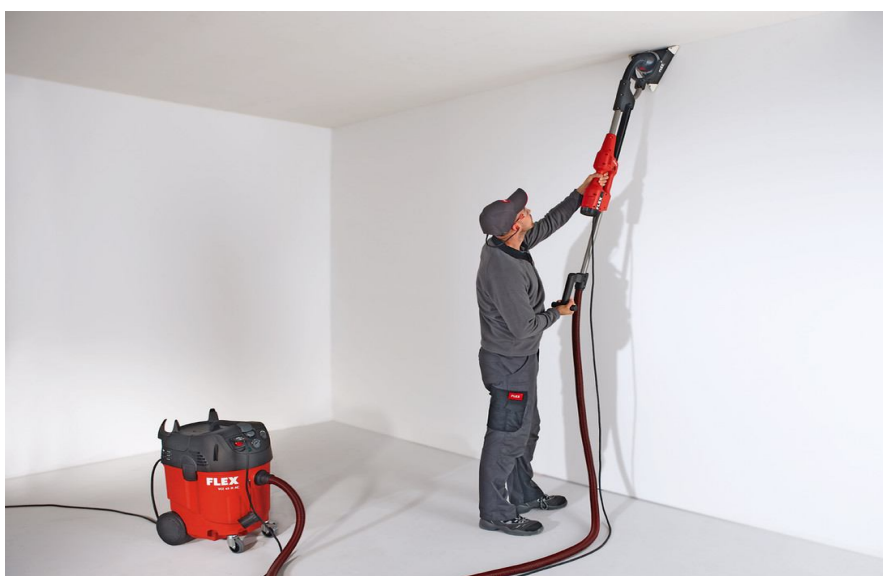
Рисунок 4.6 – Шліфування поверхонь за допомогою віброшліфувальних машин
