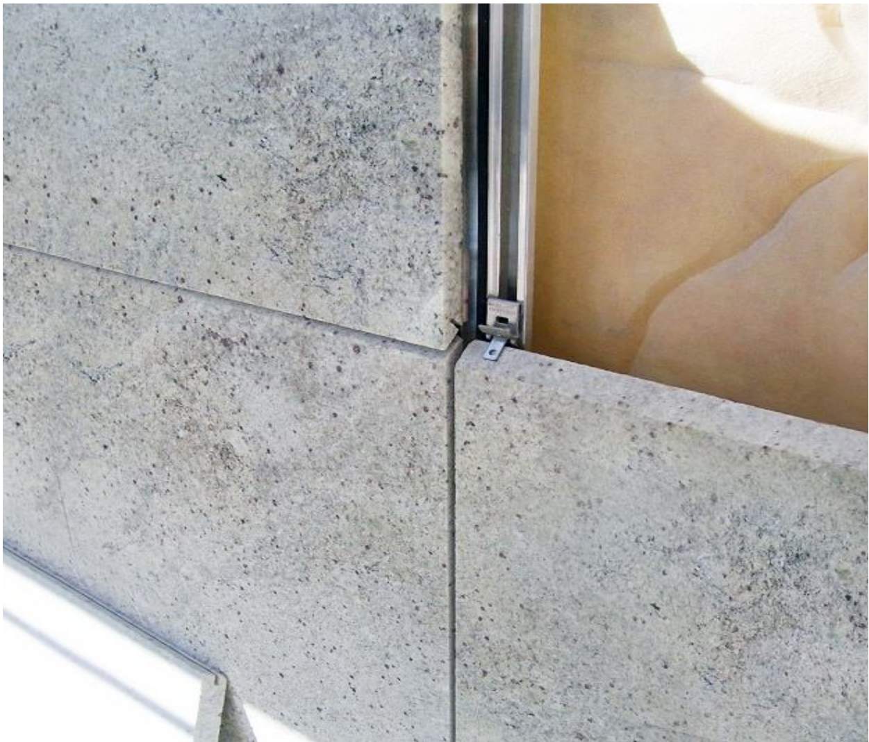
Рисунок 7.29 – Монтаж облицювання вентиляваного фасаду
