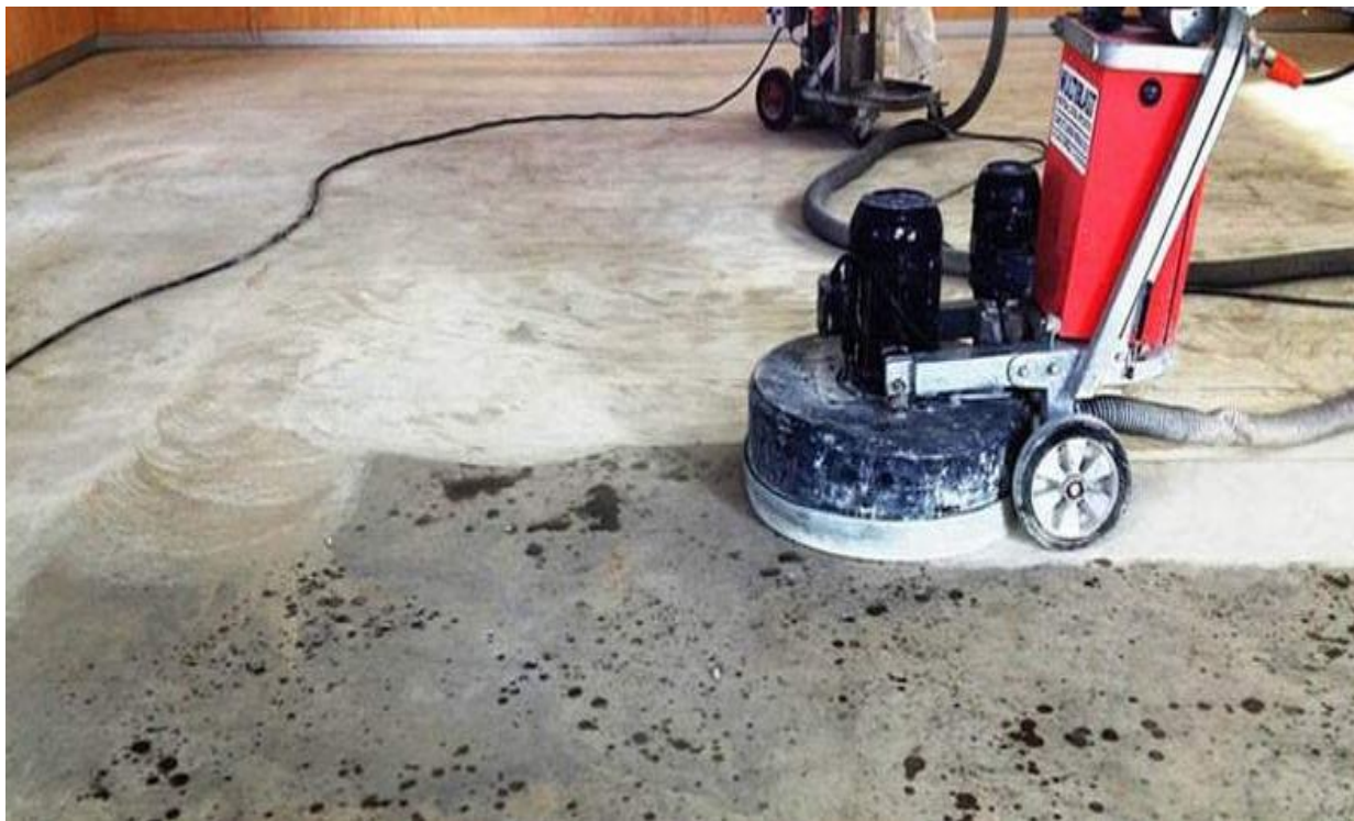
Рисунок 6.27 – Шліфування мозаїчної підлоги
