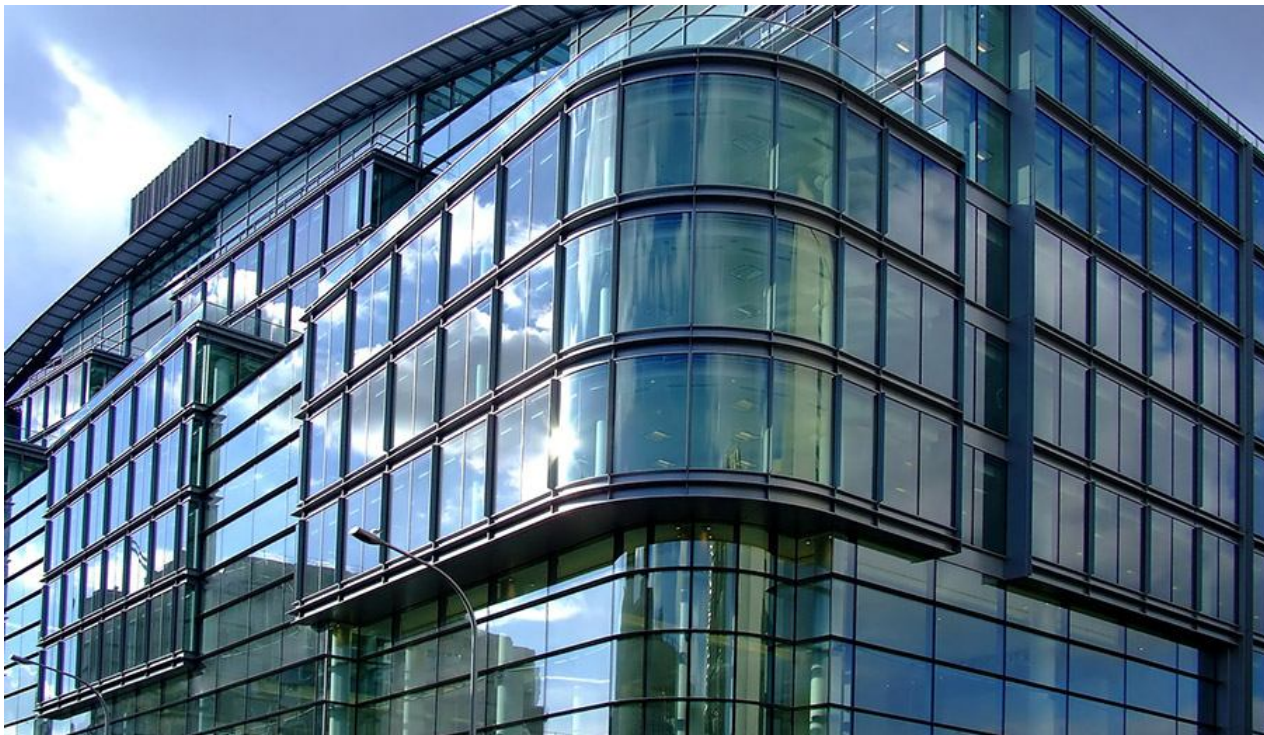
Рисунок 7.65 – Фасадна система з використанням стояково-ригельної конструкції
