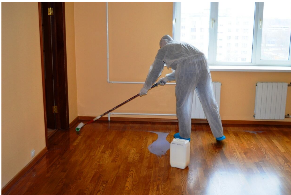
Рисунок 6.51 – Покриття лаком паркетної підлоги
