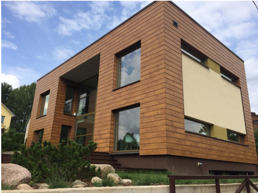
Рисунок 7.53 – Обличкування фасаду ламінованими панелями
