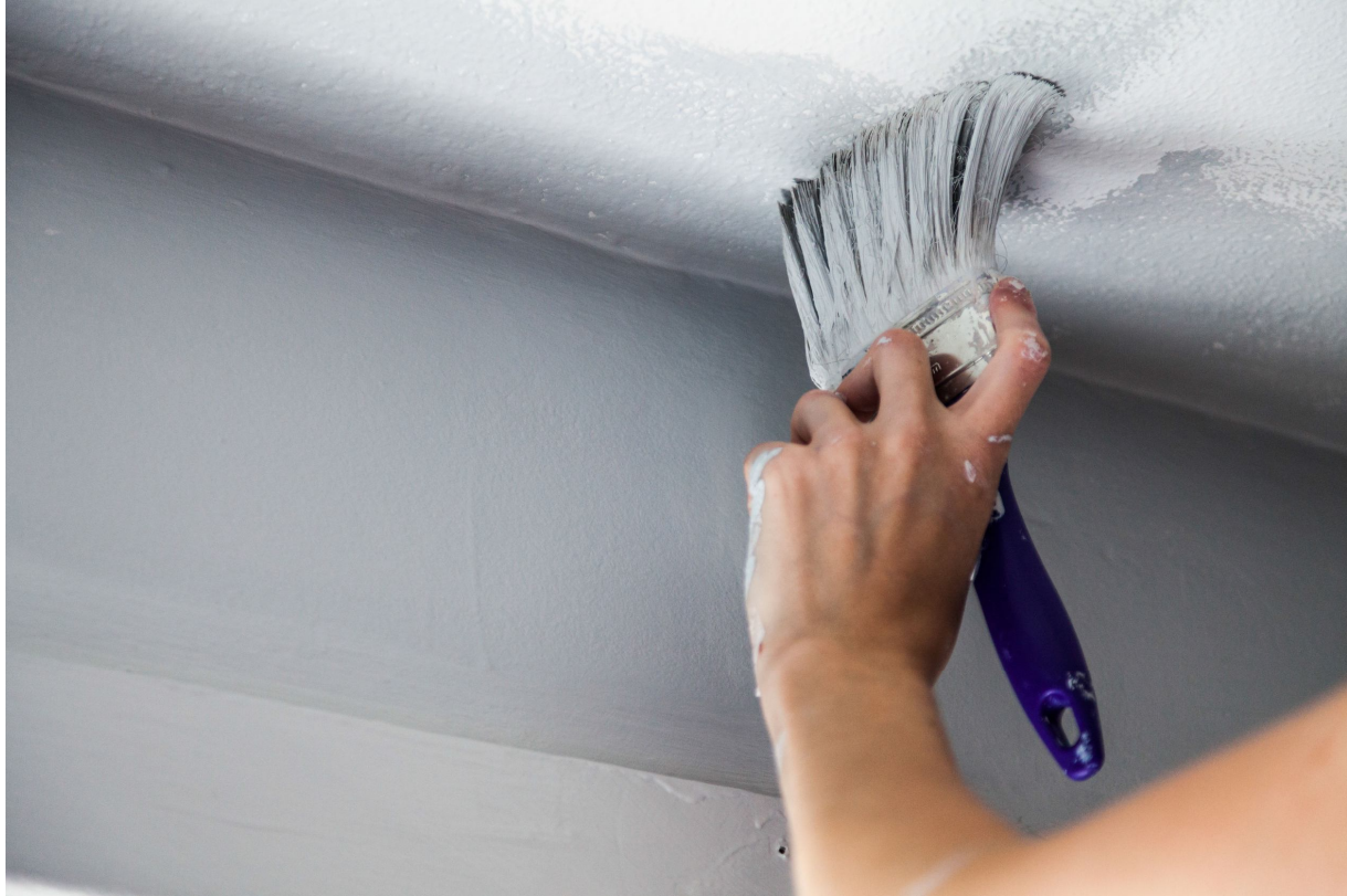
Рисунок 4.8 – Забарвлення стелі вапняними складами за допомогою макловиці
