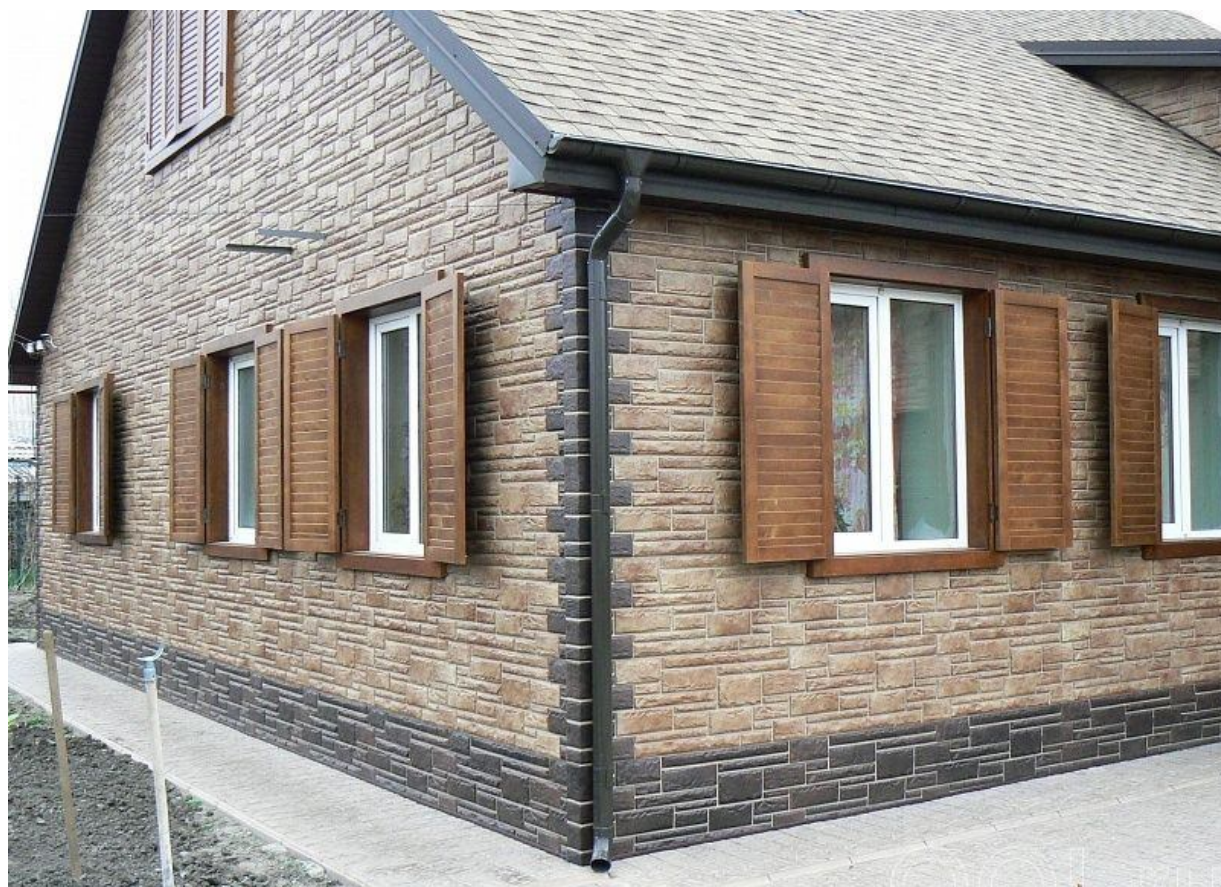
Рисунок 7.54 – Обличкування фасаду поліпропіленовими панелями
