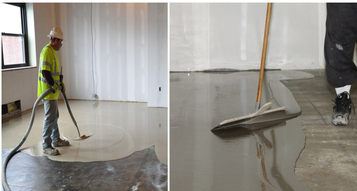
Рисунок 6.29 – Улаштування наливної підлоги
