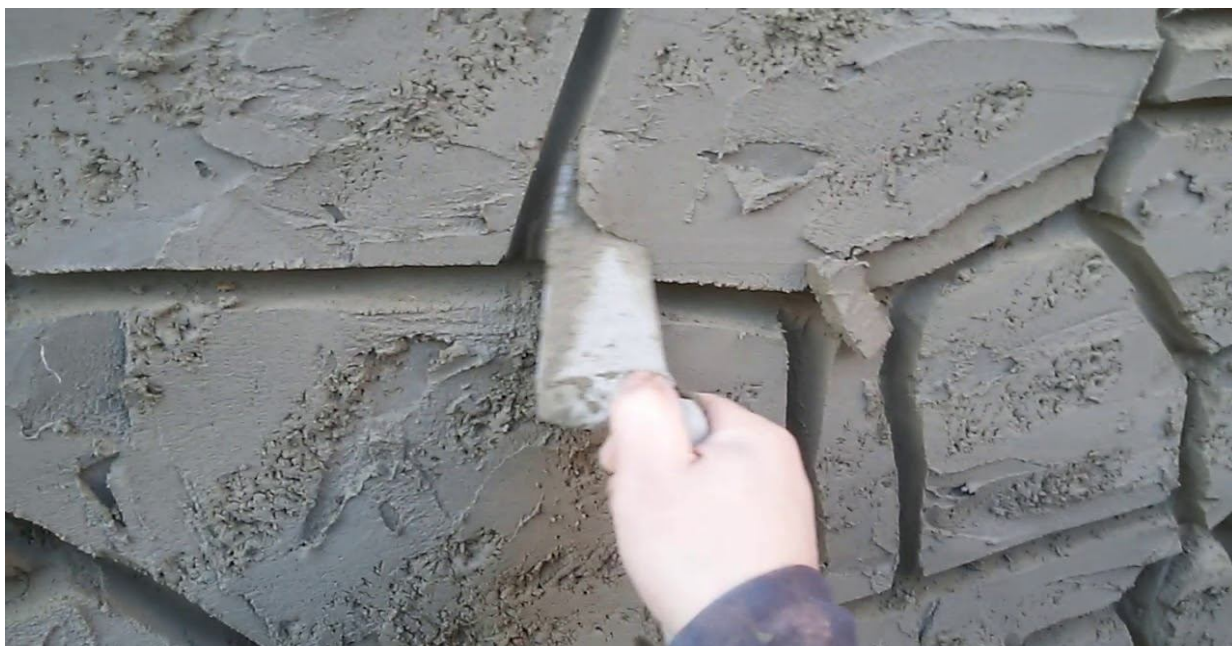
Рисунок 3.29 – Улаштування тинькування під камінь
