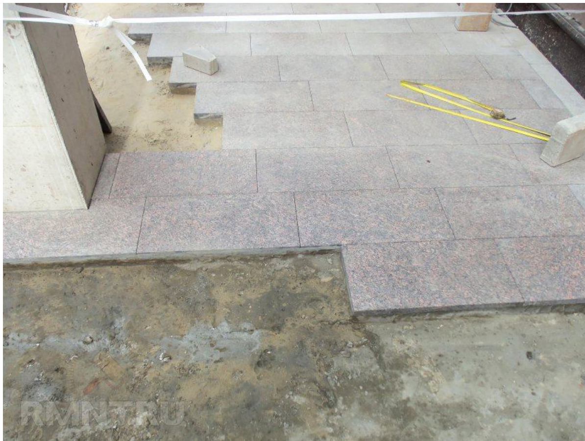
Рисунок 6.20 – Укладання відполірованих гранітних плит на розчин
