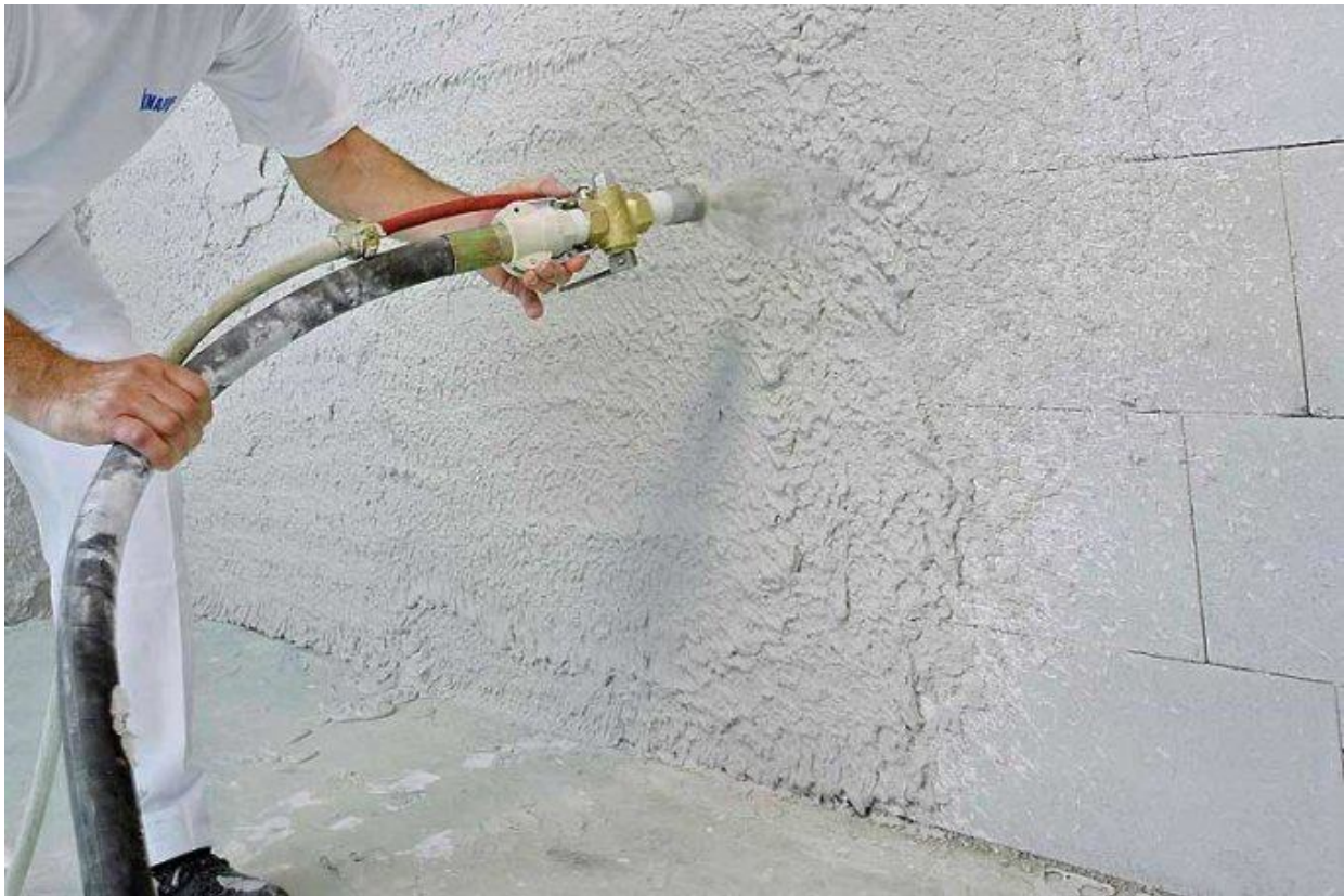
Рисунок 3.32 – Нанесення розчину рівномірними рухами форсунки
