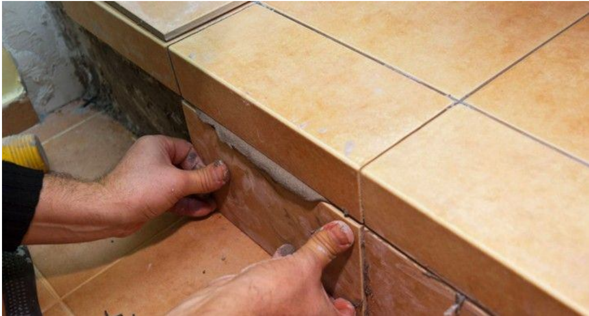
Рисунок 6.8 – Укладання плитки на східці
