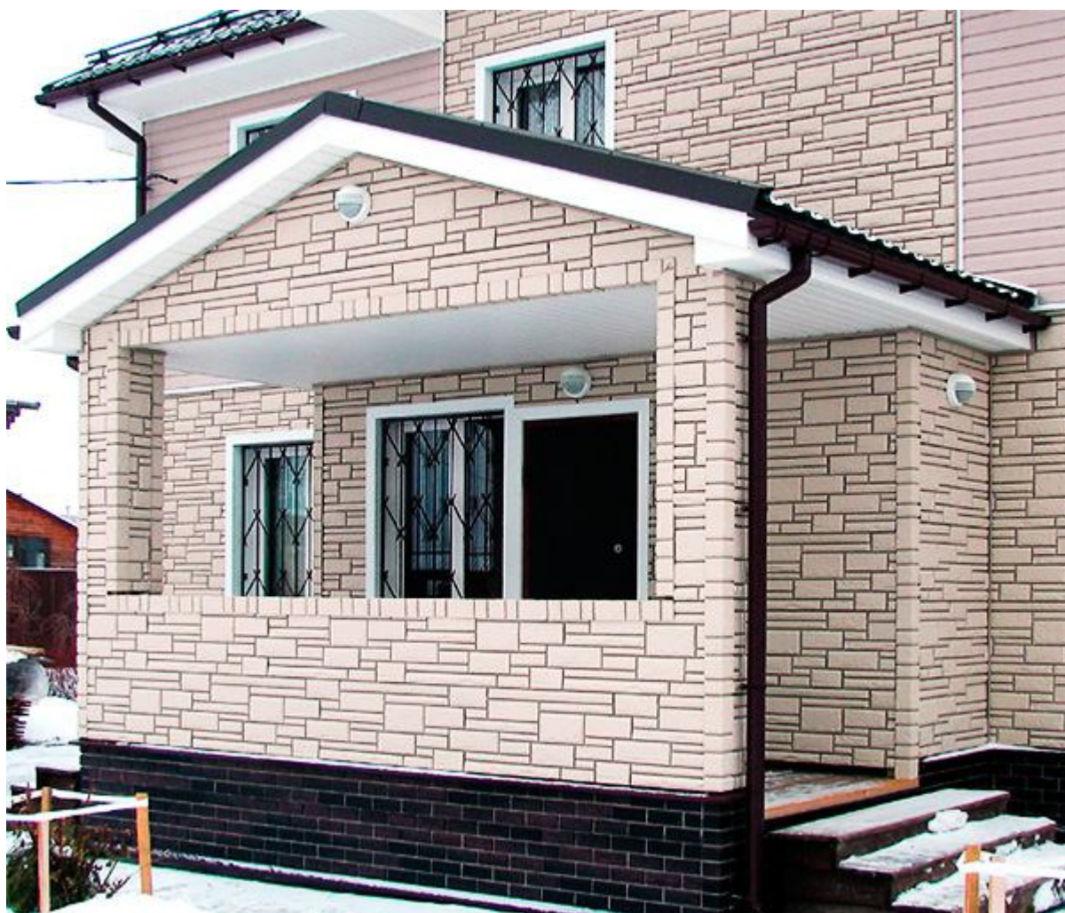
Рисунок 7.56 – Облицювання фасаду поліуретановими панелями
