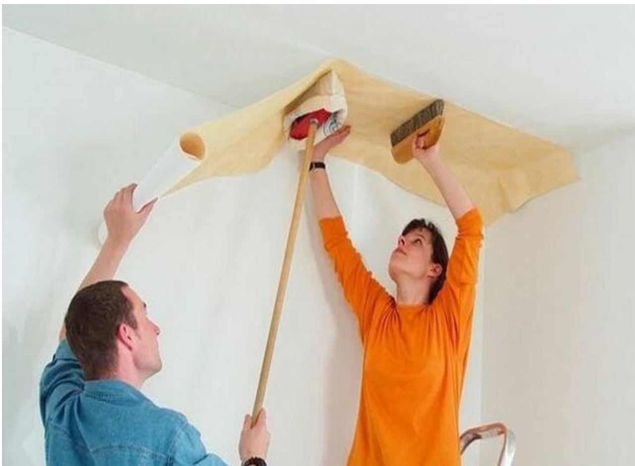
Рисунок 4.26 – Приклеювання шпалер на стелі
