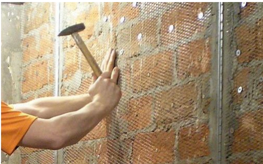
Рисунок 3.2 – Набиття металевої сітки на стіну під тинькування
