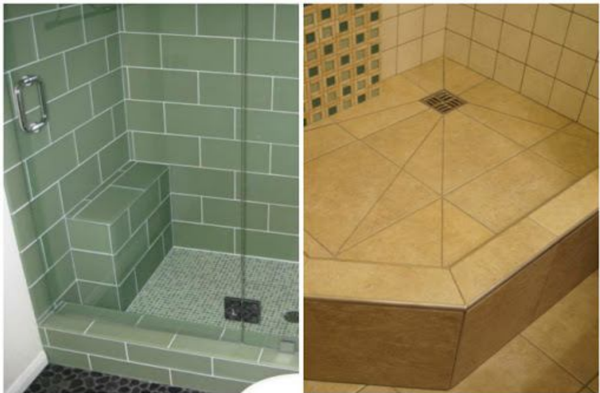
Рисунок 6.14 – Улаштування піддонів для душової kabіни
