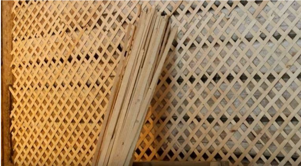
Рисунок 3.1 – Набиття дранки на стіну під тинькування
