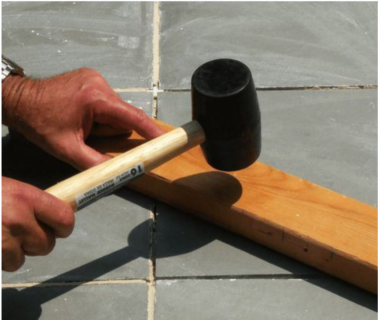
Рисунок 6.24 – Улаштування сланцевої підлоги
