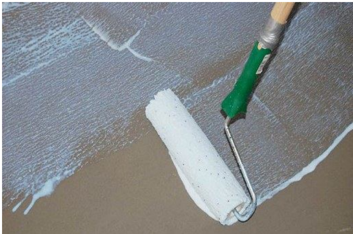
Рисунок 6.39 – Ґрунтування основи для лінолеуму
