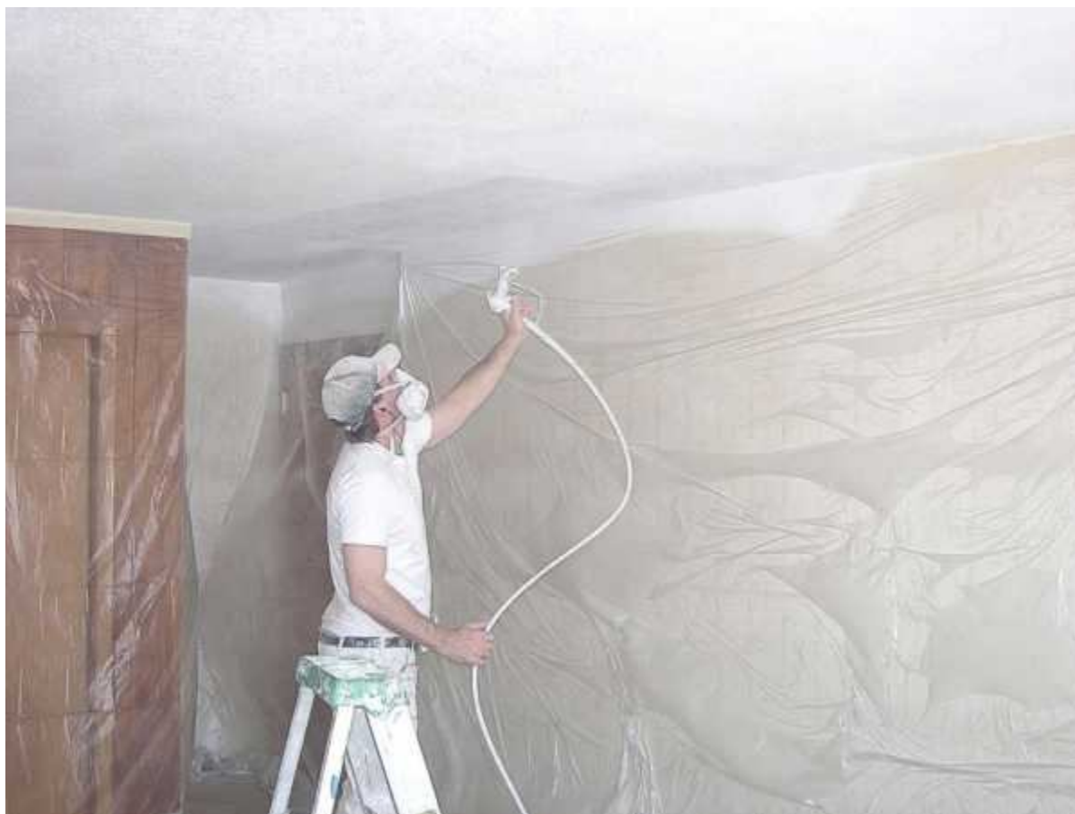
Рисунок 4.7 – Забарвлення стелі клейовими складами за допомогою ручних фарбопультів
