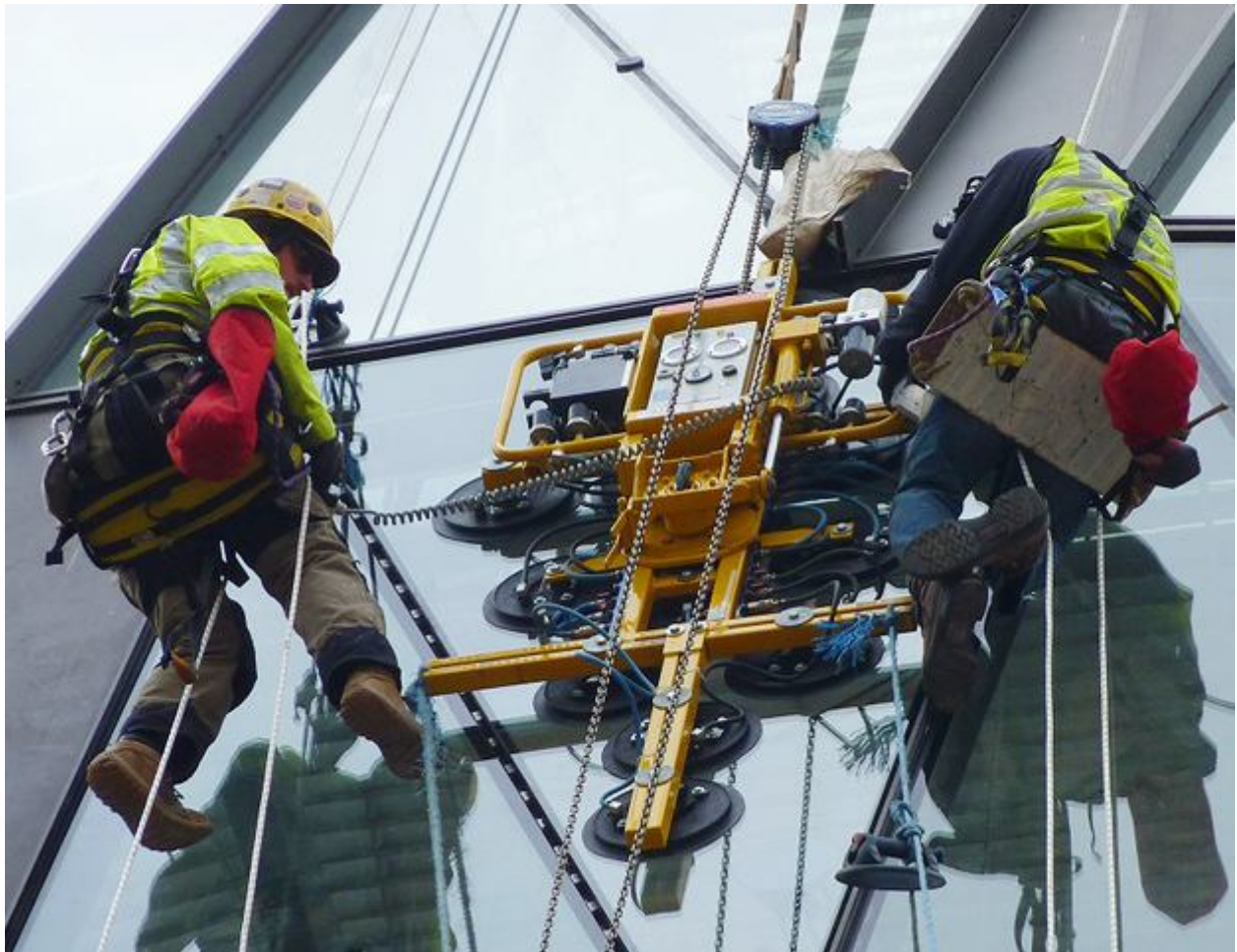
Рисунок 7.69 – Зведення фасадної профільної конструкції
