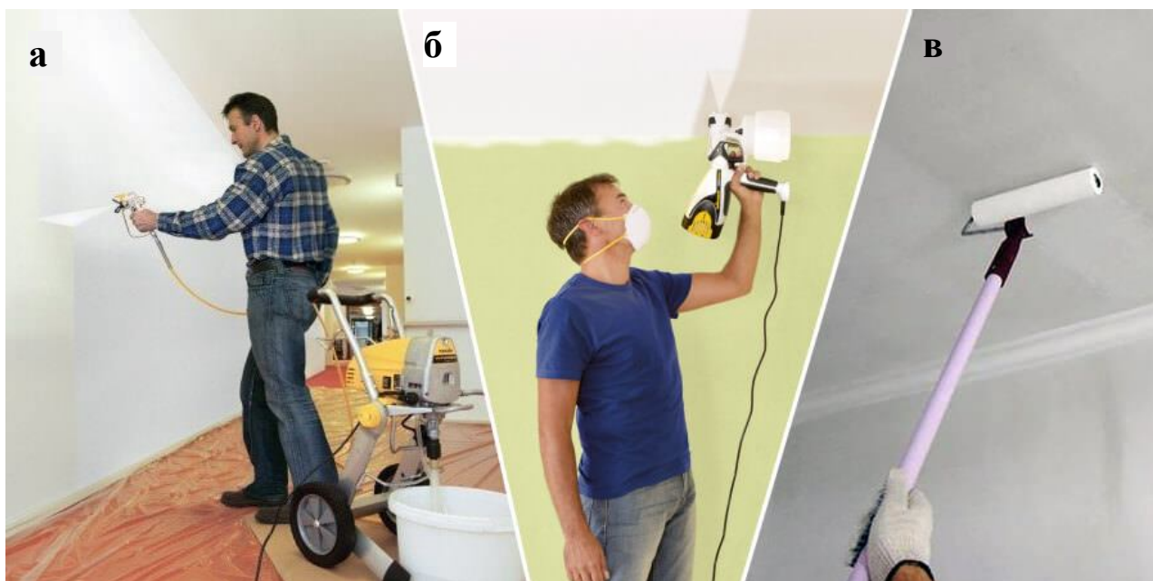
Рисунок 4.9 – Забарвлення стін та стелі масляними складами за допомогою: а, б – пістолетами-фарборозпилювача; в – валика
