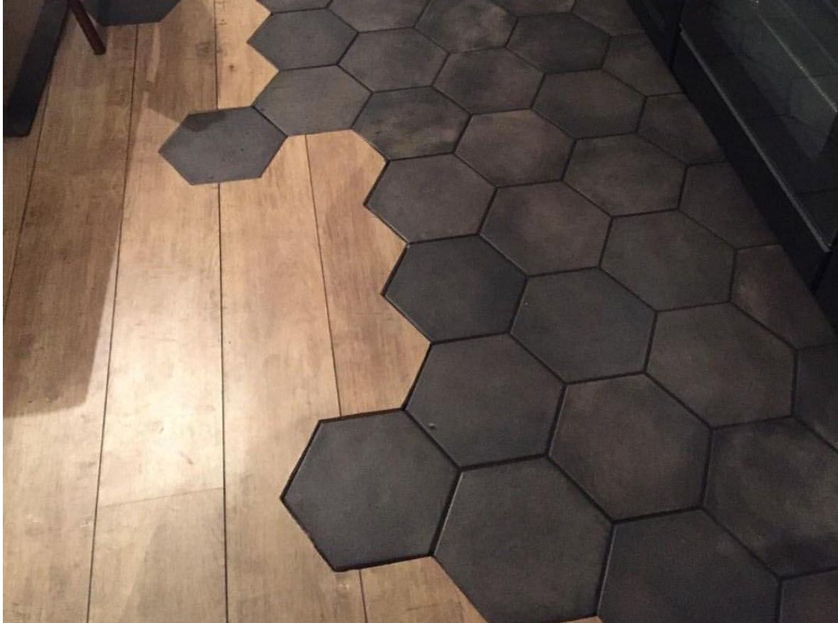
Рисунок 6.11 – Настеляння підлоги багатограними плитками
