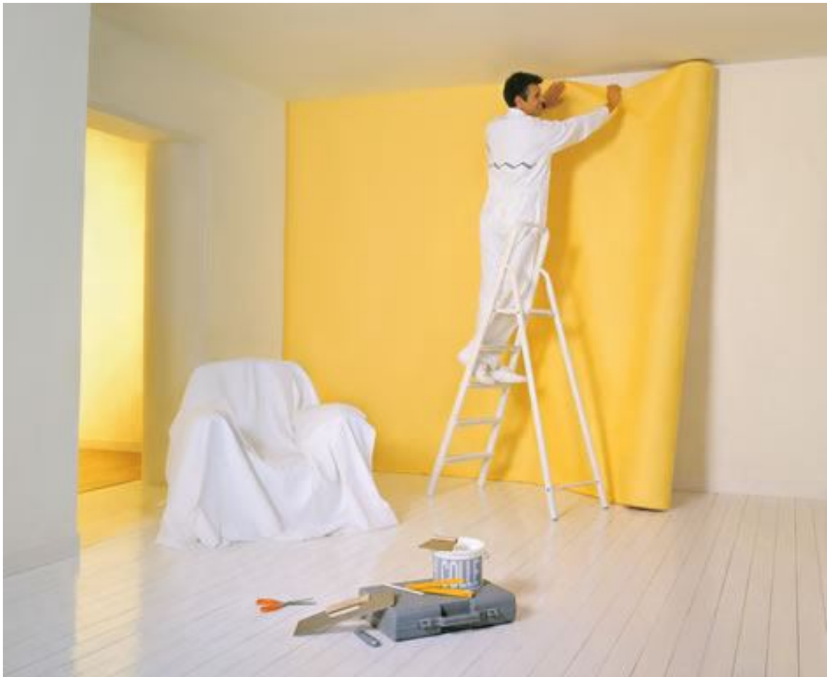
Рисунок 4.28 – Улаштування безшовних тканинних стінних покриттів
