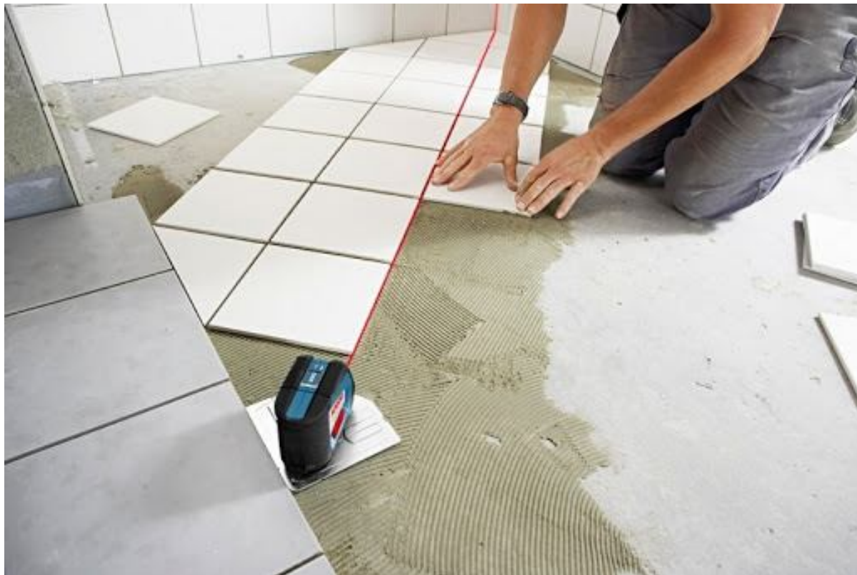
Рисунок 6.10 – Укладання плитки способом «по діагоналі»
