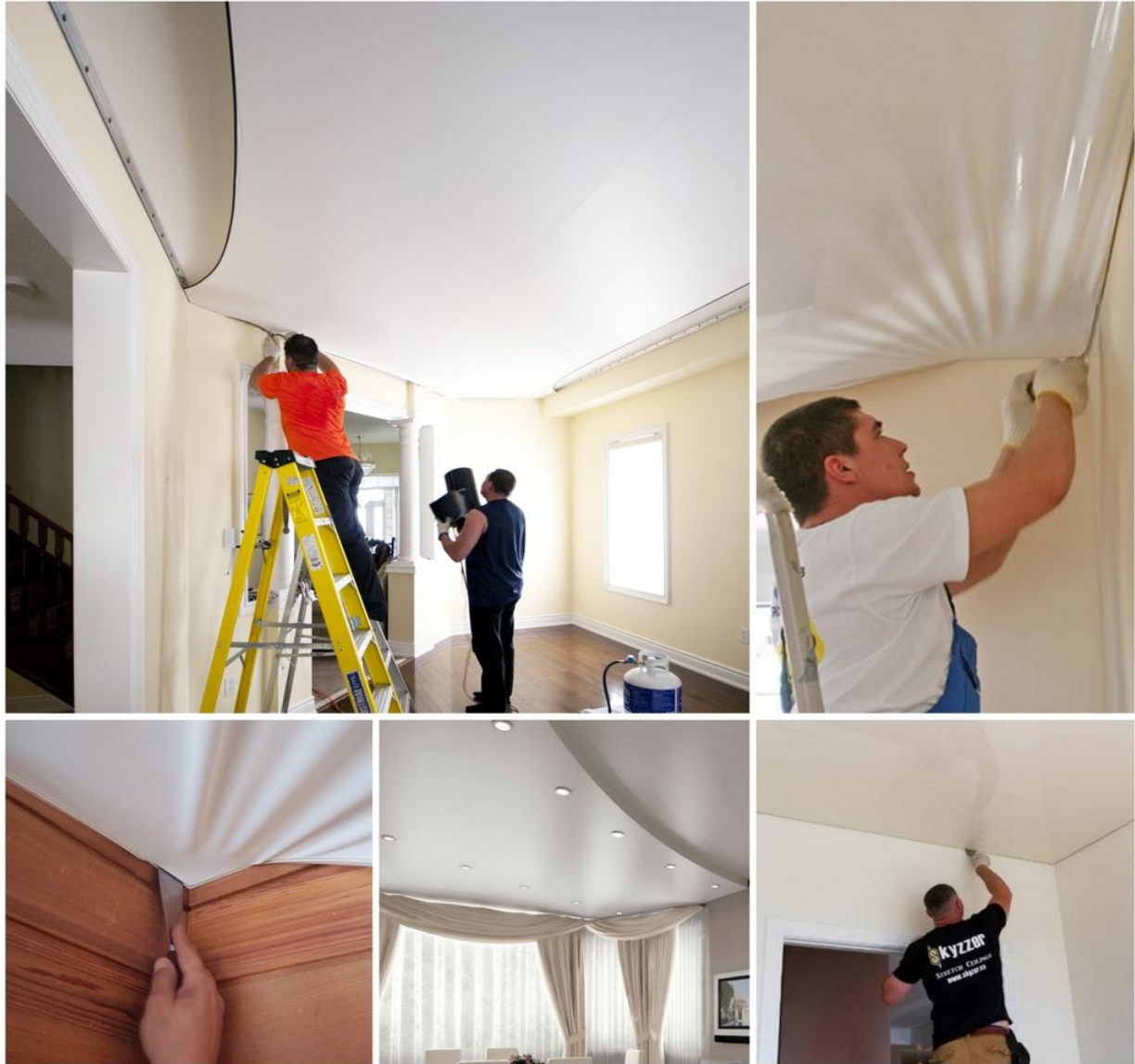
Рисунок 5.22 – Установлення натяжних стель
