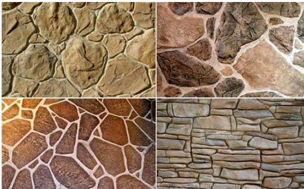
Рисунок 3.28 – Каменеподібні тинькування
