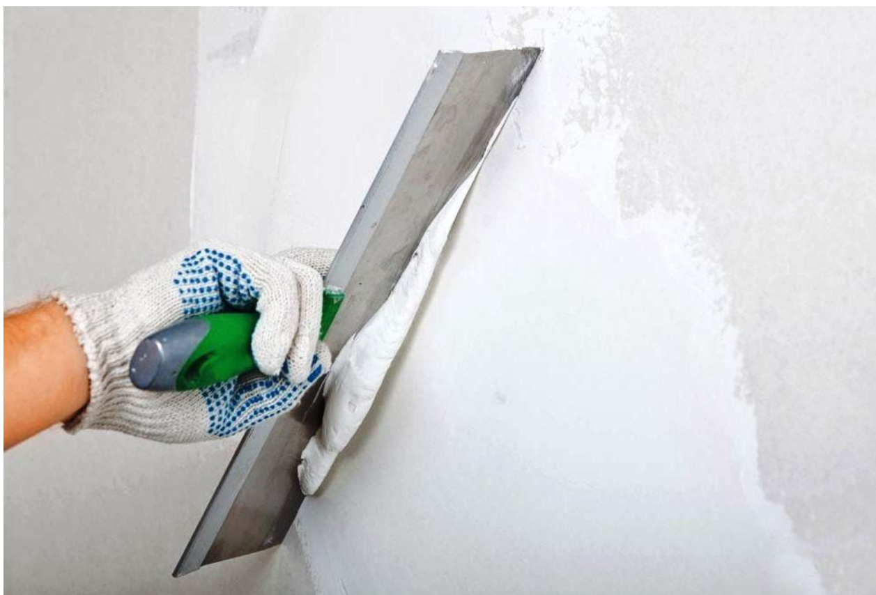
Рисунок 4.4 – Шпаклювання поверхонь
