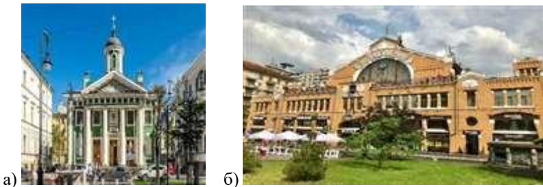
Рисунок 1 – Будівлі з підсиленими фундаментами: а) церква Св. Марії в Санкт-Петербурзі; б) будівля Бессарабського ринку
