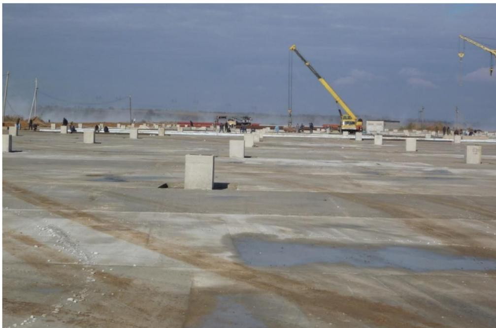
Рис. 2 Возведение плиты и опор труб бассейна на ЮжАЭС
