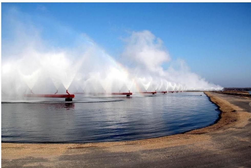
Рис. 1 Общий вид действующего брызгального бассейна
