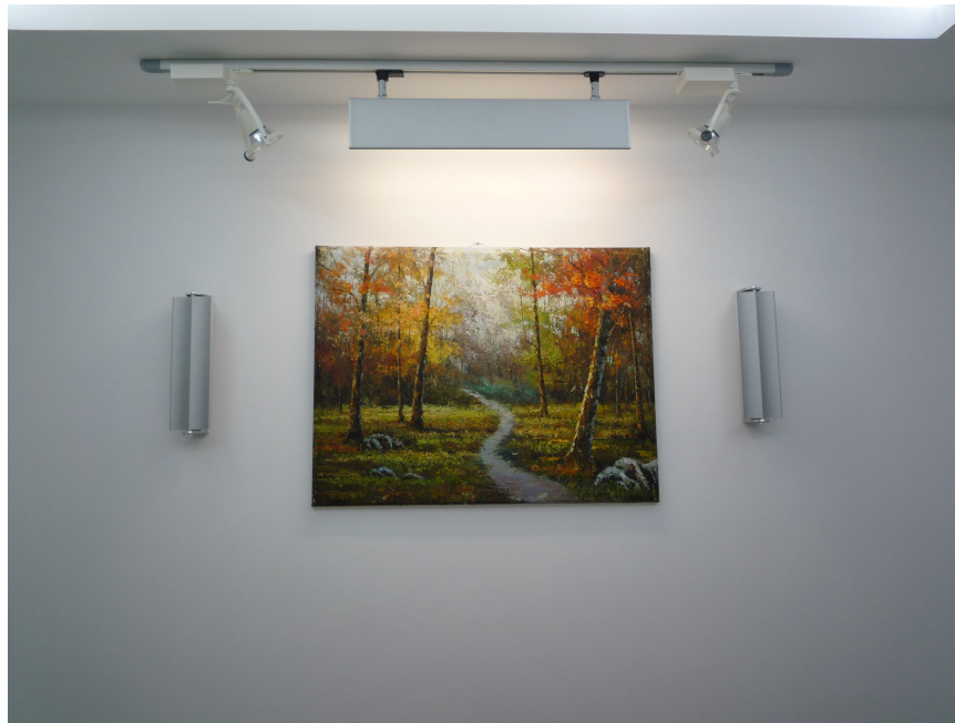
Рисунок 3.5 – Варіант освітлення картини: верхня система освітлення
