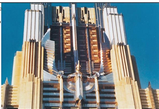
Рис. 3.3.6. Типологические разновидности пластического языка стиля Ар Деко в отечественной архитектуре. Ретроспективно-орнаментальный тип.
