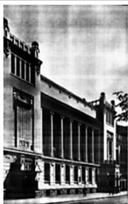
163. Купеческий клуб на ул. М. Димитровке в Москве. 1907-1908 гг. Арх. И.А. Иванов-Шиц.
