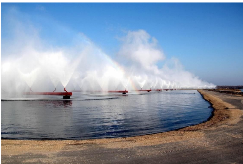
Рис. 1 Общий вид действующего брызгального бассейна
