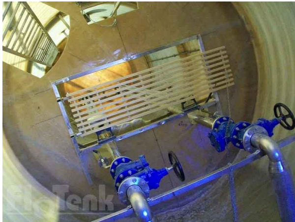
Рисунок 15.4 – Встановлення самовсмоктуючих насосів у КНС з полімерних матеріалів (а) та горизонтальне розміщення КНС (б)
