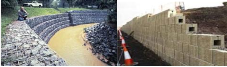
Рисунок 4 – Сучасні підпірні стіни
