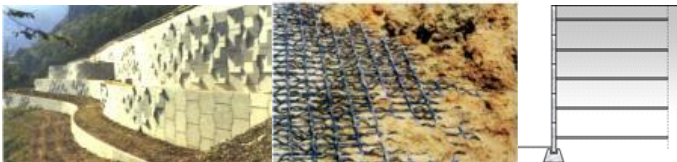
Рисунок 3 – Підпірна стіна з армованим ґрунтом
