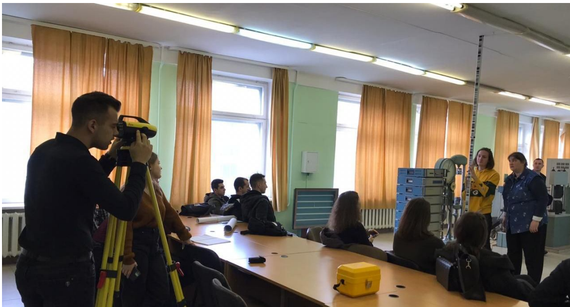
Рисунок 7 – Вимірювання початкових прогинів перекриття по центру плити за допомогою нівеліра
