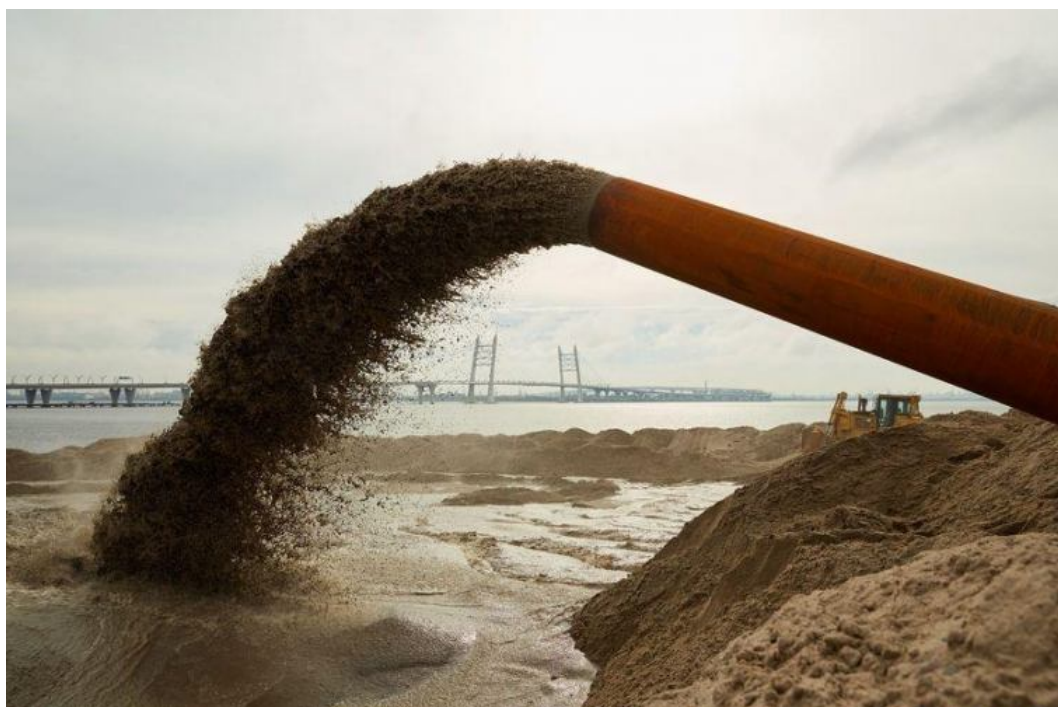
Рисунок 8.1 – Намив ґрунту
