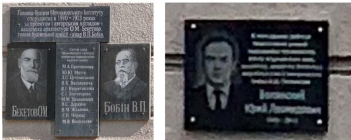
Рисунок Б.8 – Фотофіксація об'єкта: фрагменти деталей фасадів будівлі та меморіальні дошки
