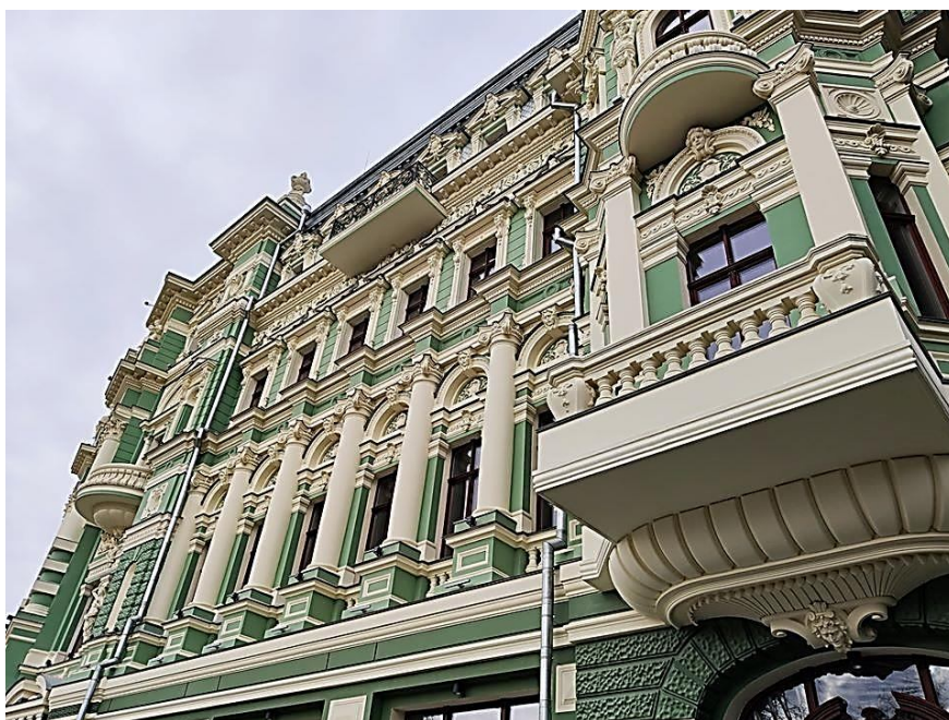
Рис. Фрагмент фасаду будинку А. Руссова в Одесі після реставрації. Грудень 2019 р. Світлина В. Богатирьова
