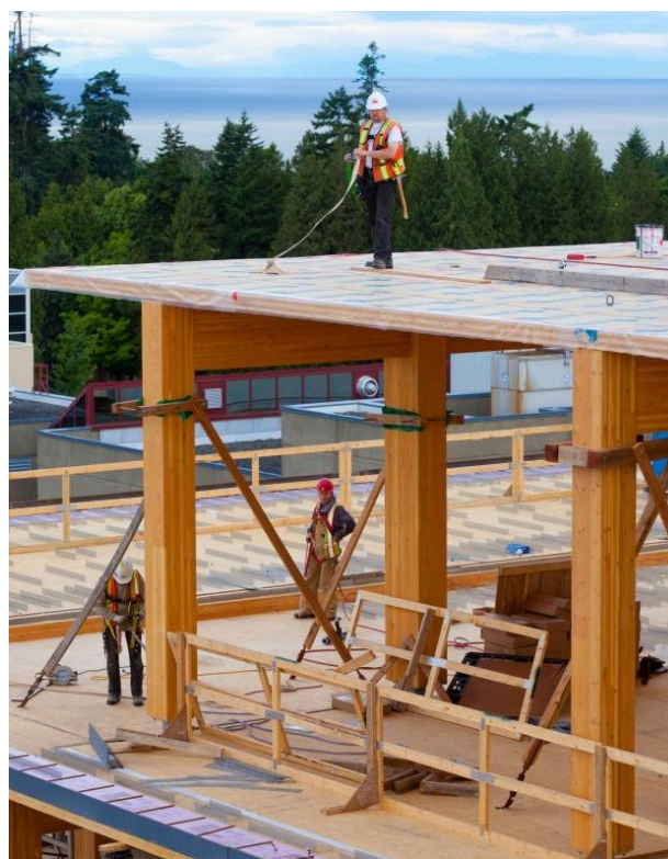
Рис. 1. Будівля з ПКД панелей у Канаді, 17 поверхів
