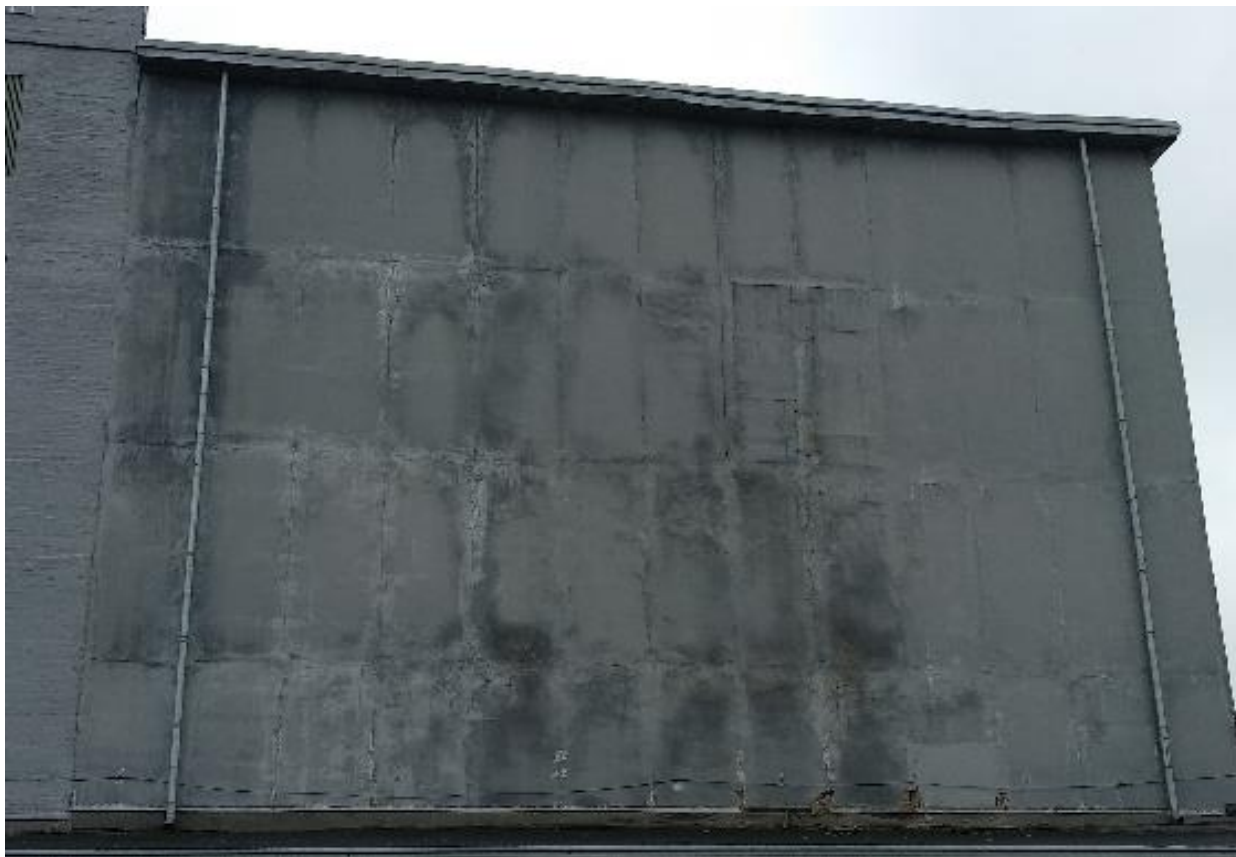
Рис. 1. Замокання вирячених стінових панелей
